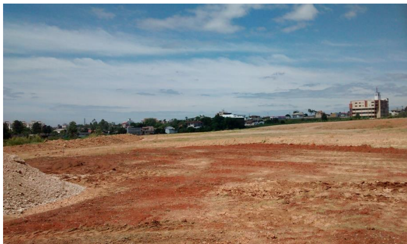
Figura 08: Serviços de terraplanagem no Parque dos Imigrantes. (Fonte: Dos autores 2015)
