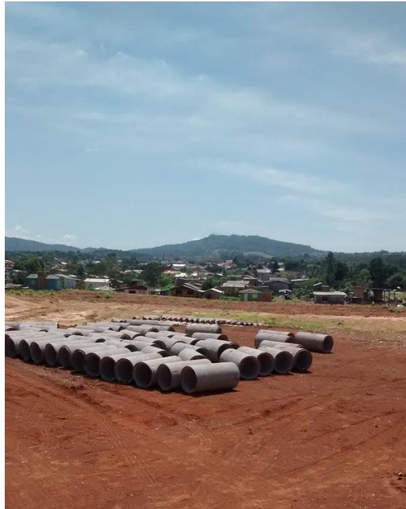
Figura 07: Drenos para construção do sistema de drenagem. (Fonte: Dos autores 2015)
