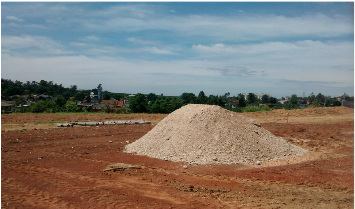
Figura 10: Serviços de terraplanagem no Parque dos Imigrantes. (Fonte: Dos autores 2015)
