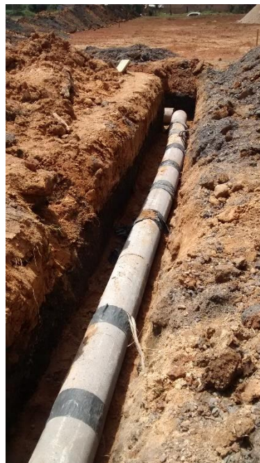
Figura 06: Obras de drenagem Parque dos Imigrantes. (Fonte: Dos autores 2015)
