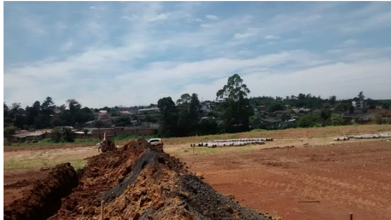
Figura 05: Obras de drenagem Parque dos Imigrantes. (Fonte: Dos autores 2015)
