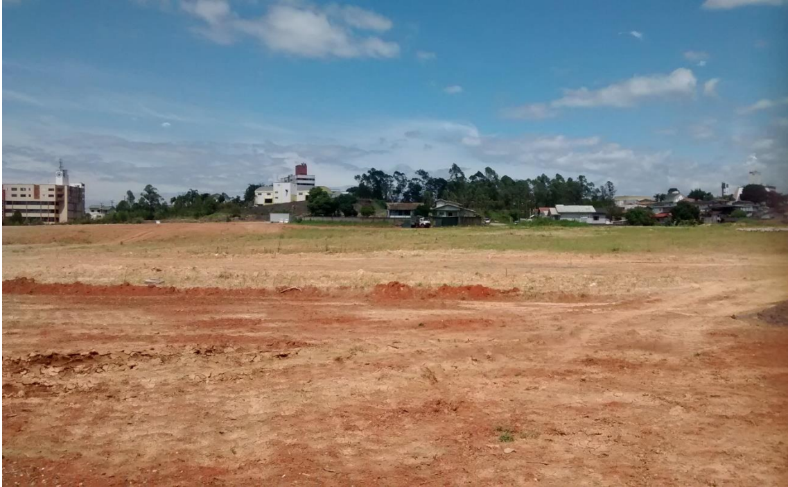
Figura 09: Serviços de terraplanagem no Parque dos Imigrantes. (Fonte: Dos autores 2015)
