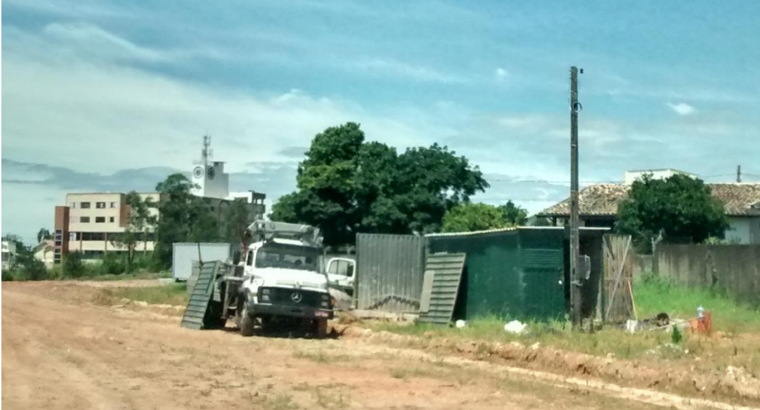
Figura 11: Instalação da empresa responsável pela execução da obra. (Fonte: Dos autores 2015)
