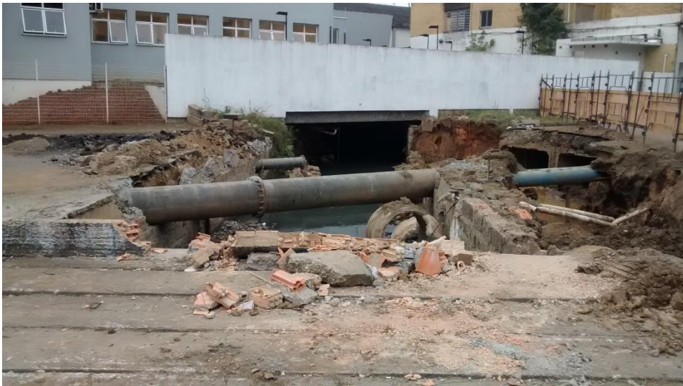
Figura 07: Retirada do revestimento da Rua Vitório Serafim. (Fonte: Dos autores 2016)
