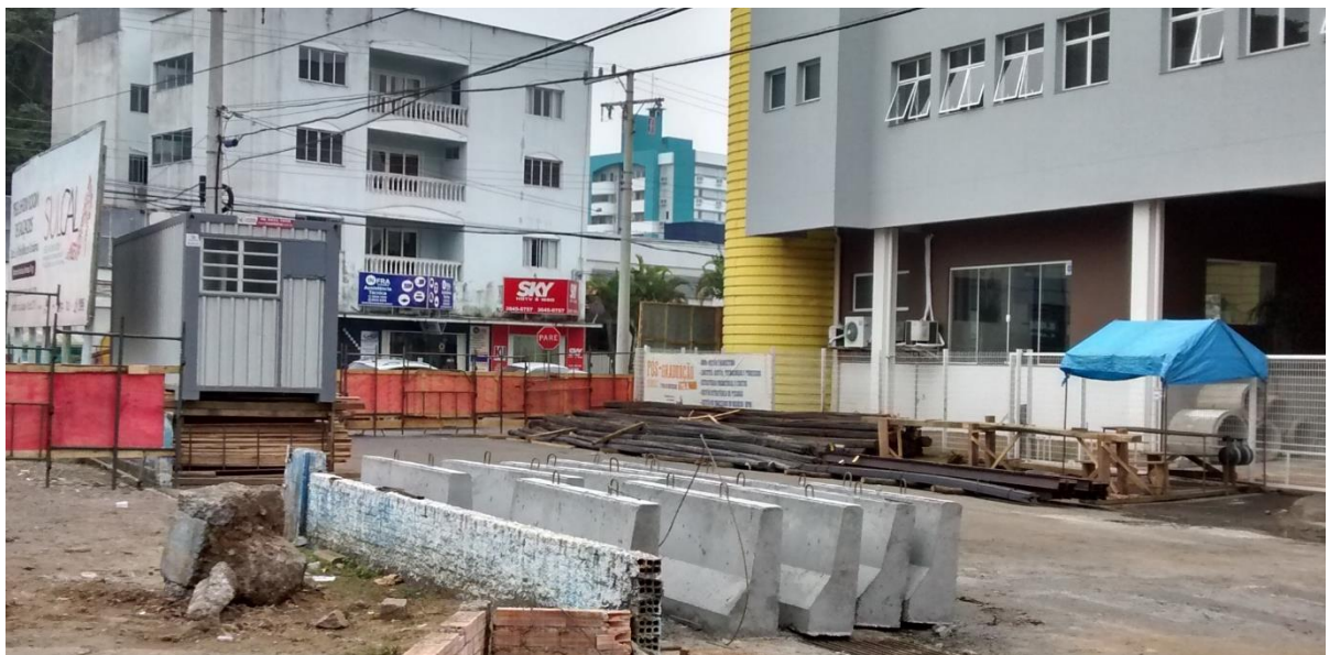
Figura 06: Instalações do canteiro de obras. (Fonte: Dos autores 2016)
