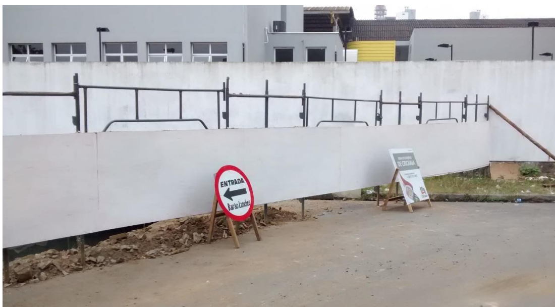
Figura 05: Isolamento da área a ser executada as obras. (Fonte: Dos autores 2016)
