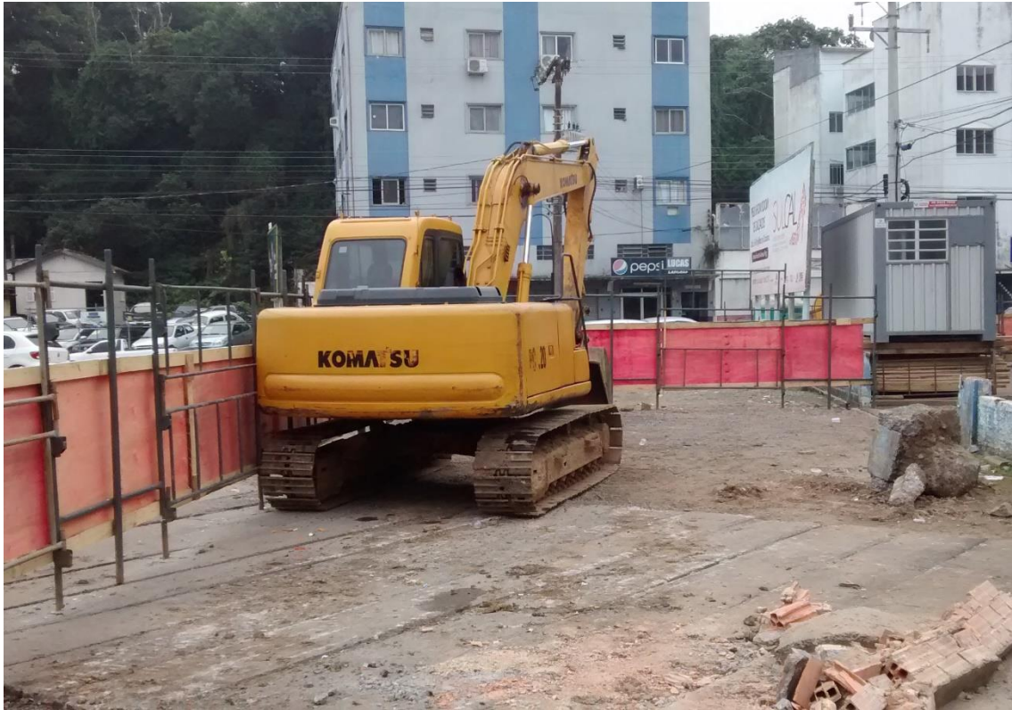
Figura 11: Equipamento utilizado na obra paralisado. (Fonte: Dos autores 2016)
