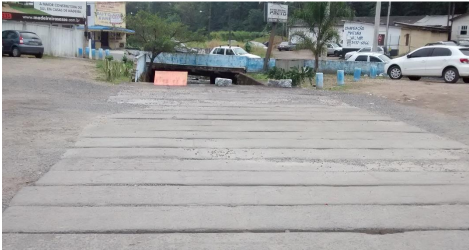
Figura 12: Local a ser demolido para a construção do Canal Auxiliar. (Fonte: Dos autores 2016)
