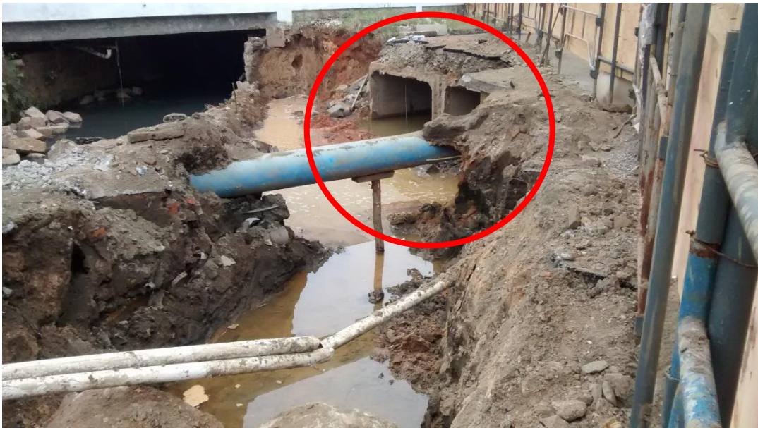
Figura 09: Detalhe do final da 1ª etapa do Canal Auxiliar. (Fonte: Dos autores 2016)
