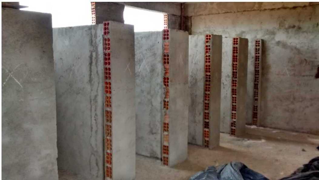
Figura 06: Área interna do sanitário masculino. (Fonte: Dos autores 2016)
