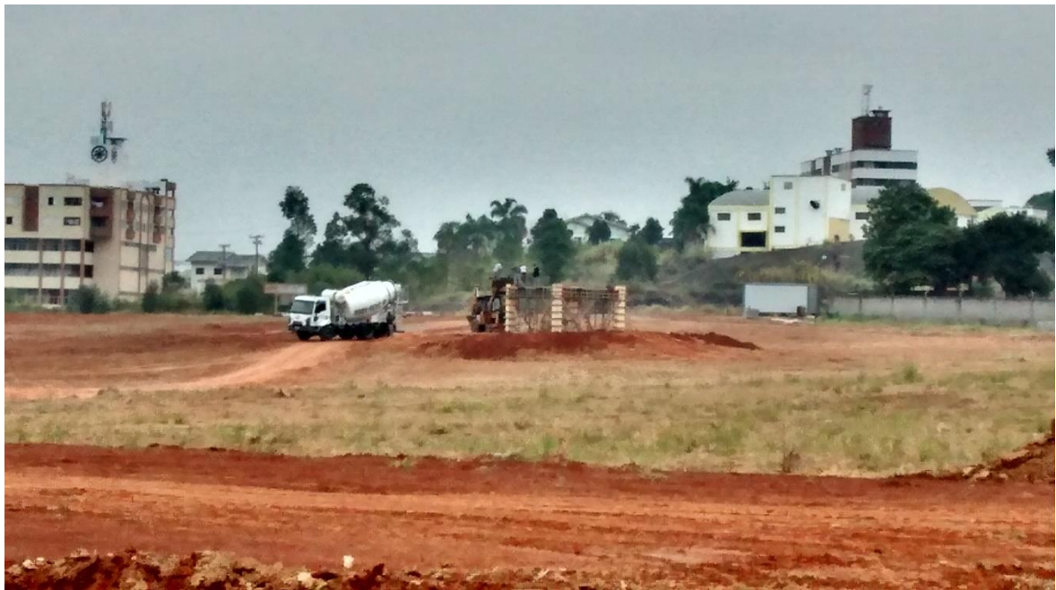
Figura 37: Construção da estrutura que abrigará o reservatório. (Fonte: Dos autores 2016)
