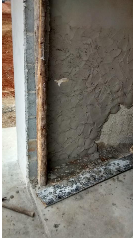
Figura 18: Emboco sendo executado na subestação. (Fonte: Dos autores 2016)
