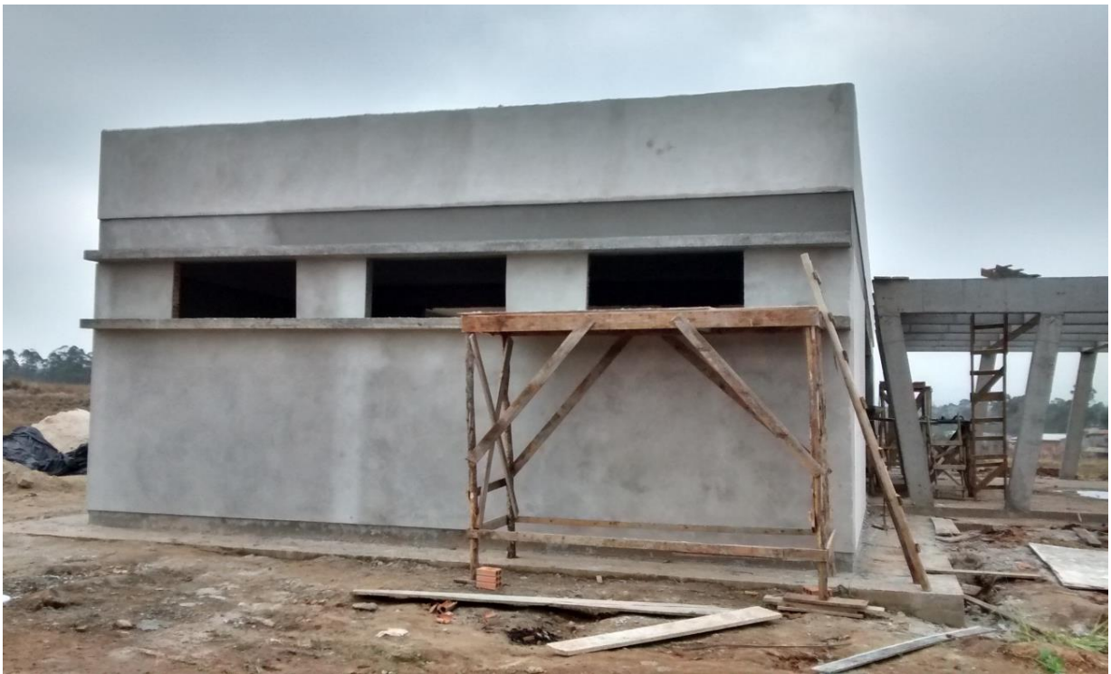
Figura 10: Vista lateral dos sanitários e estar. (Fonte: Dos autores 2016)
