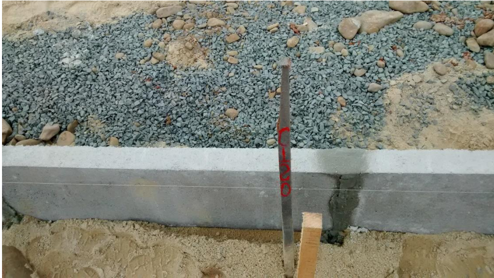
Figura 22: Assentamento dos meios-fios. (Fonte: Dos autores 2016)
