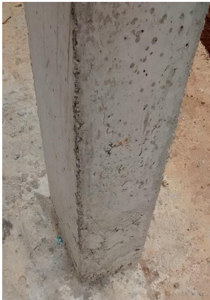
Figura 50: Bicheira estrutura do pergolado. (Fonte: Dos autores 2016)
