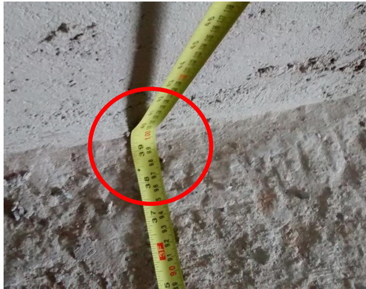
Figura 14: Verificação da largura dos sanitários. (Fonte: Dos autores 2016)
