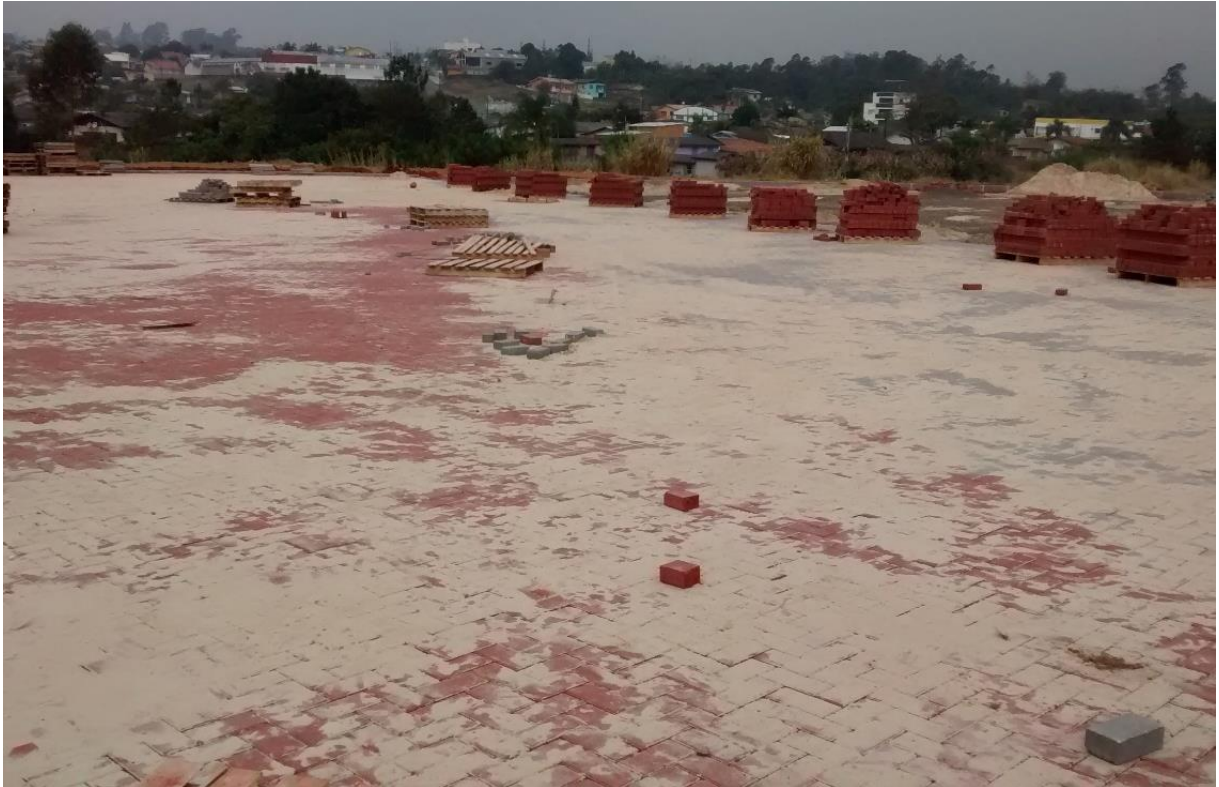
Figura 26: Aplicação de areia fina para rejunte dos blocos. (Fonte: Dos autores 2016)
