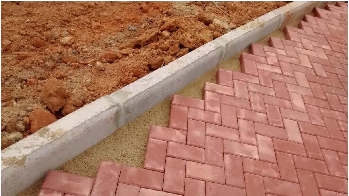
Figura 33: Meios-fios já assentados. (Fonte: Dos autores 2016)
