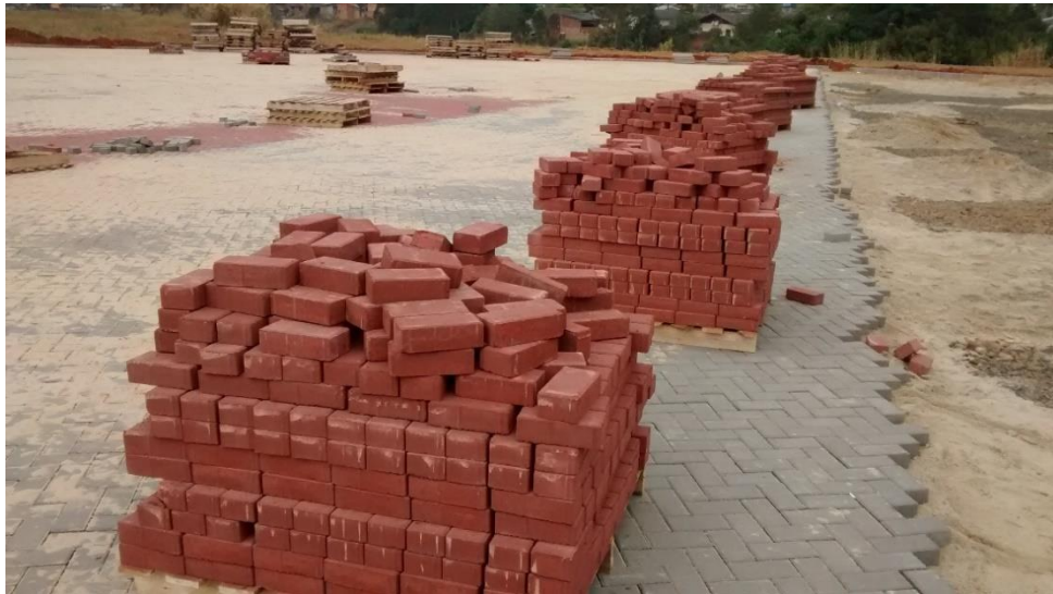
Figura 28: Blocos de concreto tipo paver utilizados no revestimento da área de convivência. (Fonte: Dos autores 2016)
