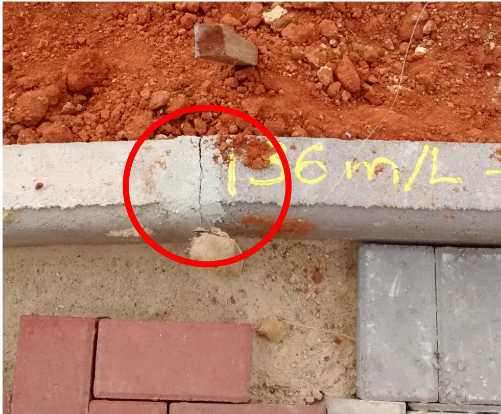
Figura 62: Falta de aderência entre a argamassa e o bloco de meio-fio. (Fonte: Dos autores 2016)
