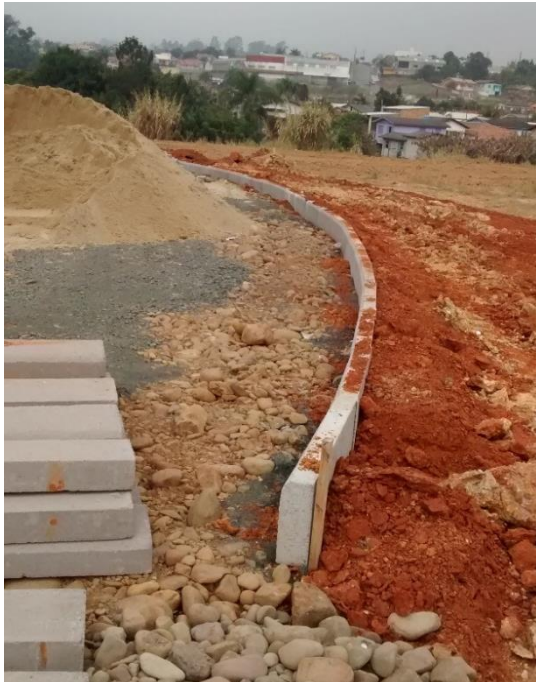
Figura 30: Assentamento dos meios-fios. (Fonte: Dos autores 2016)
