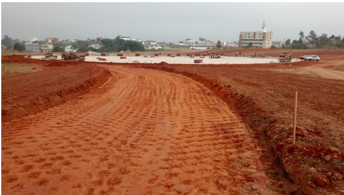
Figura 34: Execução dos caminhos. (Fonte: Dos autores 2016)
