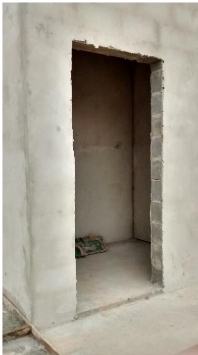
Figura 17: Porta de acesso a subestação. (Fonte: Dos autores 2016)
