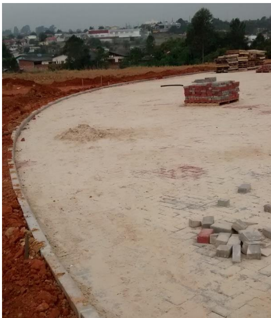
Figura 31: Meios-fios já assentados. (Fonte: Dos autores 2016)
