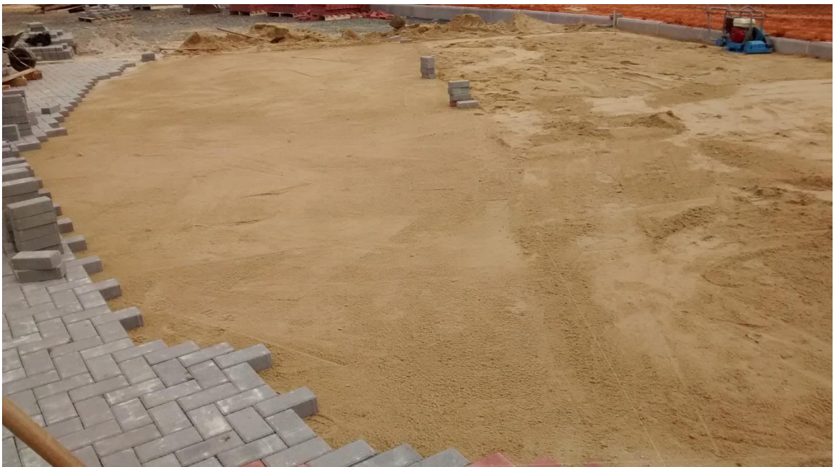
Figura 25: Assentamento dos blocos de concreto tipo paver. (Fonte: Dos autores 2016)
