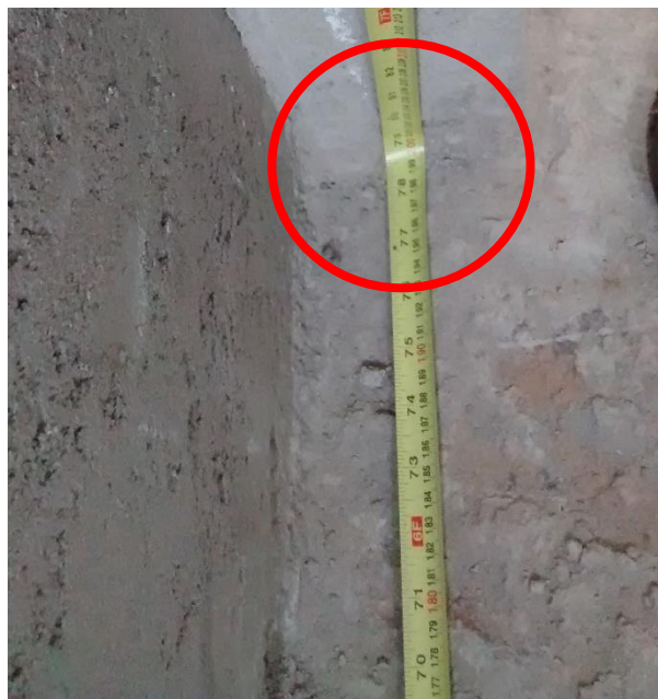
Figura 15: Verificação do comprimento dos sanitários. (Fonte: Dos autores 2016)
