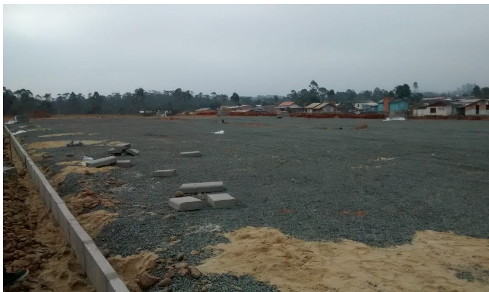
Figura 21: Execução da camada de sub-base de brita. (Fonte: Dos autores 2016)
