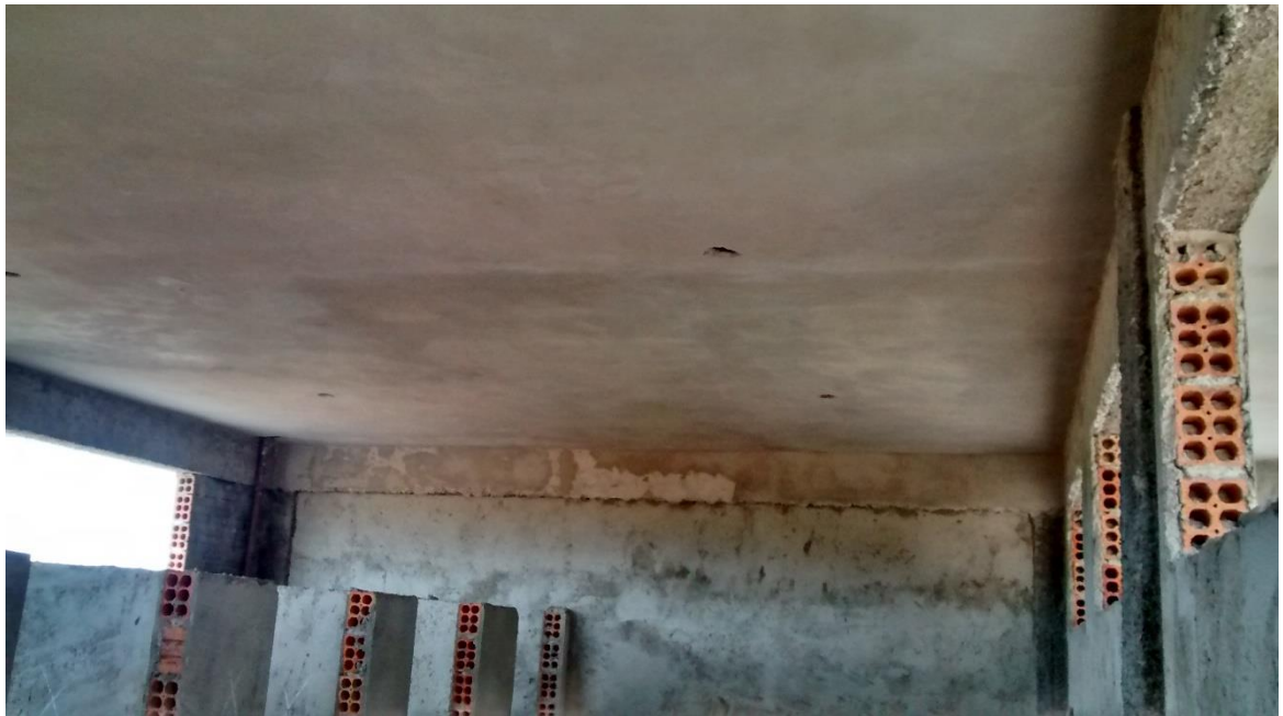
Figura 12: Teto área interna sanitários. (Fonte: Dos autores 2016)
