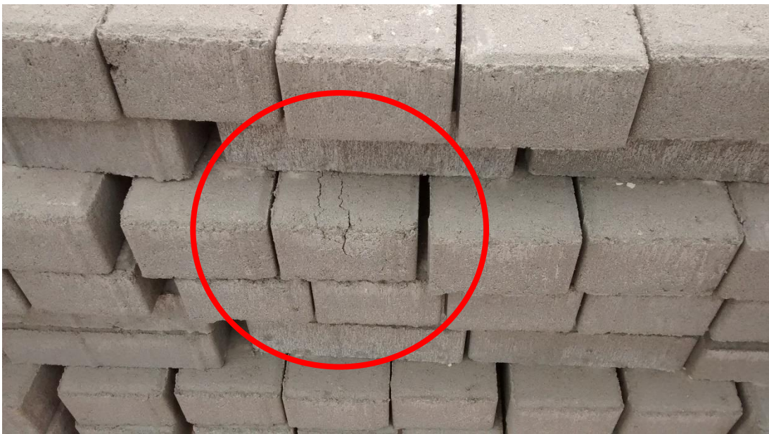
Figura 57: Bloco de concreto tipo paver danificado. (Fonte: Dos autores 2016)
