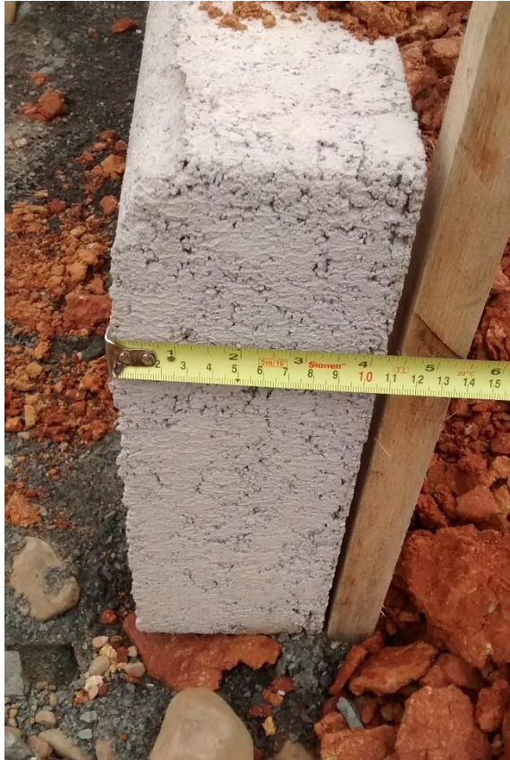
Figura 32: Verificação da dimensão do meio-fio já assentado. (Fonte: Dos autores 2016)
