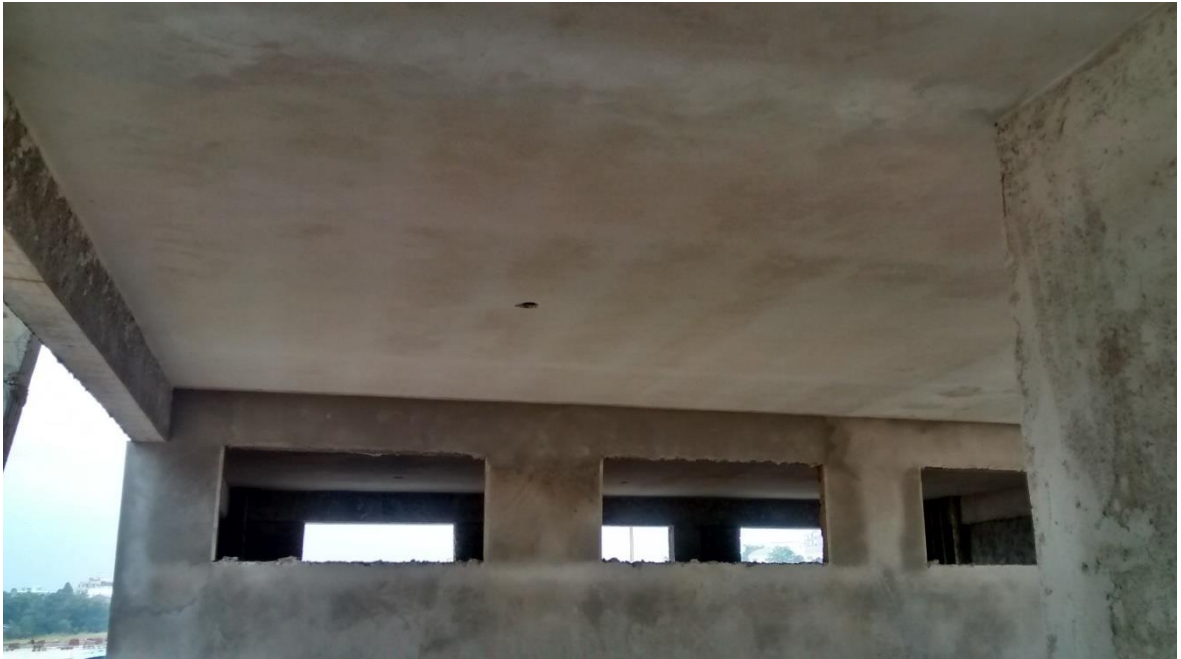
Figura 11: Teto área externa sanitários e estar. (Fonte: Dos autores 2016)
