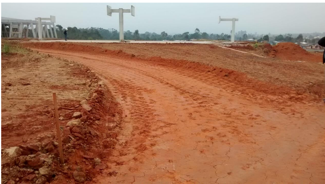
Figura 35: Execução dos caminhos. (Fonte: Dos autores 2016)
