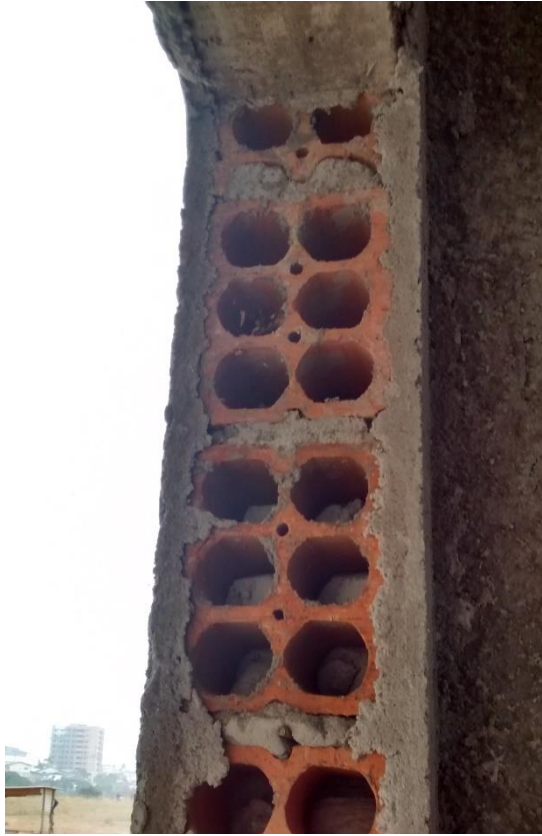
Figura 07: Detalhe revestimento da alvenaria. (Fonte: Dos autores 2016)
