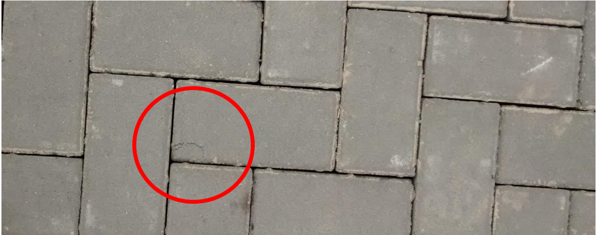
Figura 60: Bloco danificado utilizado. (Fonte: Dos autores 2016)
