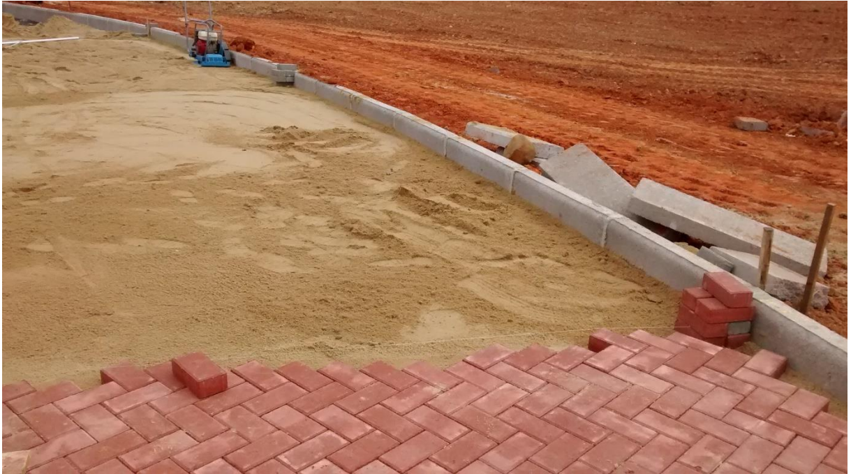
Figura 24: Assentamento dos blocos de concreto tipo paver. (Fonte: Dos autores 2016)
