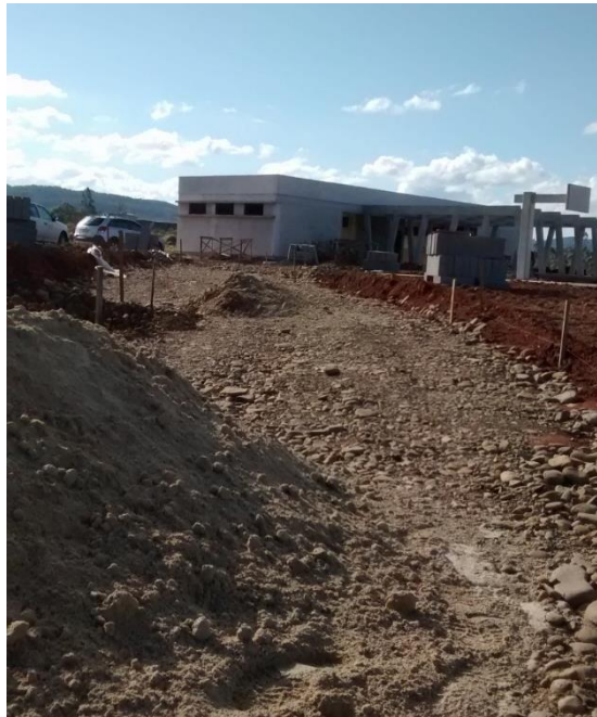
Figura 23: Execução da sub-base e do colchão de areia média. (Fonte: Dos autores 2016)
