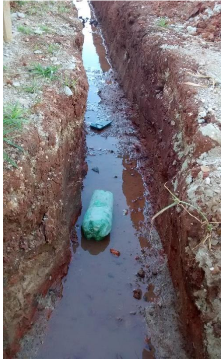
Figura 13: Vala para passagem da tubulação de esgoto. (Fonte: Dos autores 2016)
