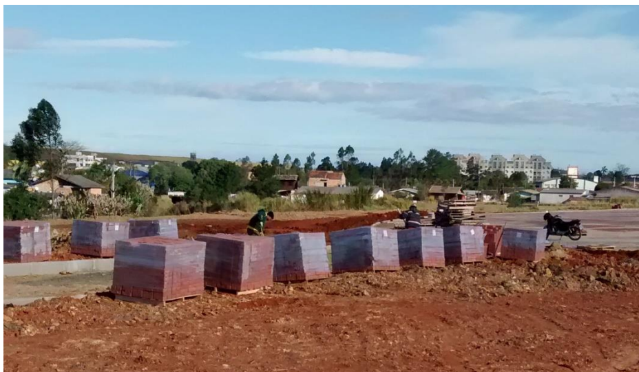
Figura 19: Execução da pavimentação de um dos caminhos. (Fonte: Dos autores 2016)
