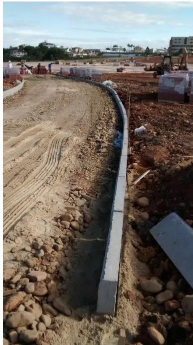
Figura 21: Assentamento dos blocos de meios-fios. (Fonte: Dos autores 2016)
