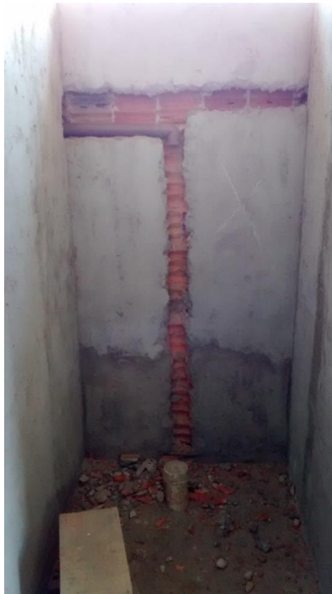
Figura 10: Passagem para tubulação em um dos sanitários. (Fonte: Dos autores 2016)
