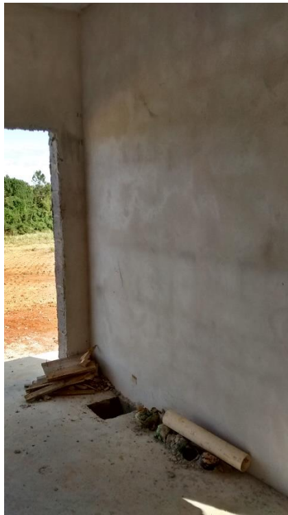
Figura 30: Acabamento da estrutura de alvenaria da subestação. (Fonte: Dos autores 2016)
