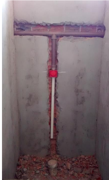
Figura 05: Tubulação de um dos sanitários instalada. (Fonte: Dos autores 2016)
