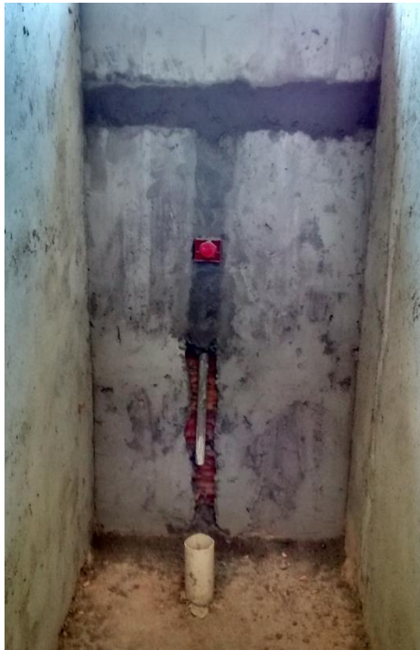
Figura 07: Tubulação de um dos sanitários instalada. (Fonte: Dos autores 2016)
