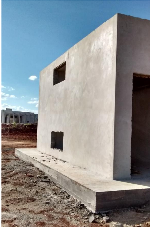
Figura 29: Acabamento da estrutura de alvenaria da subestação. (Fonte: Dos autores 2016)
