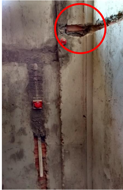
Figura 42: Quebra do pilar para execução da passagem de tubulações. (Fonte: Dos autores 2016)
