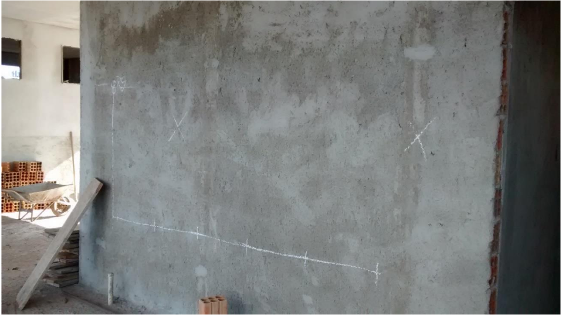
Figura 09: Demarcação dos locais aonde serão executadas passagens para tubulação. (Fonte: Dos autores 2016)
