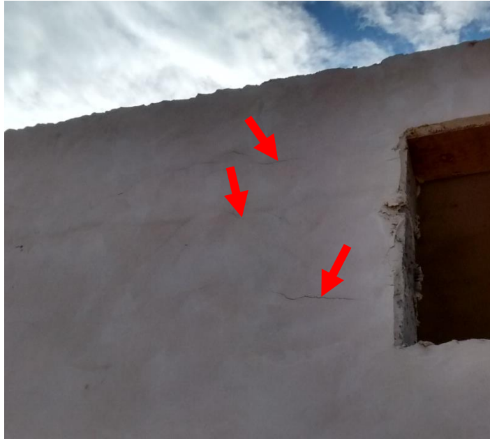
Figura 46: Fissuras na alvenaria da subestação. (Fonte: Dos autores 2016)
