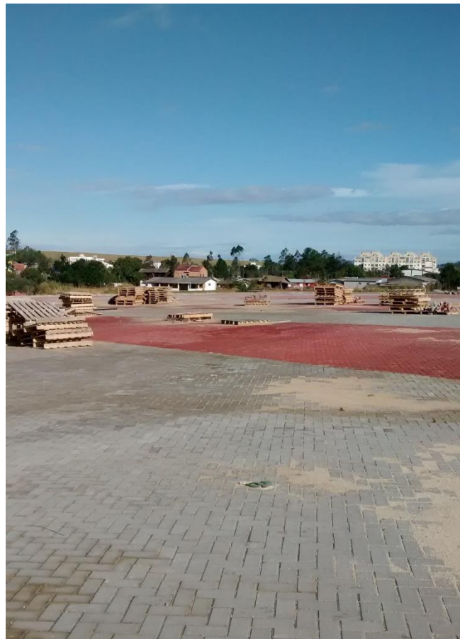
Figura 18: Detalhe da pavimentação com blocos de concreto tipo paver. (Fonte: Dos autores 2016)
