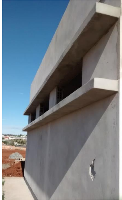
Figura 40: Quebra do revestimento da alvenaria na área externa. (Fonte: Dos autores 2016)
