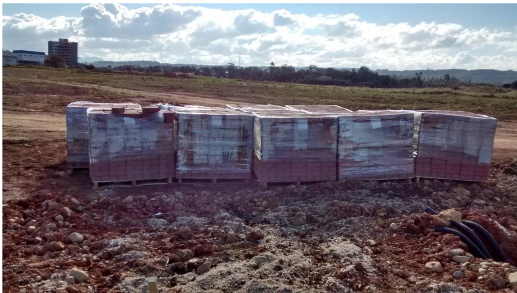
Figura 24: Armazenamento blocos de concreto tipo paver. (Fonte: Dos autores 2016)
