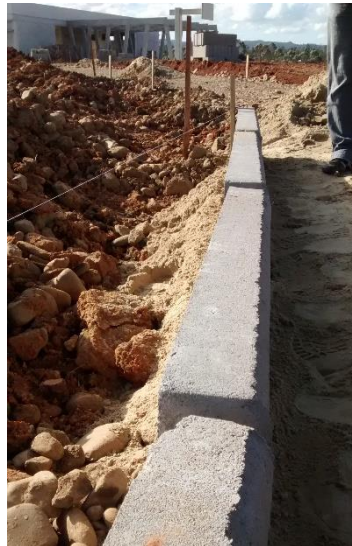
Figura 56: Alinhamento dos blocos de meios-fios. (Fonte: Dos autores 2016)
