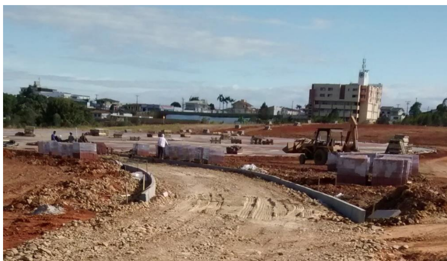
Figura 22: Detalhe da execução do caminho. (Fonte: Dos autores 2016)
