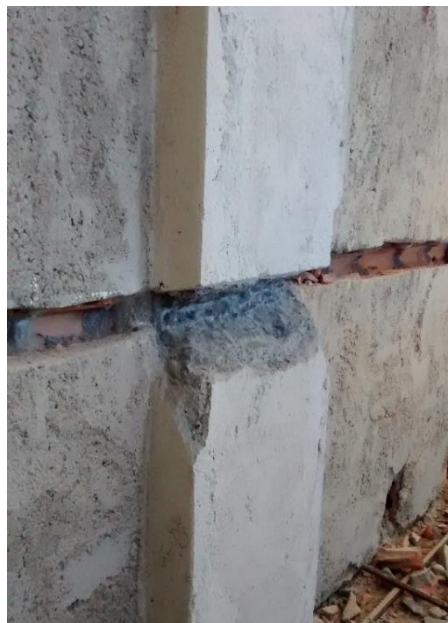
Figura 41: Quebra do pilar para execução da passagem de tubulações. (Fonte: Dos autores 2016)
