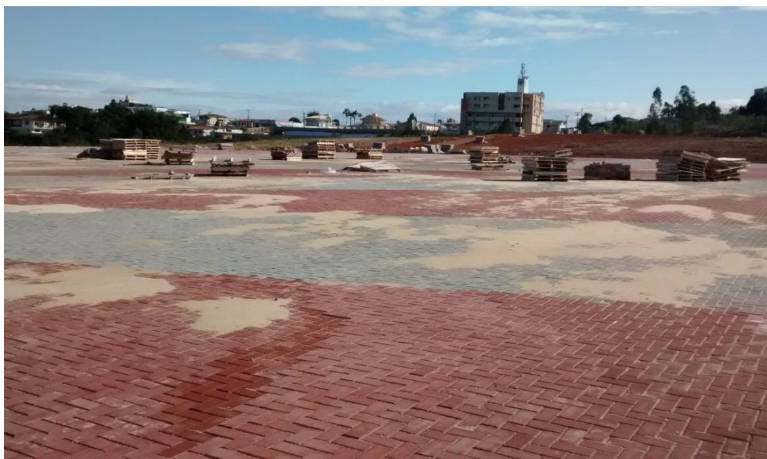
Figura 16: Detalhe da pavimentação com blocos de concreto tipo paver. (Fonte: Dos autores 2016)
