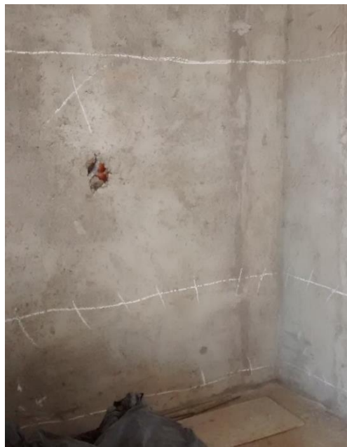
Figura 11: Demarcação dos locais aonde serão executadas passagens para tubulação. (Fonte: Dos autores 2016)
