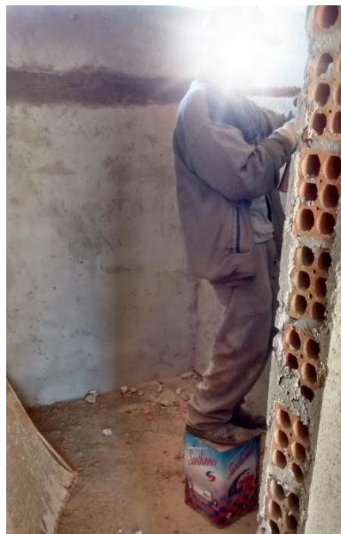
Figura 43: Profissional executando serviço apoiado sobre lata. (Fonte: Dos autores 2016)
