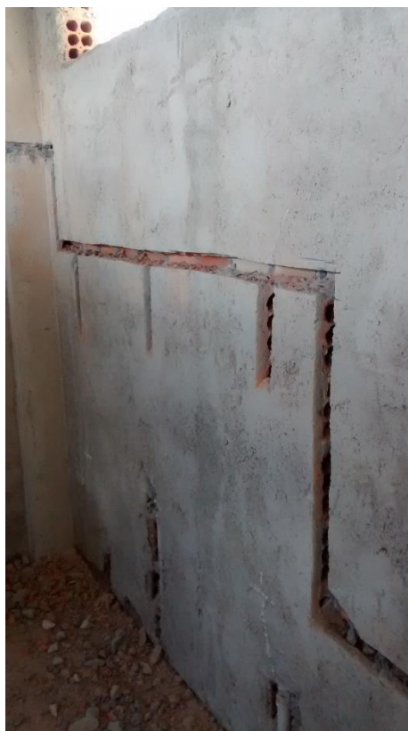
Figura 08: Execução das passagens para as tubulações. (Fonte: Dos autores 2016)
