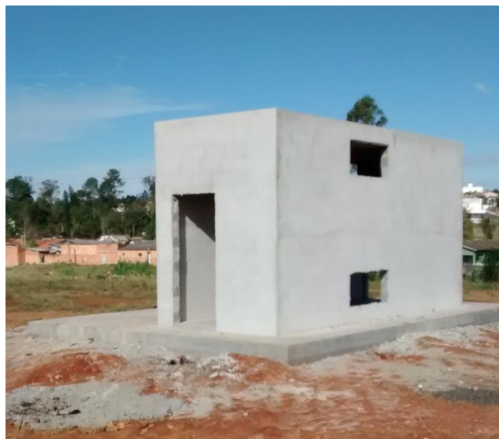
Figura 28: Acabamento da estrutura de alvenaria da subestação. (Fonte: Dos autores 2016)
