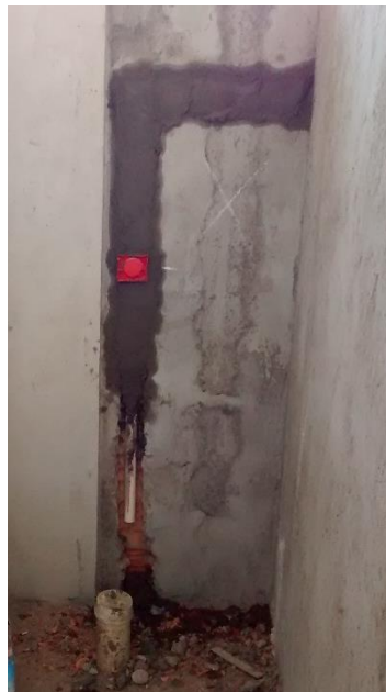
Figura 06: Tubulação de um dos sanitários instalada. (Fonte: Dos autores 2016)
