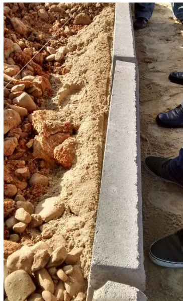
Figura 57: Alinhamento dos blocos de meios-fios. (Fonte: Dos autores 2016)
