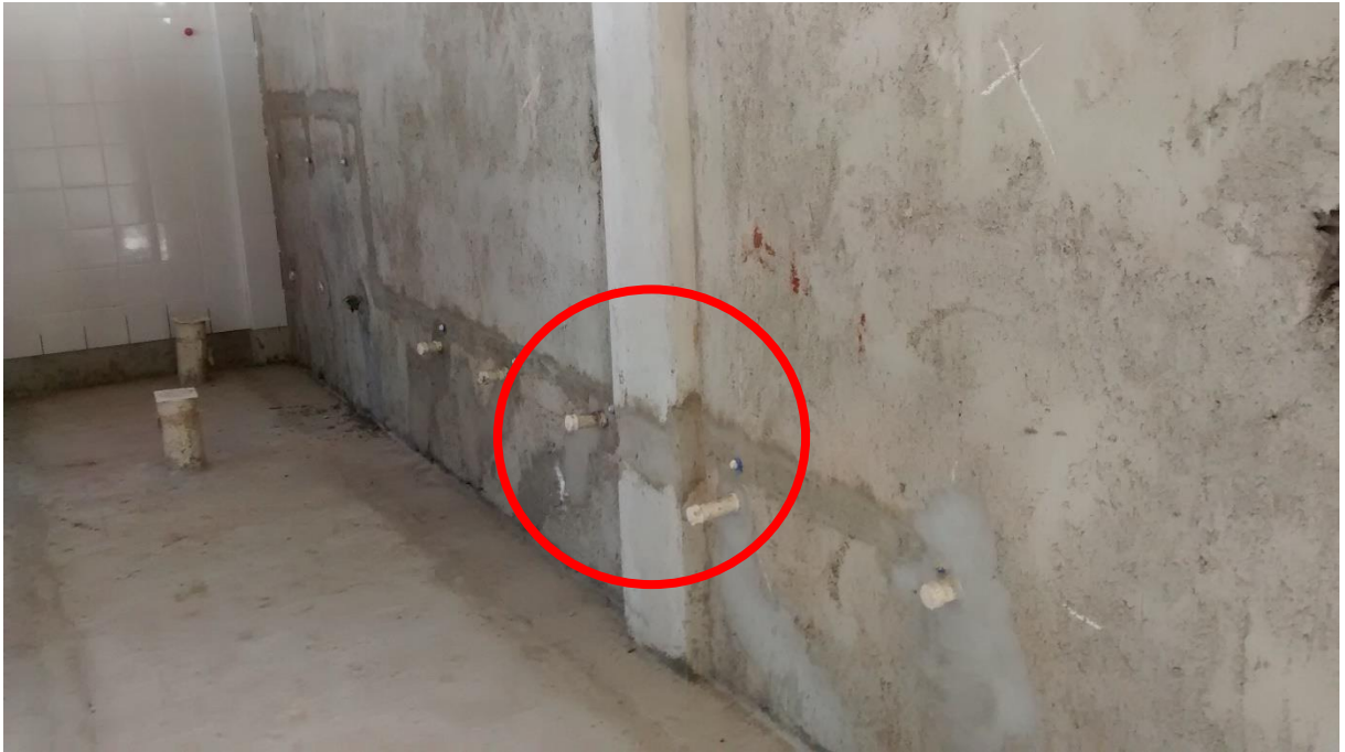
Figura 16: Detalhe do reparo feito em dos pilares. (Fonte: Dos autores 2016)
