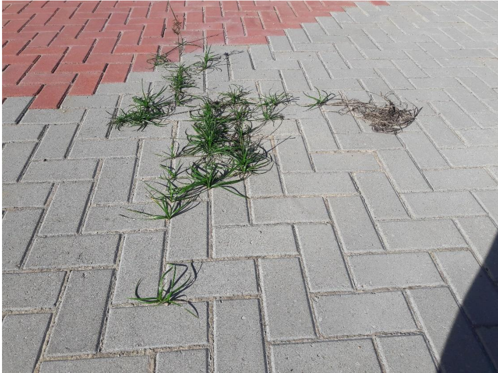
Figura 06: Crescimento de plantas entre os pavers. (Fonte: Dos autores 2017)
