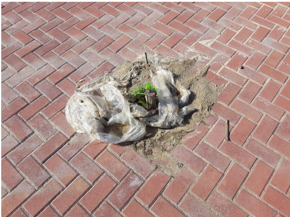
Figura 07: Crescimento de plantas entre os pavers. (Fonte: Dos autores 2017)
