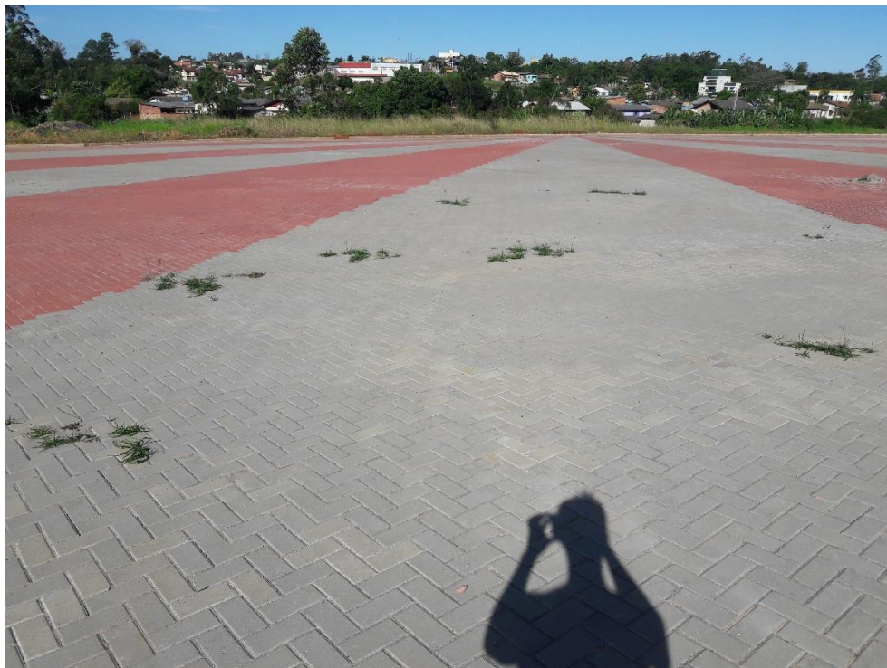
Figura 05: Crescimento de plantas entre os pavers. (Fonte: Dos autores 2017)
