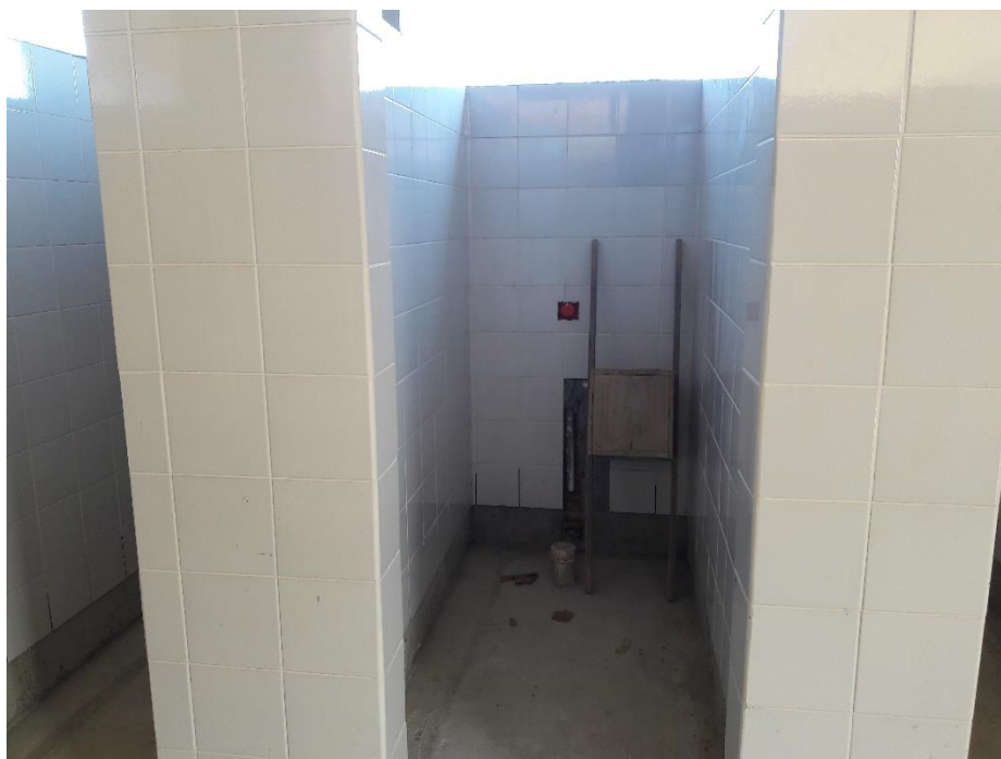
Figura 17: Sanitário com assentamento de azulejos pronto. (Fonte: Dos autores 2017)
