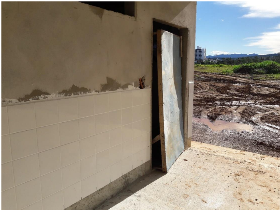
Figura 19: Azulejo na parte externa e proteção para impedir entrada. (Fonte: Dos autores 2017)
