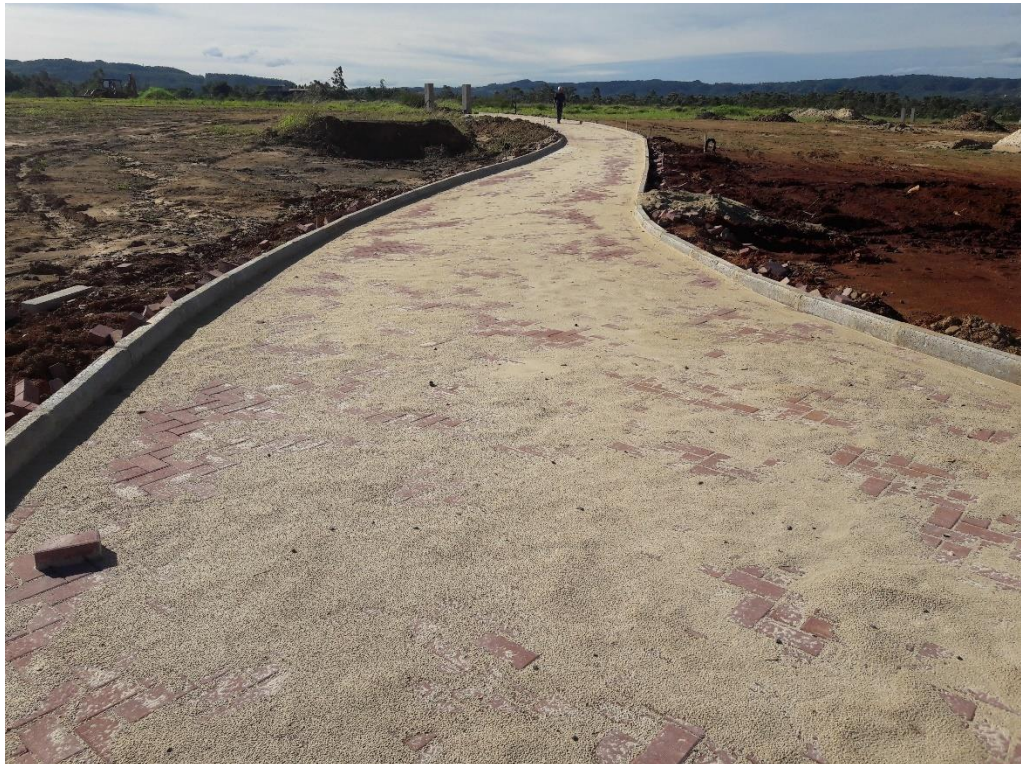
Figura 26: Novo trecho finalizado de pista. (Fonte: Dos autores 2017)
