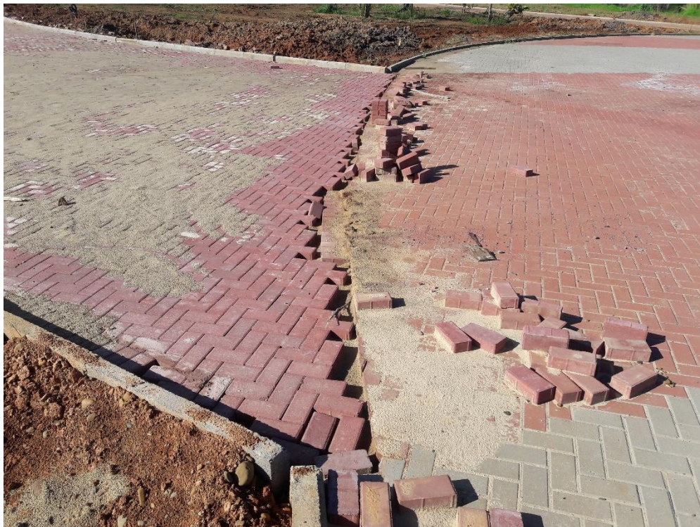
Figura 25: Assentamento do paver a ser executada. (Fonte: Dos autores 2017)
