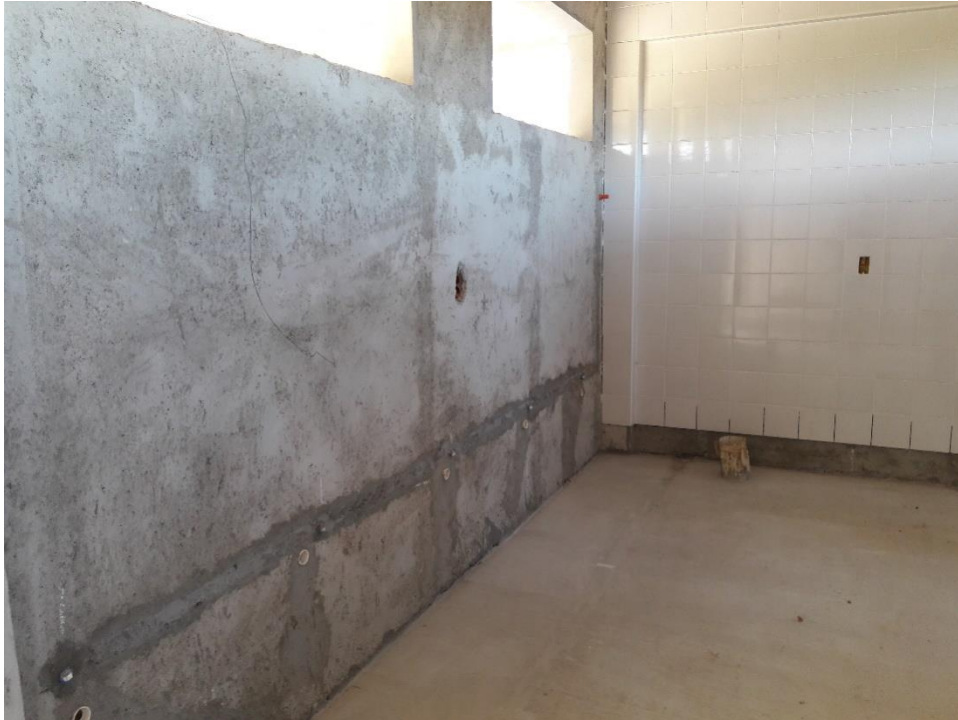
Figura 18: Parede do sanitário a ser assentado azulejo. (Fonte: Dos autores 2017)
