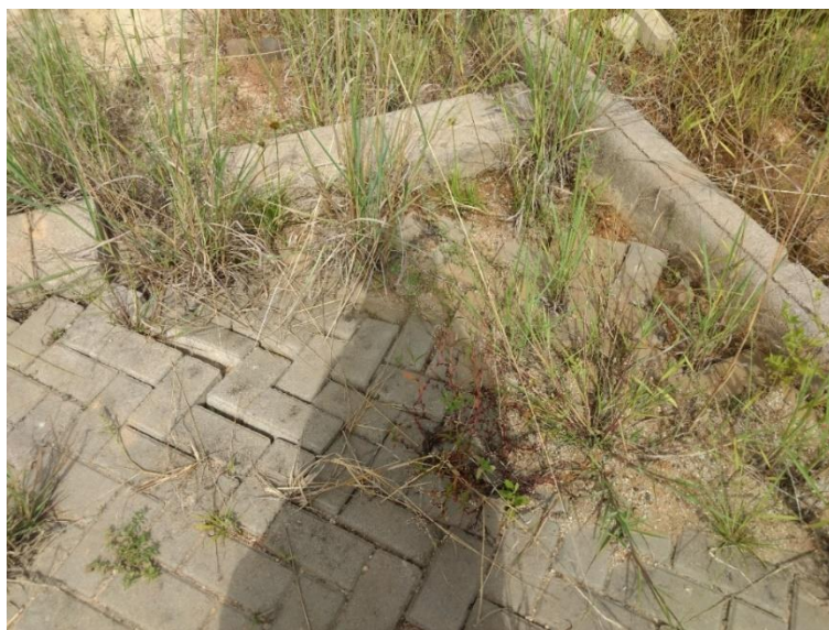
Figura 15: Inços entre os pavers. (Fonte: Dos Autores 2018)
