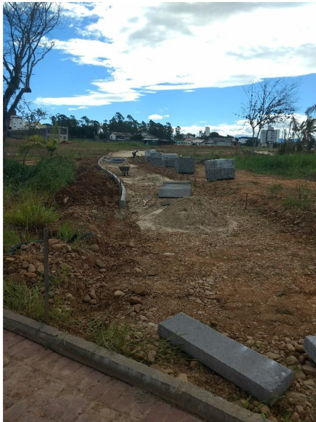
Figura 11: Instalação de paver na cor cinza. (Fonte: Dos Autores 2018)
