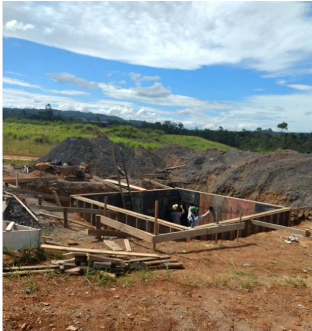
Figura 12: Construção da cisterna do parque. (Fonte: Dos Autores 2018)
