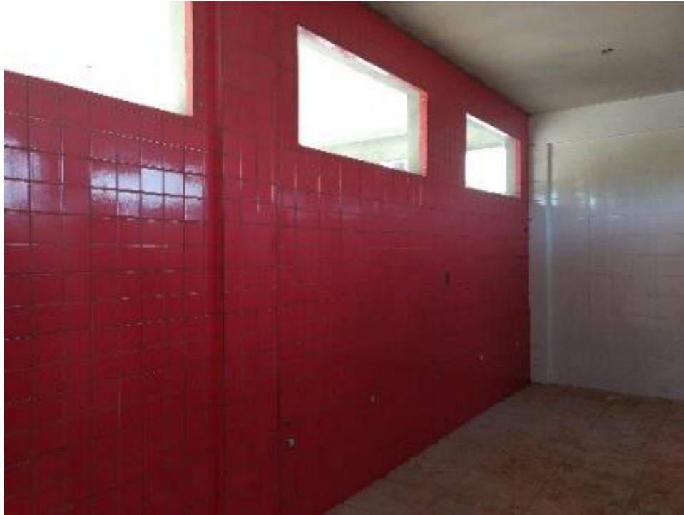
Figura 7: Parede de azulejos concluída. (Fonte: Dos Autores 2018)
