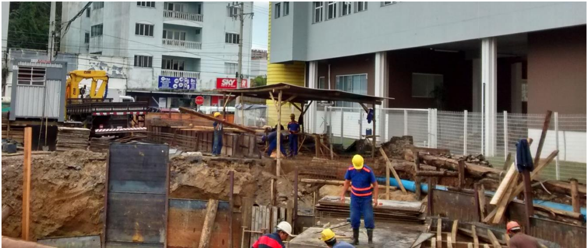
Figura 13: Local aonde são confeccionadas as armaduras. (Fonte: Dos autores 2016)
