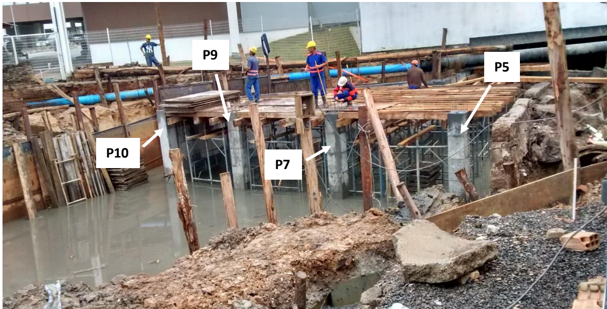
Figura 09: Detalhe dos pilares executados. (Fonte: Dos autores 2016)
