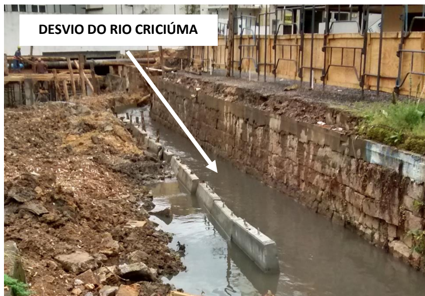
Figura 06: Desvio do Rio Criciúma. (Fonte: Dos autores 2016)
