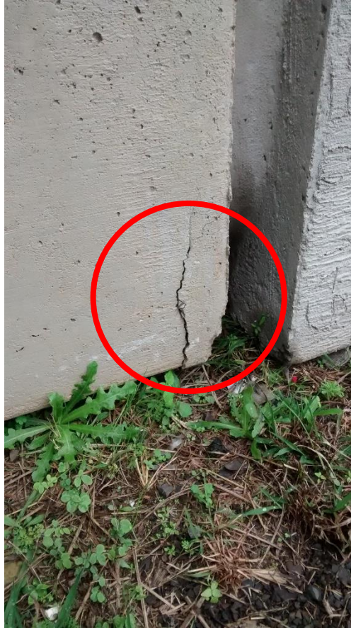
Figura 19: Detalhe de um dos pontos de quebra em uma das aduelas. (Fonte: Dos autores 2016)
