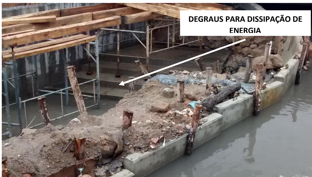
Figura 12: Degraus para dissipação de energia das águas oriundas do Rio Criciúma. (Fonte: Dos autores 2016)
