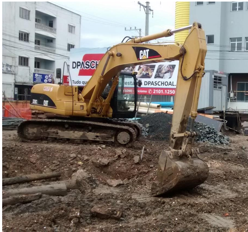
Figura 14: Execução de algumas escavações no canteiro de obras. (Fonte: Dos autores 2016)
