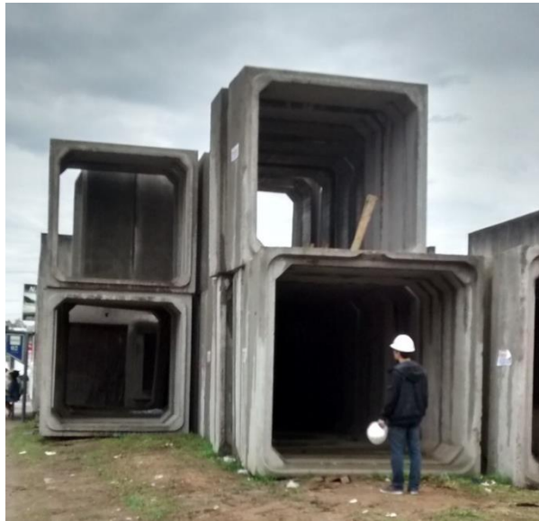
Figura 15: Armazenamento das aduelas de 2,50 x 2,50 m. (Fonte: Dos autores 2016)
