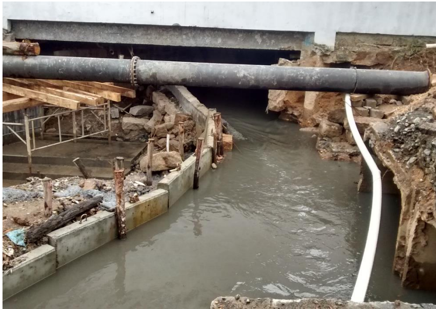
Figura 05: Desvio do Rio Criciúma. (Fonte: Dos autores 2016)
