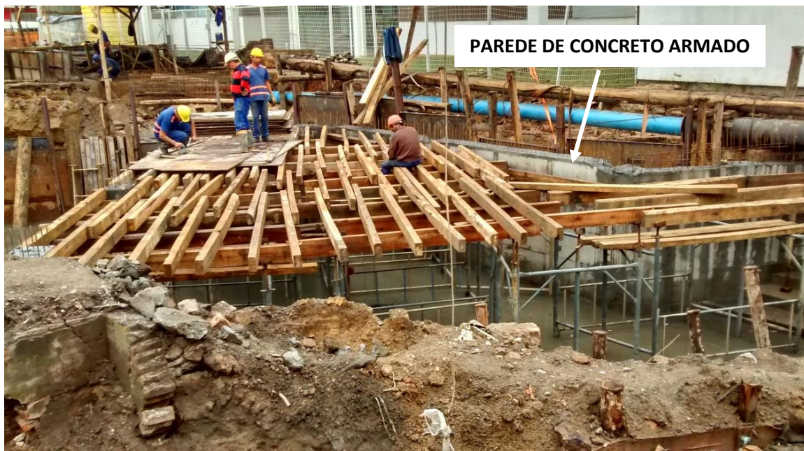
Figura 10: Detalhe da parede de concreto armado executada. (Fonte: Dos autores 2016)
