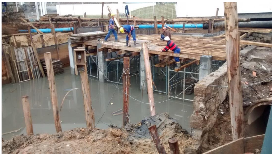
Figura 08: Execução da caixa de passagem 16. (Fonte: Dos autores 2016)
