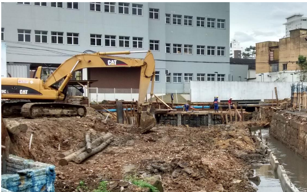
Figura 04: Local de início da etapa 2 do Canal Auxiliar do Rio Criciúma. (Fonte: Dos autores 2016)
