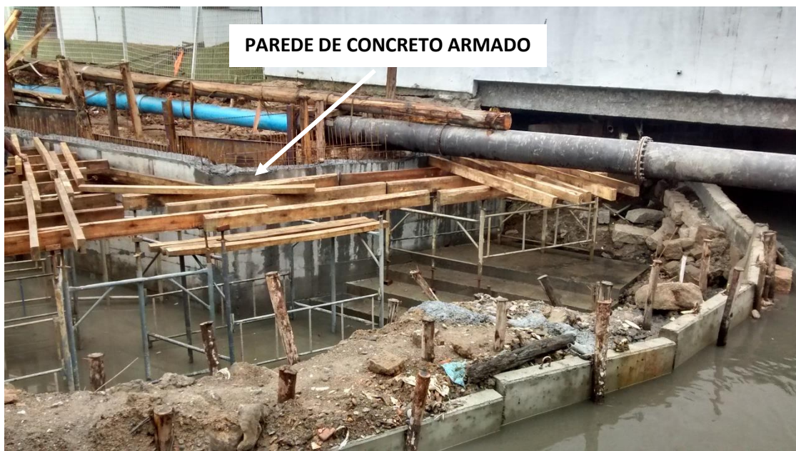
Figura 11: Detalhe da parede de concreto armado executada. (Fonte: Dos autores 2016)
