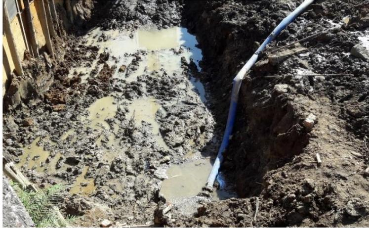
**Figura 09:** Remoção das águas. (Fonte: Dos autores 2016)
