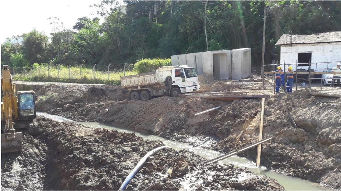
**Figura 12:** Despejo de material granular feito por caminhão. (Fonte: Dos autores 2016)
