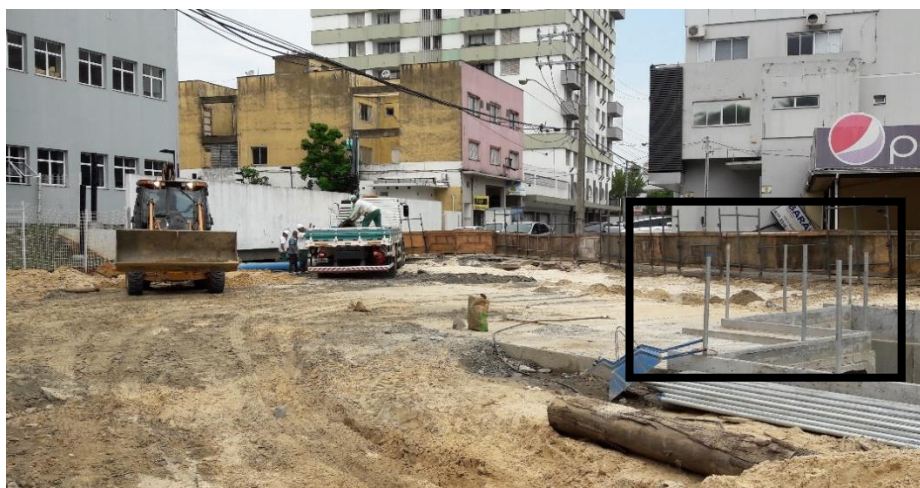
Figura 06: Finalização da implantação das aduelas e colocação dos canos galvanizados. (Fonte: Dos autores 2016)
