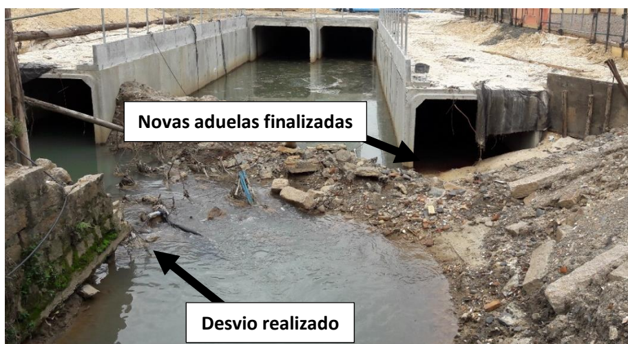
Figura 05: Desvio do rio e aduelas recém finalizadas. (Fonte: Dos autores 2016)
