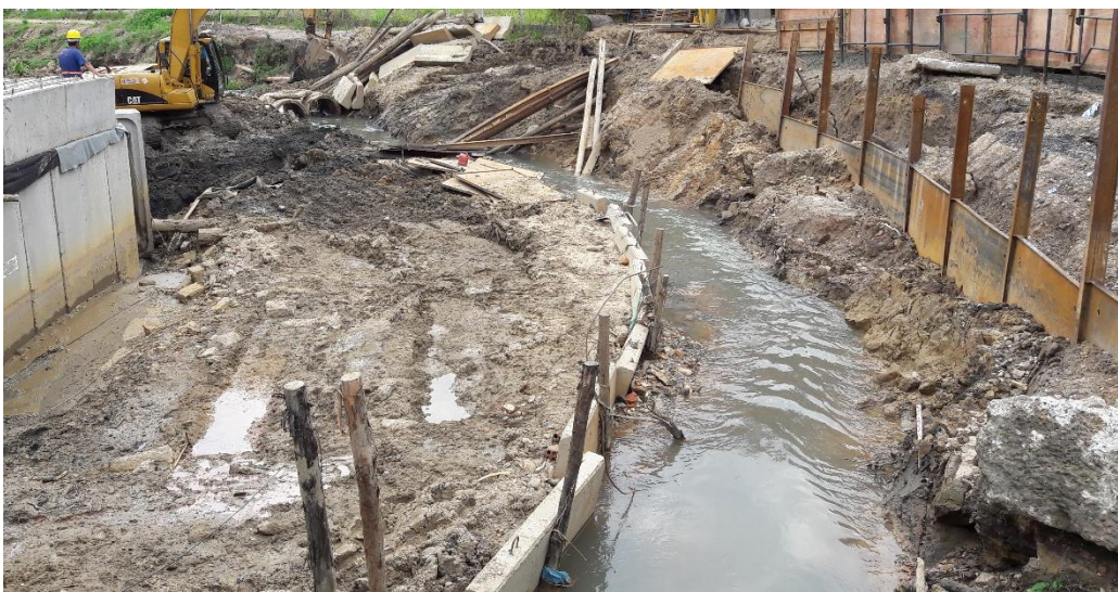
Figura 08: Desvio realizado no rio com contenções laterais. (Fonte: Dos autores 2016)
