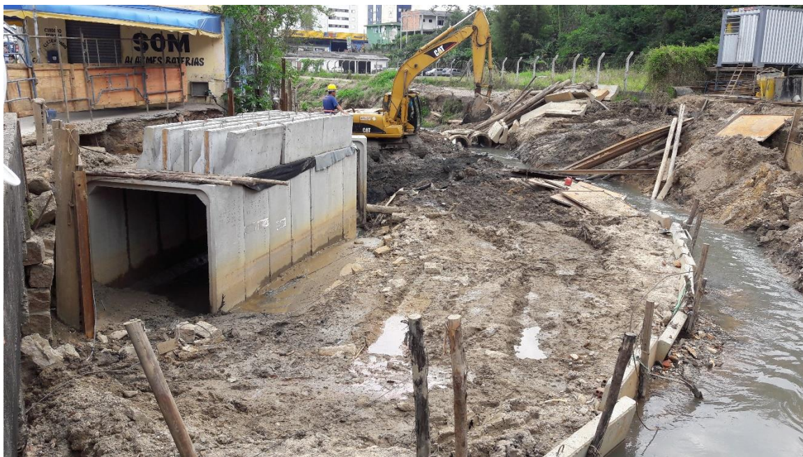
Figura 09: Aduelas instaladas. (Fonte: Dos autores 2016)
