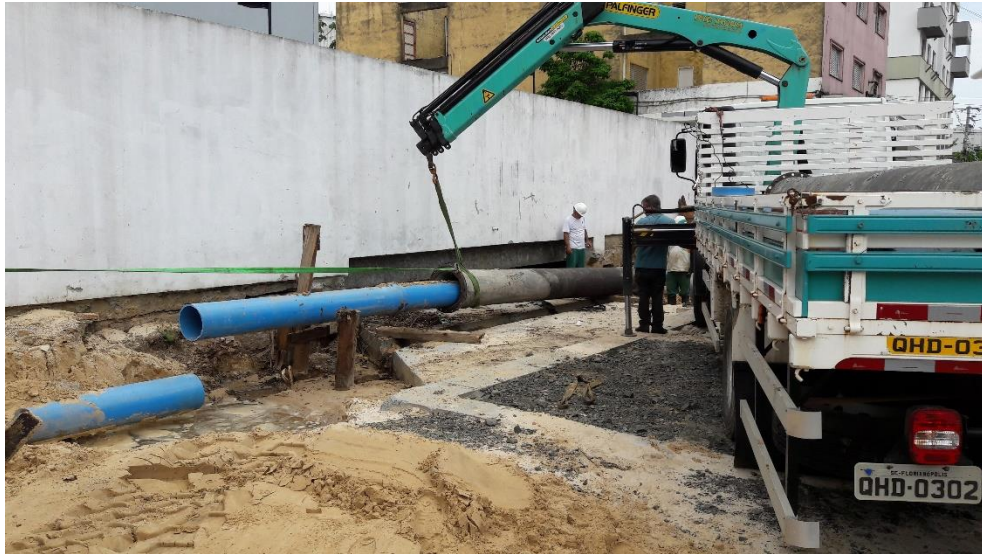
Figura 07: Substituição da tubulação da rede de água. (Fonte: Dos autores 2016)
