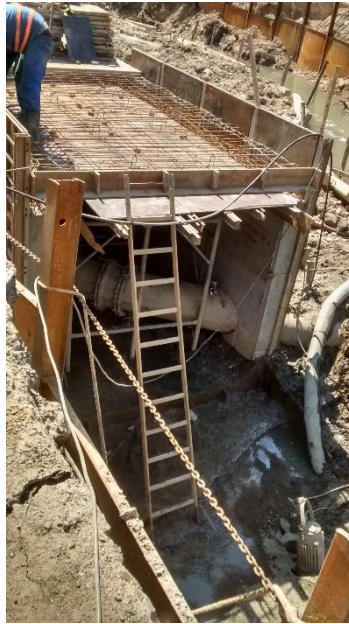
Figura 12: Local de interceptação. (Fonte: Dos autores 2016)
