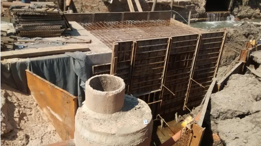
Figura 14: Trecho do Canal Auxiliar concretado in loco . (Fonte: Dos autores 2016)
