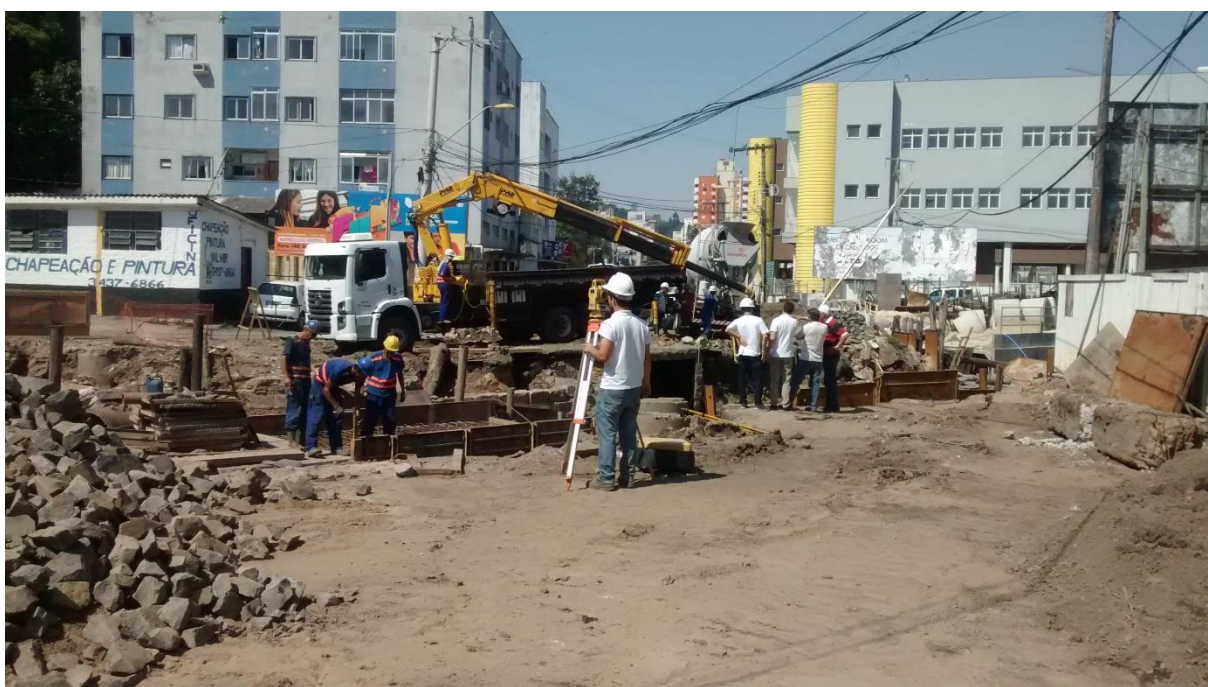
Figura 04: Obras do Canal Auxiliar do Rio Criciúma na Rua Araranguá. (Fonte: Dos autores 2016)
