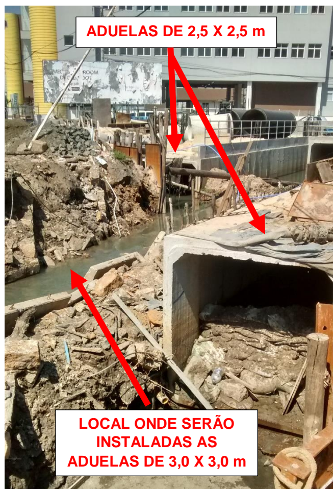
Figura 07: Detalhamento do processo construtivo. (Fonte: Dos autores 2016)
