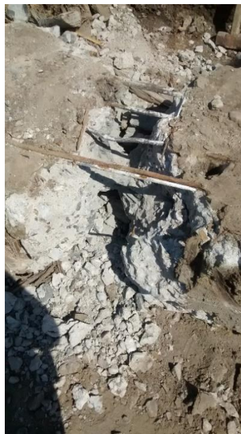
Figura 06: Viga retirada da antiga ponte da Rua Araranguá. (Fonte: Dos autores 2016)
