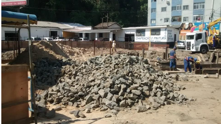
Figura 10: Material a ser utilizado para execução da base do canal. (Fonte: Dos autores 2016)
