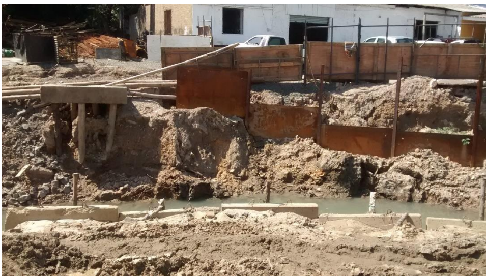
Figura 17: Detalhe da contenção executada. (Fonte: Dos autores 2016)
