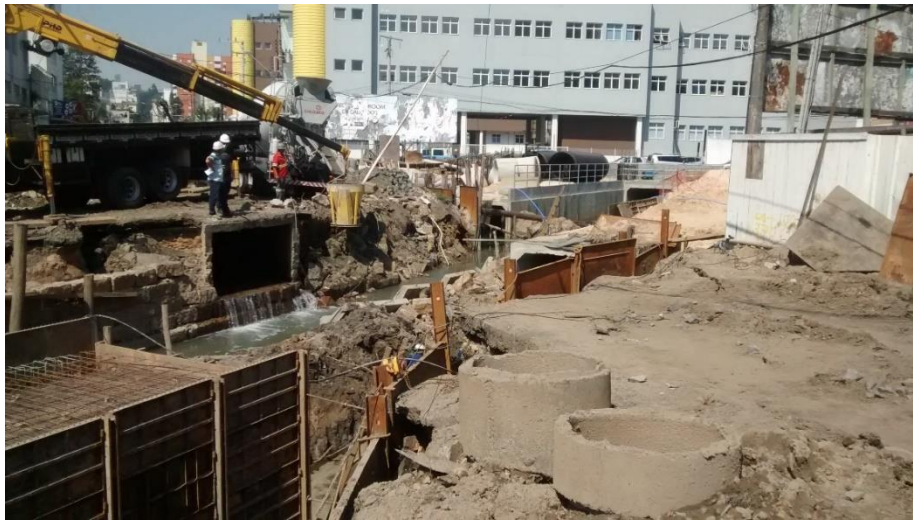
Figura 05: Local onde será reconstruída a ponte da Rua Araranguá. (Fonte: Dos autores 2016)
