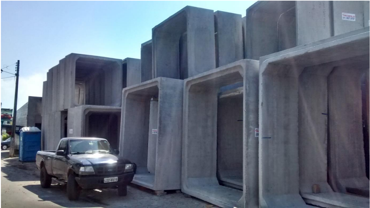
Figura 20: Armazenamento de aduelas. (Fonte: Dos autores 2016)
