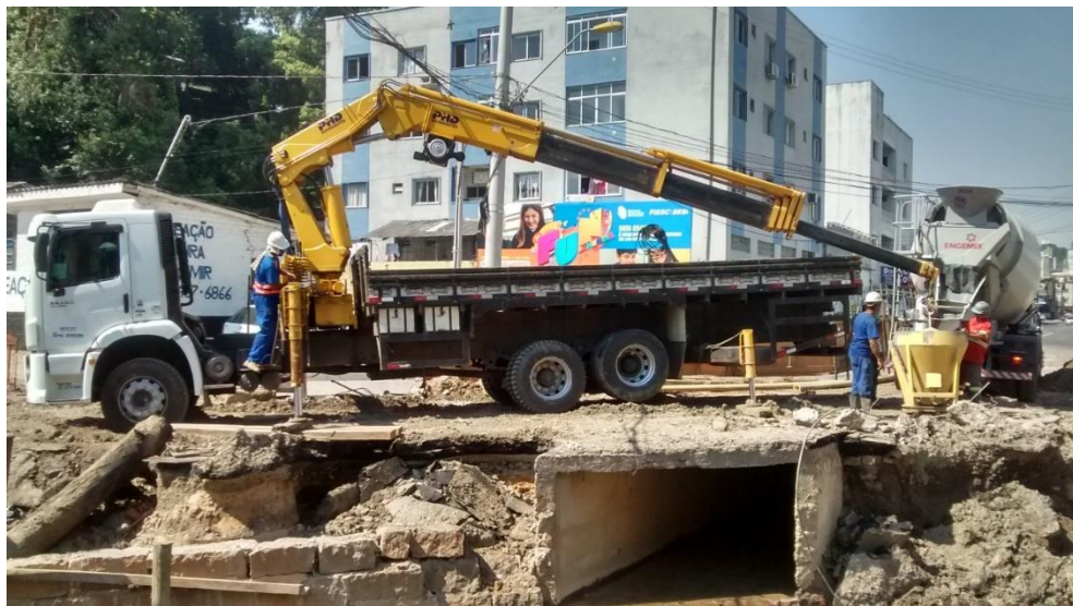
Figura 09: Equipamentos utilizados para o processo de concretagem. (Fonte: Dos autores 2016)
