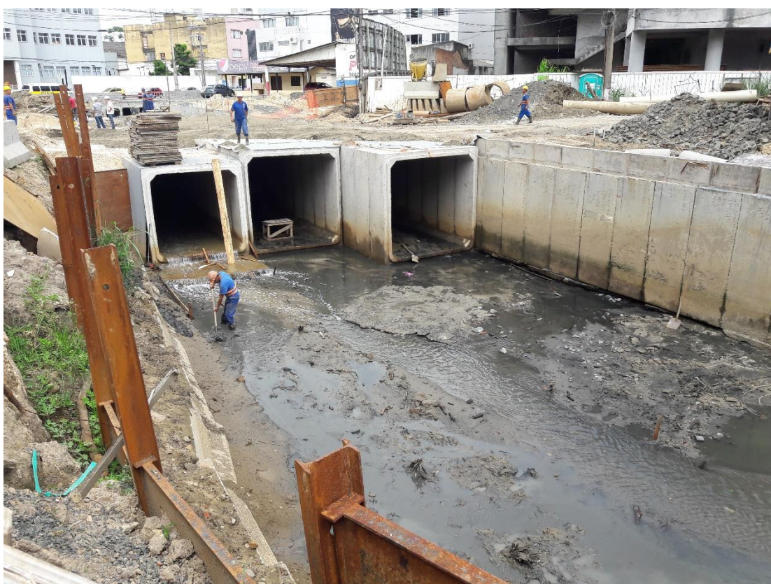
Figura 06: Final do trecho onde irão as aduelas centrais. (Fonte: Dos autores 2017)
