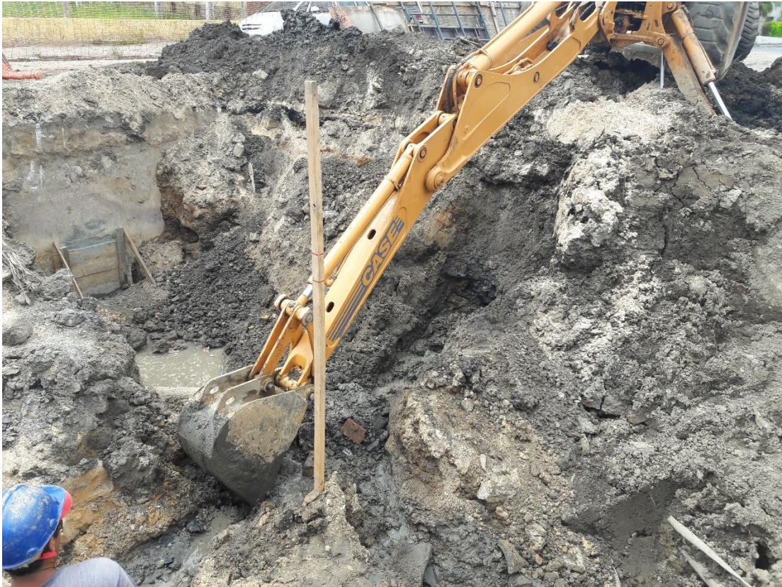
Figura 10: Local onde estourou a tubulação. (Fonte: Dos autores 2017)
