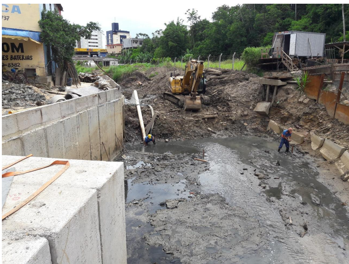
Figura 07: Trabalhos de regularização do solo. (Fonte: Dos autores 2017)
