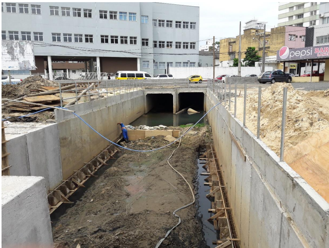
Figura 11: Contenção das aduelas centrais. (Fonte: Dos autores 2017)
