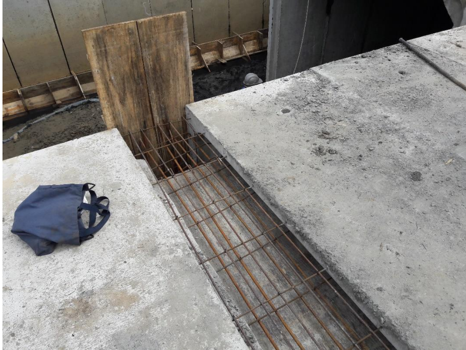
Figura 08: Concretagem a ser realizada. (Fonte: Dos autores 2017)
