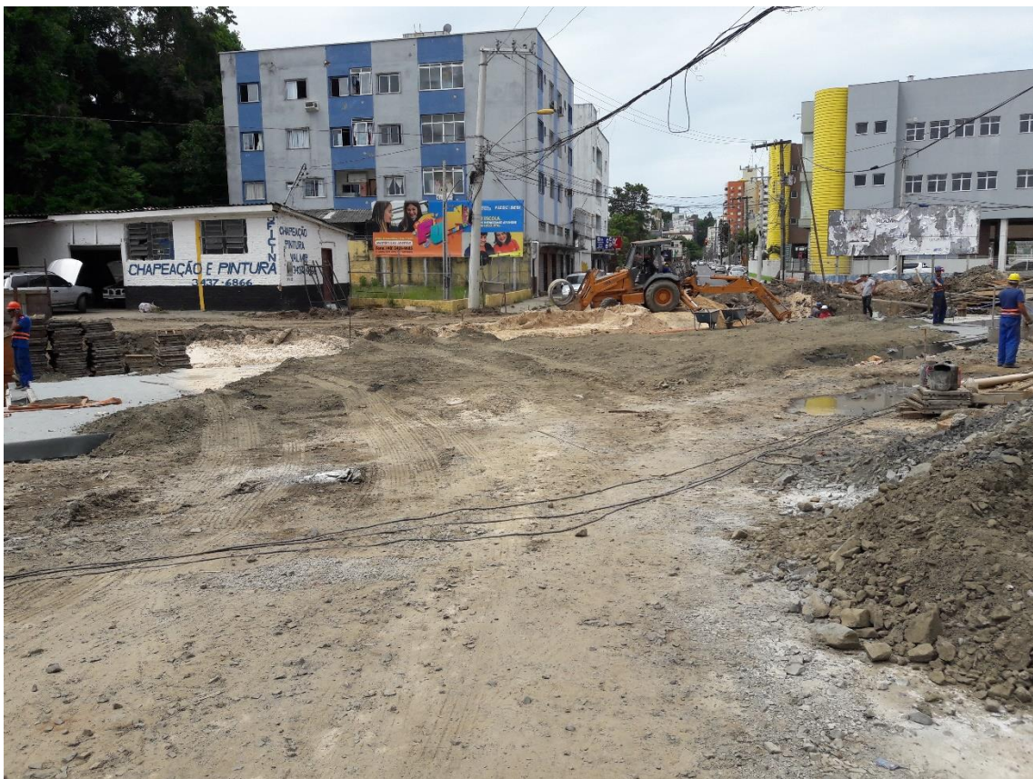
Figura 05: Local onde será reconstruída a ponte da Rua Araranguá. (Fonte: Dos autores 2017)
