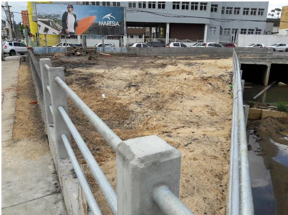
**Figura 11:** Corrimão instalado e solo pronto. (Fonte: Dos autores 2017)
