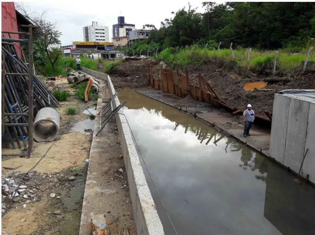
**Figura 08:** Trecho com base pronta para receber as aduelas laterais. (Fonte: Dos autores 2017)
