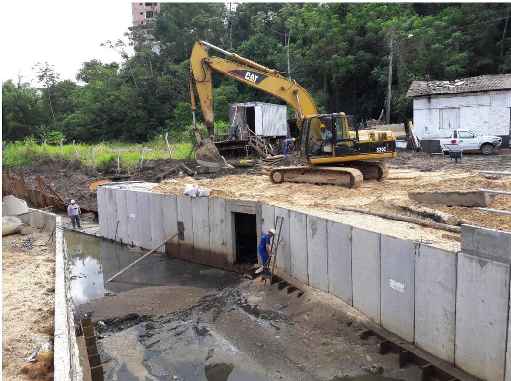
**Figura 06:** Aduelas instaladas e compactação do solo. (Fonte: Dos autores 2017)
