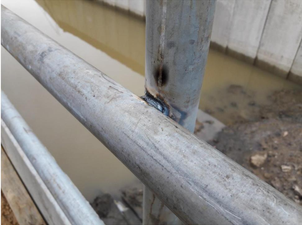
**Figura 09:** Detalhe solda do corrimão. (Fonte: Dos autores 2017)
