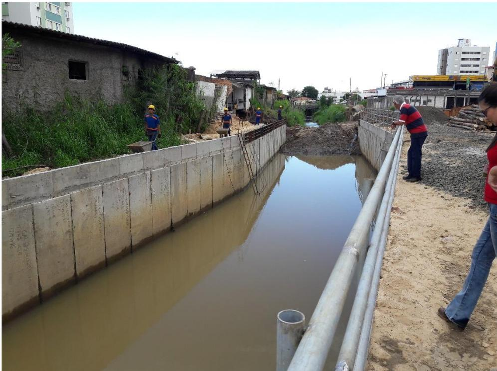
**Figura 08:** Trecho com aduelas e corrimão instalados. (Fonte: Dos autores 2017)
