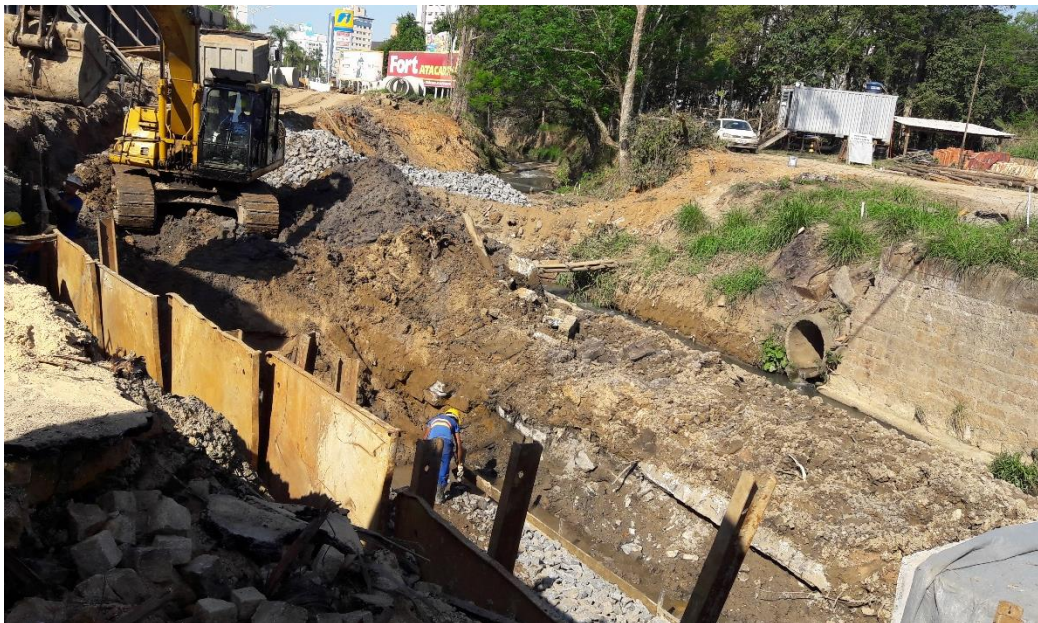
Figura 7: Abertura do canal e preparação da base de concreto (Fonte: Autores)
