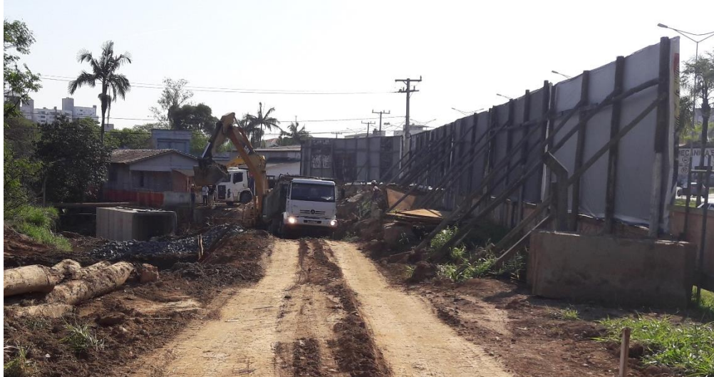
Figura 6: Remoção da terra para abertura do canal (Fonte: Autores)
