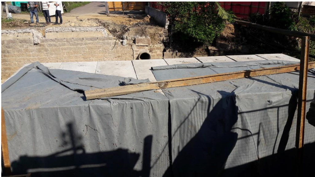
Figura 5: Aduelas instaladas (Fonte: Autores)
