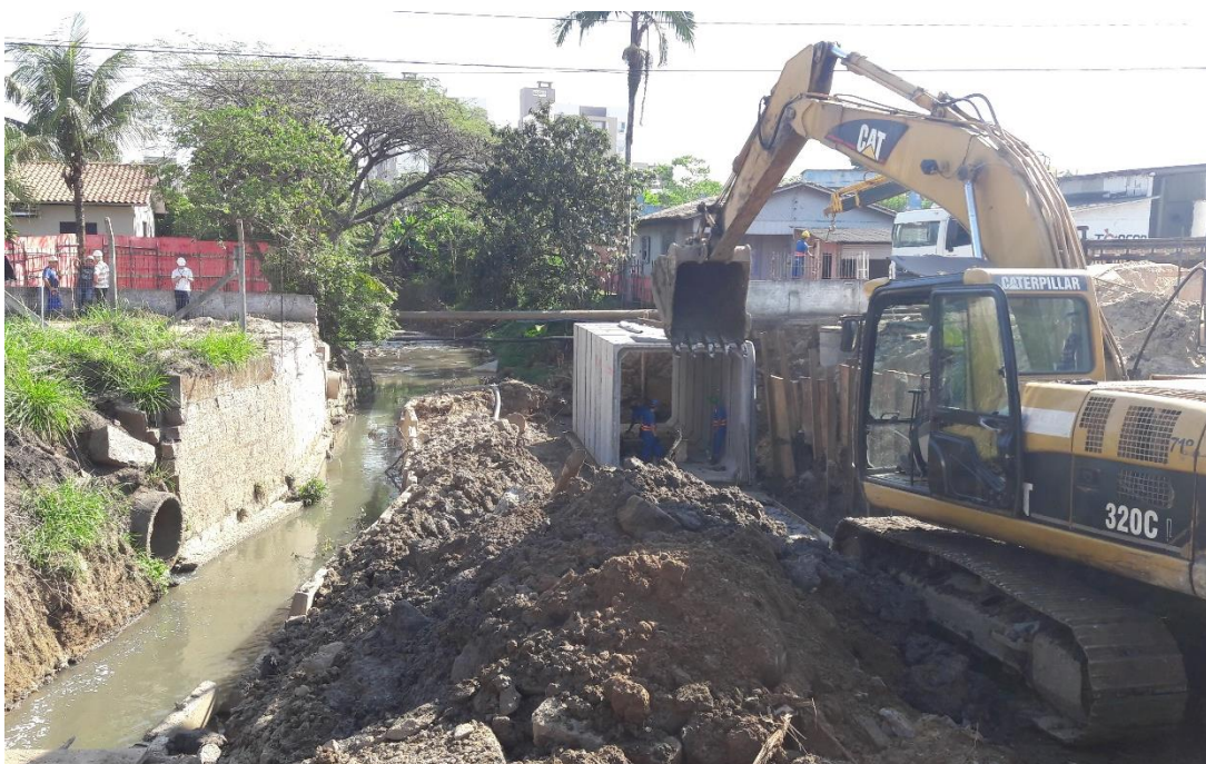
Figura 4: Instalação da aduela lateral (Fonte: Autores)
