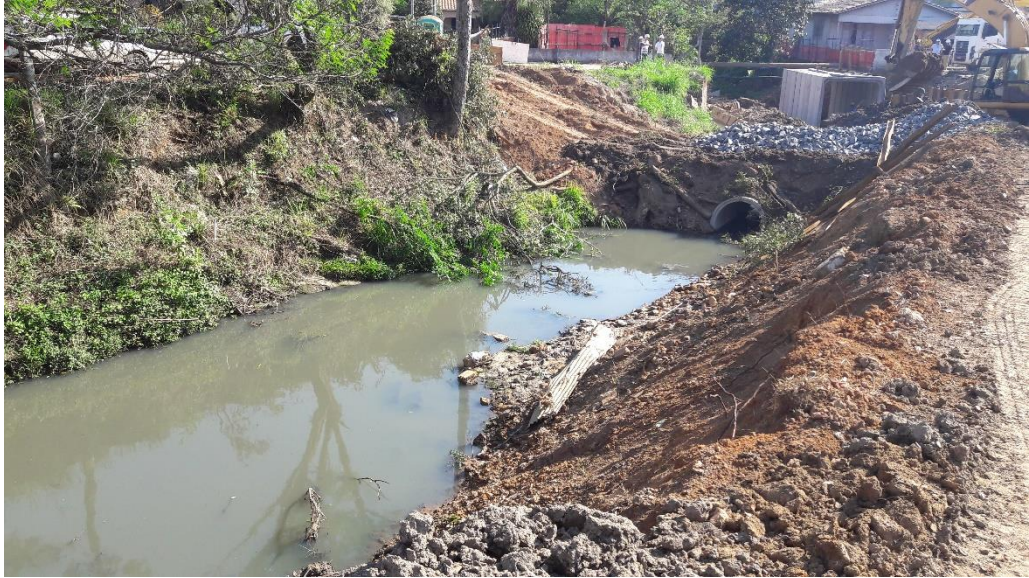
Figura 8: Contenção da água e passagem pela tubulação (Fonte: Autores)
