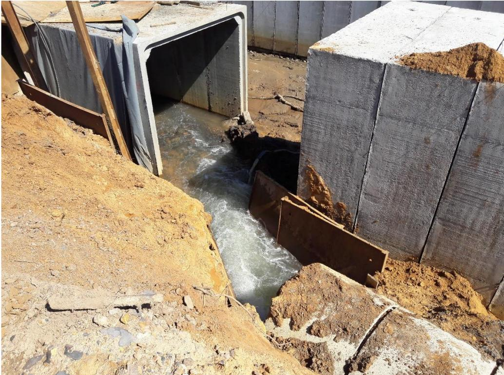
**Figura 6:** Passagem da água pela aduela lateral esquerda (Fonte: Autores)
