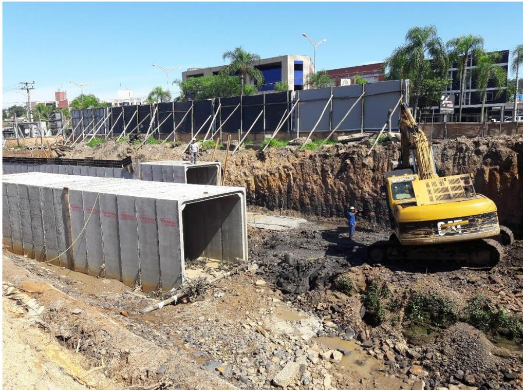
**Figura 8:** Trecho para instalação das aduelas (Fonte: Autores)
