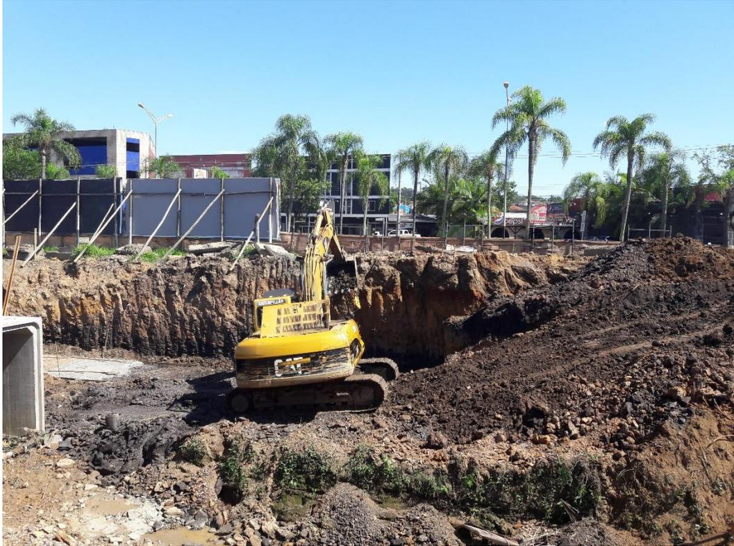
**Figura 9:** Máquina realizando abertura do trecho para instalar aduelas (Fonte: Autores)
