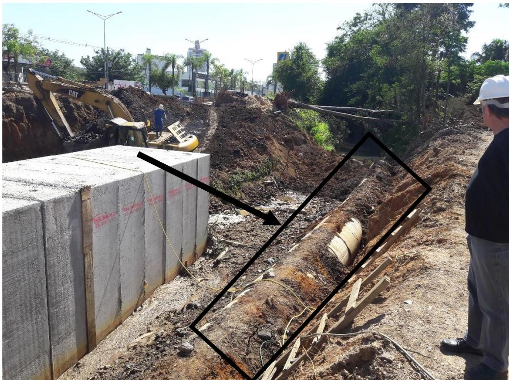
**Figura 7:** Tubulação instalada para passagem da água no desvio do rio (Fonte: Autores)
