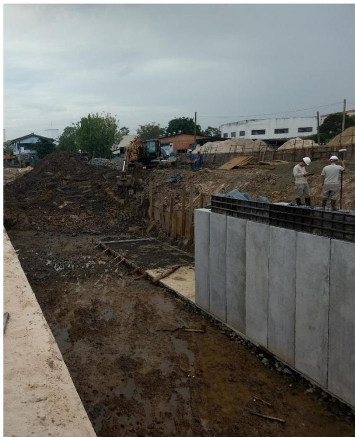
**Figura 10:** Execução de escoramentos e instalação de aduelas. (Fonte: Dos Autores 2018)
