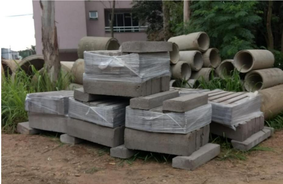
**Figura 15:** Armazenamento de blocos de concreto. (Fonte: Dos Autores 2018)
