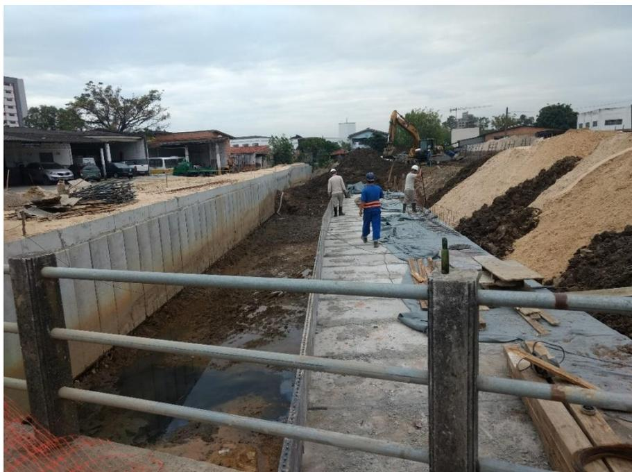
**Figura 12:** Instalação de aduelas laterais. (Fonte: Dos Autores 2018)
