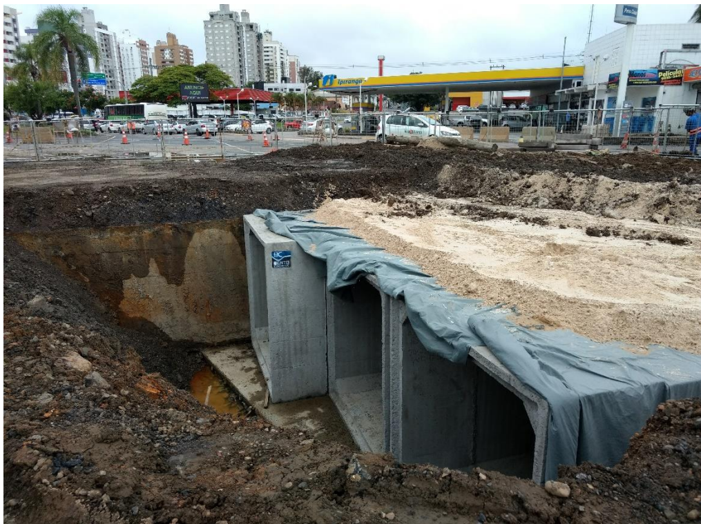
Figura 7: Aduelas instalados no sentido Centro/Pinheirinho (Fonte: Dos Autores 2018)
