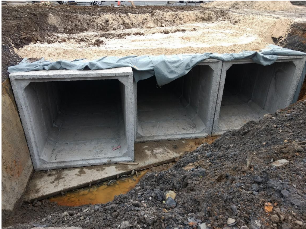
Figura 6: Aduelas instalados no sentido Centro/Pinheirinho (Fonte: Dos Autores 2018)
