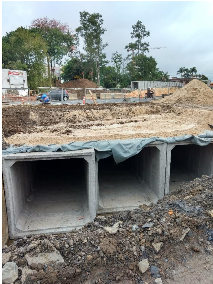
Figura 5: Aduelas instalados no sentido Centro/Pinheirinho (Fonte: Dos Autores 2018)
