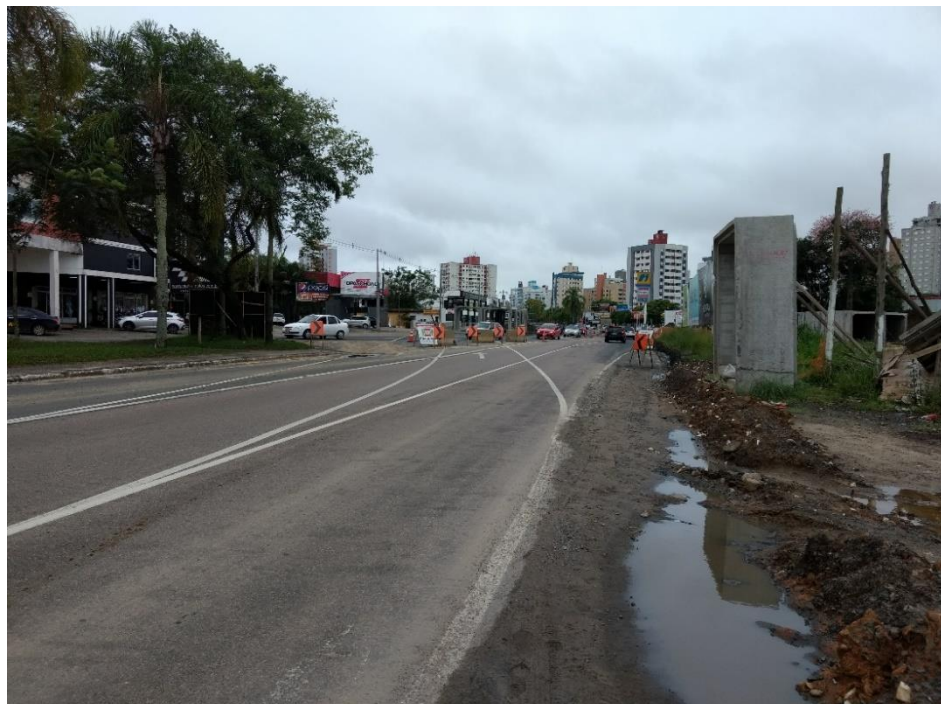
Figura 11: Desvio realizado na Avenida. (Fonte: Dos Autores 2018)
