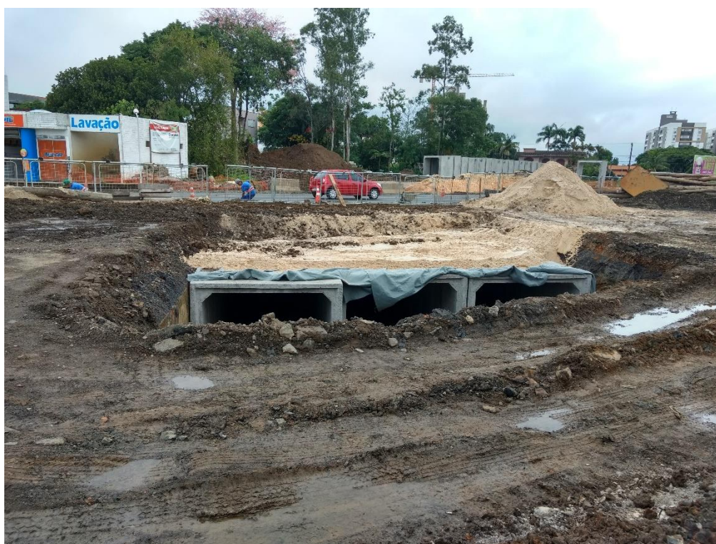
Figura 4: Aduelas atravessando a Avenida Centenário. (Fonte: Dos Autores 2018)
