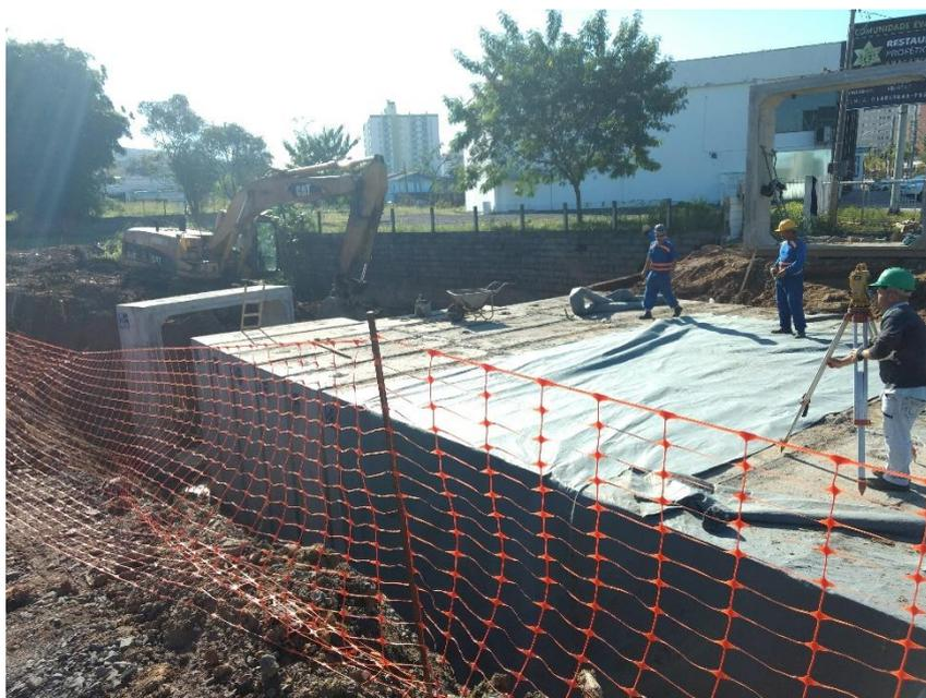
**Figura 6:** Instalação do material geotêxtil. (Fonte: Dos Autores 2018)
