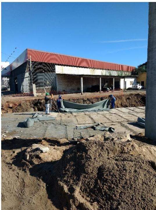
**Figura 5:** Instalação do material geotêxtil. (Fonte: Dos Autores 2018)
