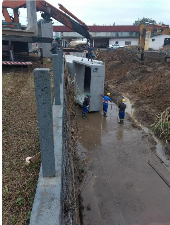
**Figura 5:** Instalação de aduelas. (Fonte: Dos Autores 2018)
