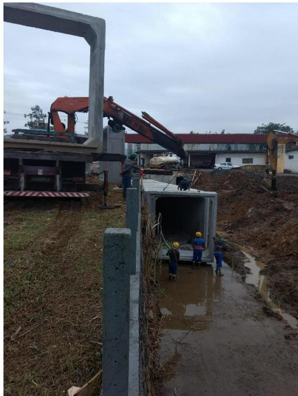
**Figura 6:** Instalação de aduelas. (Fonte: Dos Autores 2018)
