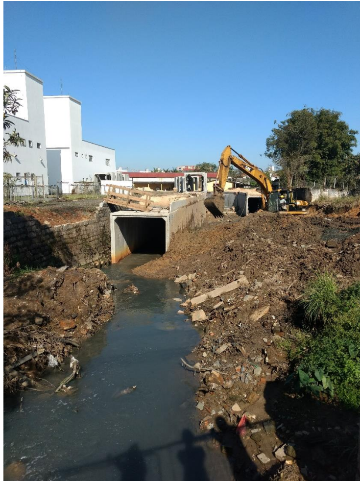
Figura 7: Execução do lote 02. (Fonte: Dos Autores 2018)
