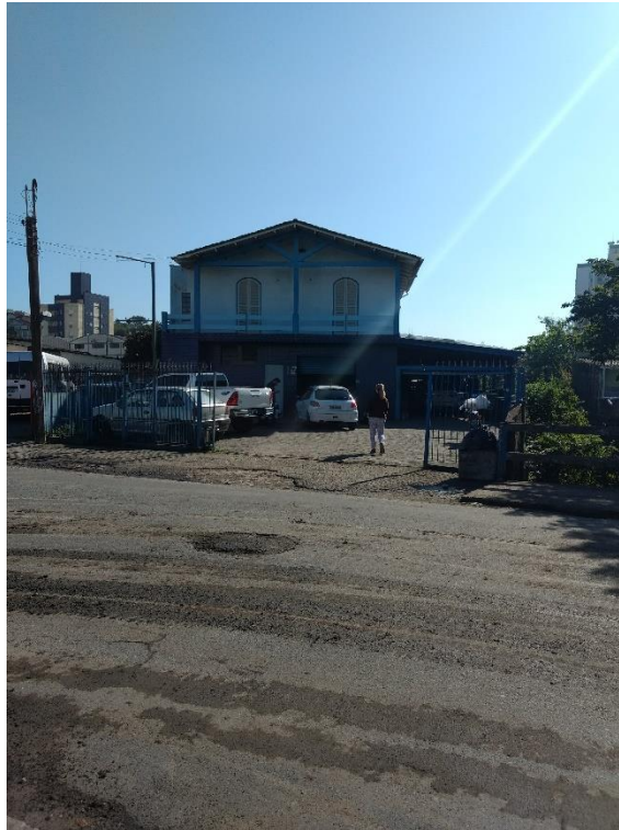
Figura 8: Casa que será demolida. (Fonte: Dos Autores 2018)
