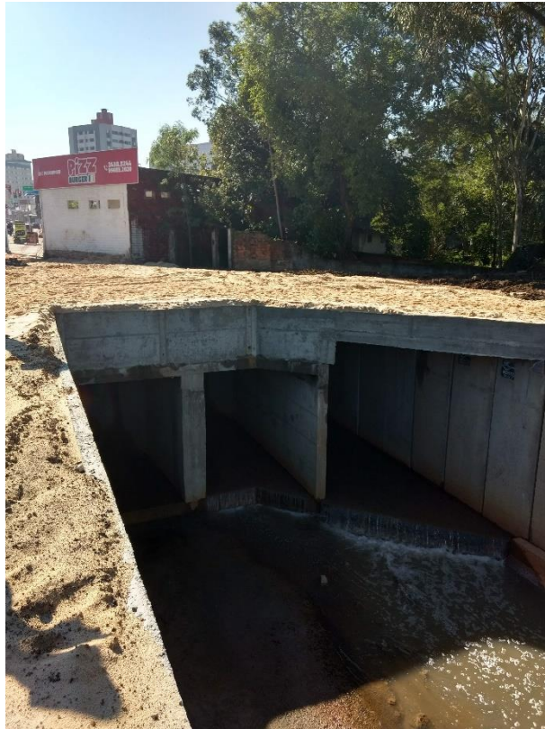
Figura 5: Laje radier finalizada. (Fonte: Dos Autores 2018)
