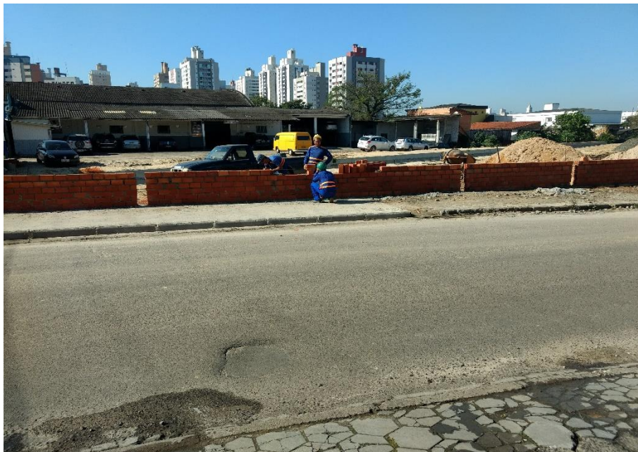
Figura 9: Reconstrução do muro. (Fonte: Dos Autores 2018)
