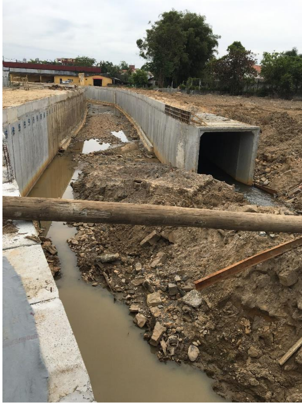
Figura 7: Prolongamento do canal auxiliar. (Fonte: Dos Autores 2018)
