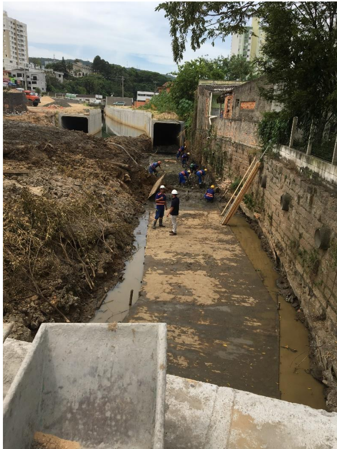
Figura 10: Trabalhadores executando a preparação da base. (Fonte: Dos Autores 2018)
