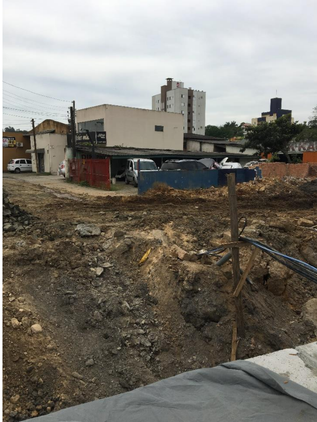
Figura 5: Local da remoção da casa. (Fonte: Dos Autores 2018)
