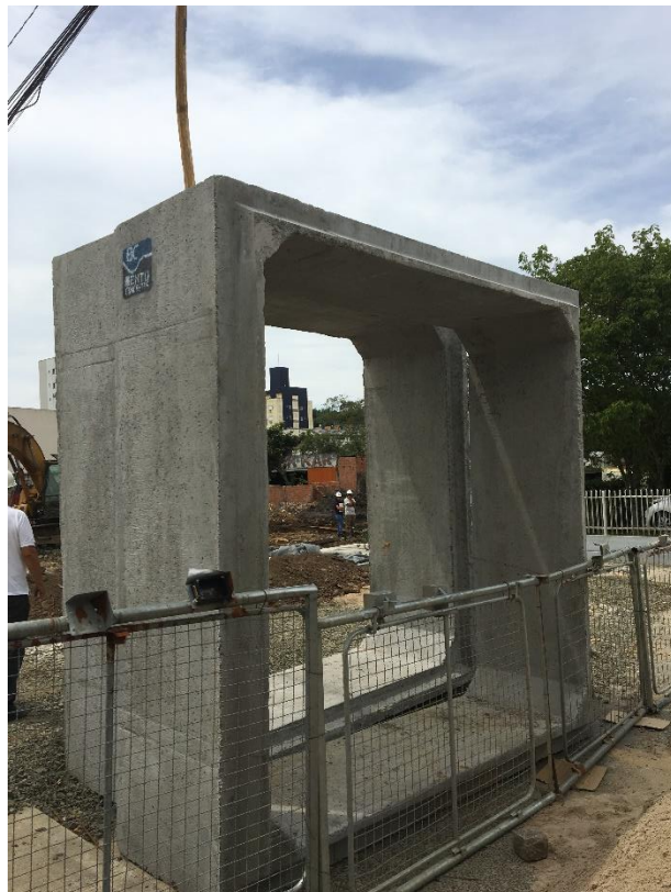
Figura 8: Aduelas para instalação. (Fonte: Dos Autores 2018)
