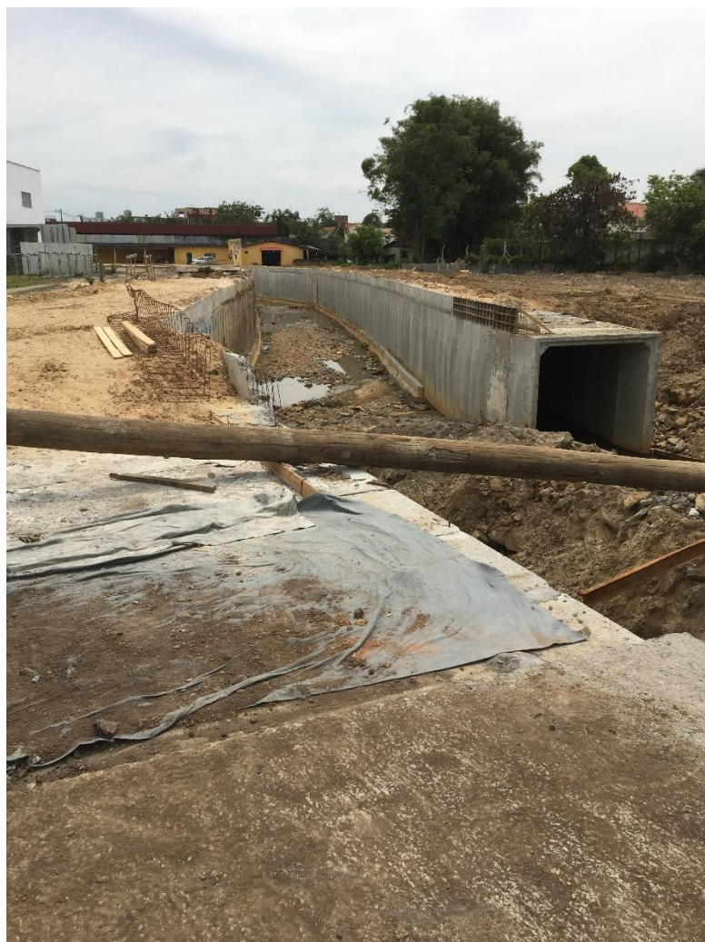
Figura 4: Prolongamento do Canal Auxiliar. (Fonte: Dos Autores 2018)
