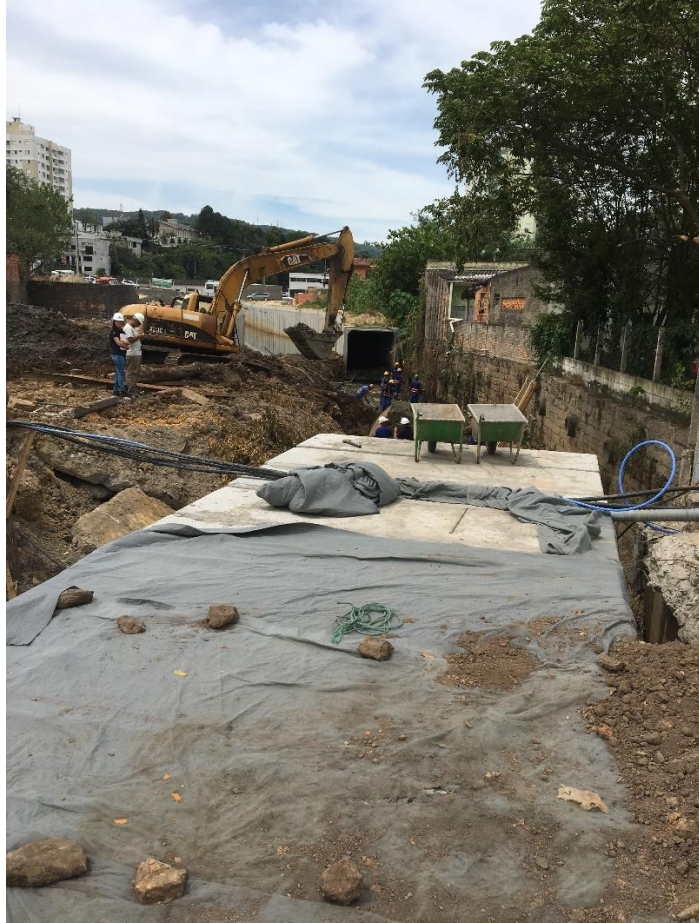
Figura 9: Trabalhadores executando a preparação da base. (Fonte: Dos Autores 2018)
