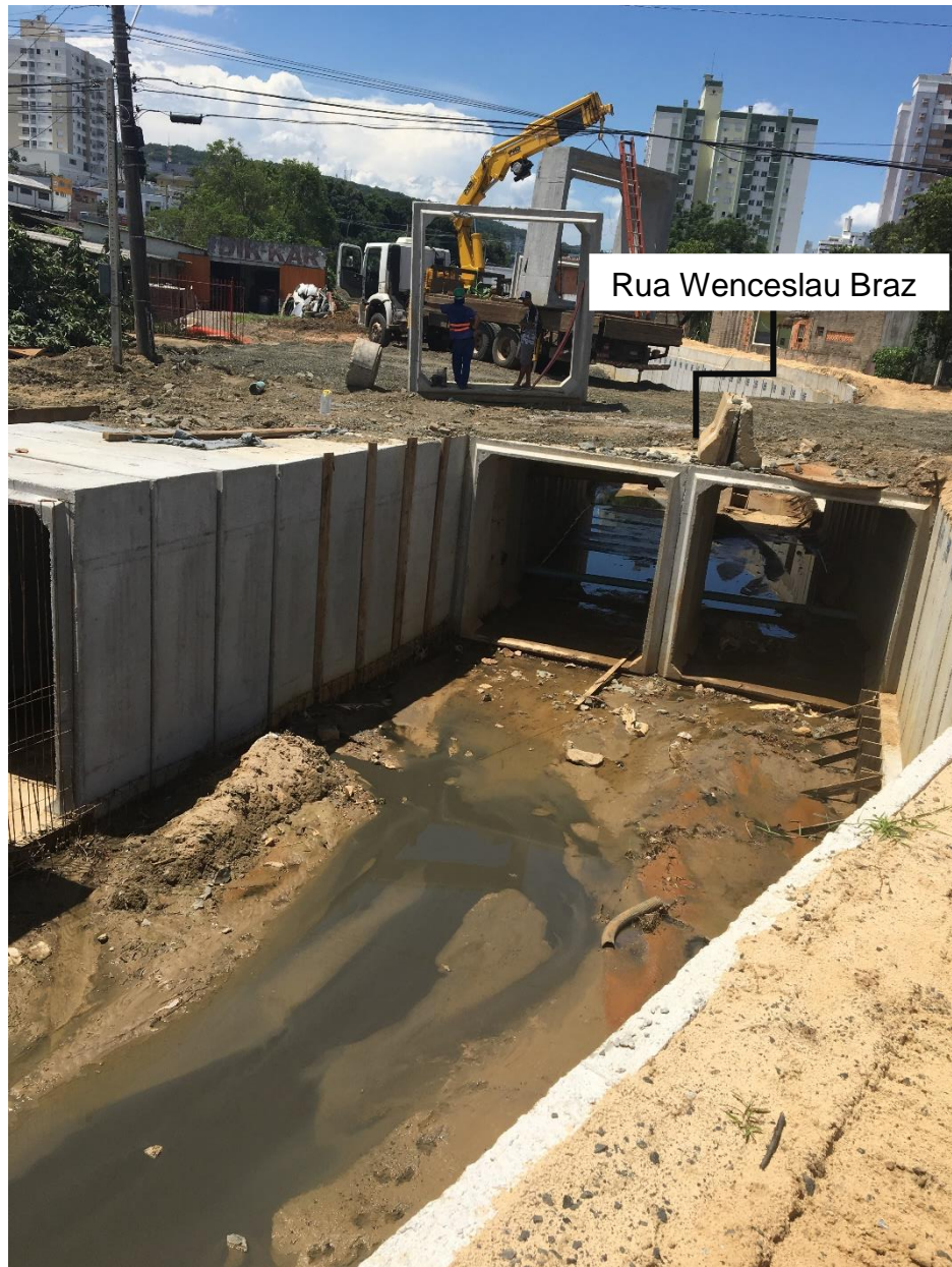
Figura 5: Prolongamento do canal auxiliar entre os lotes 01 e 02. (Fonte: Dos Autores 2019)
