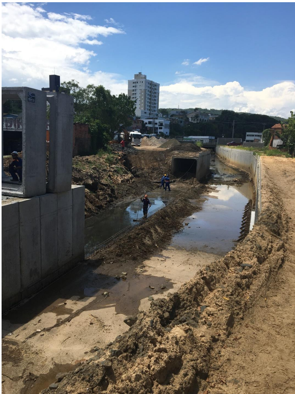
Figura 6: Trecho a ser concluído com a instalação de aduelas. (Fonte: Dos Autores 2019)
