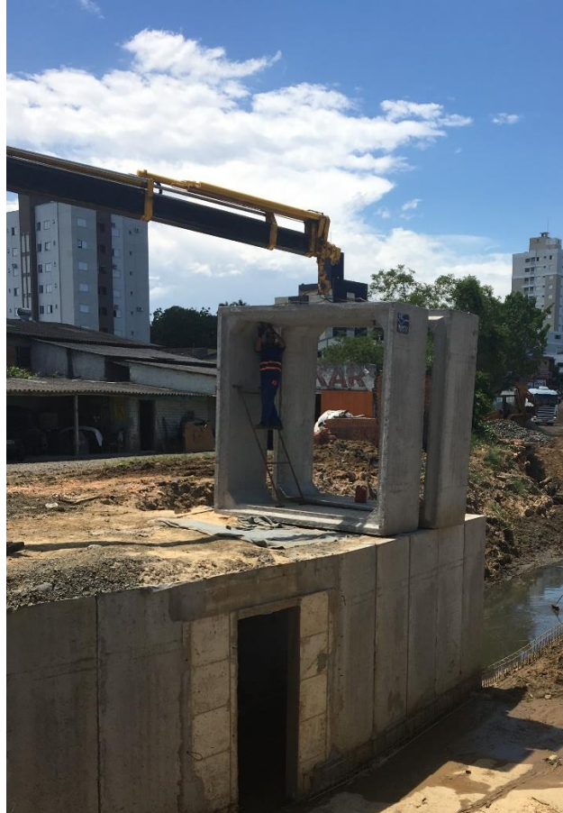
Figura 7: Aduelas sendo posicionadas para posterior instalação. (Fonte: Dos Autores 2019)
