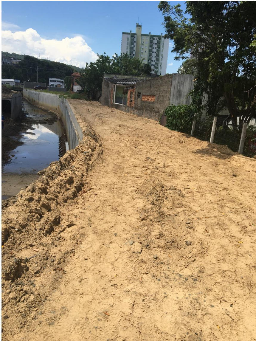
Figura 9: Região aterrada. (Fonte: Dos Autores 2019)
