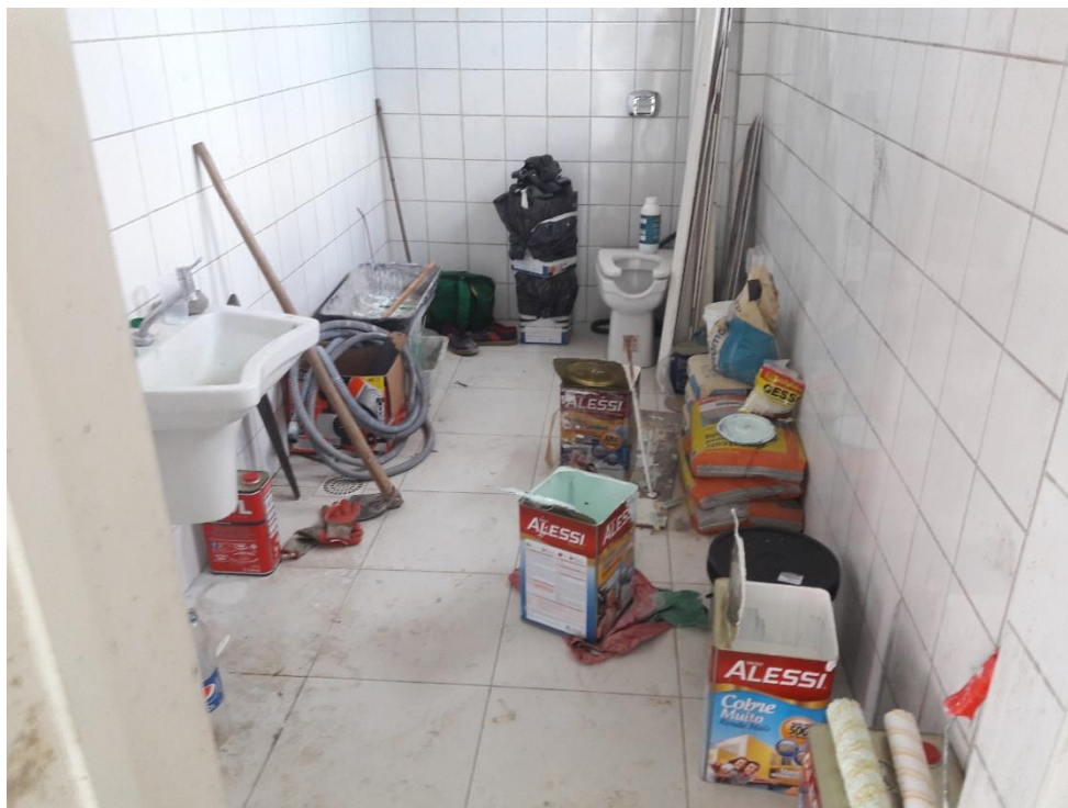
Figura 13: Estoque de materiais no sanitário
