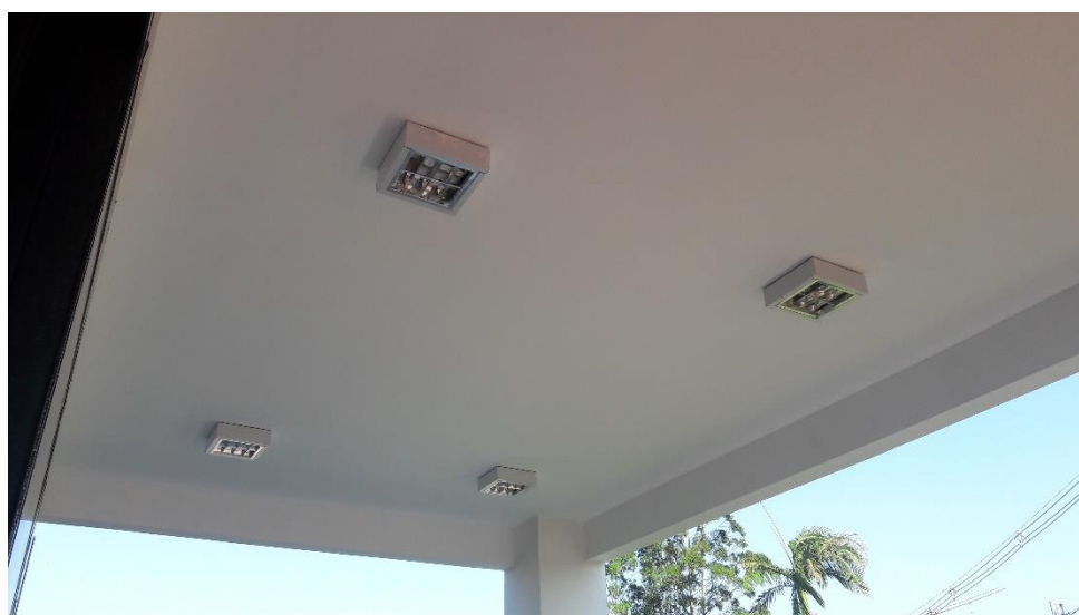
Figura 12: Serviço já finalizado, verificado na 2ª visita (Fonte: Autores)
