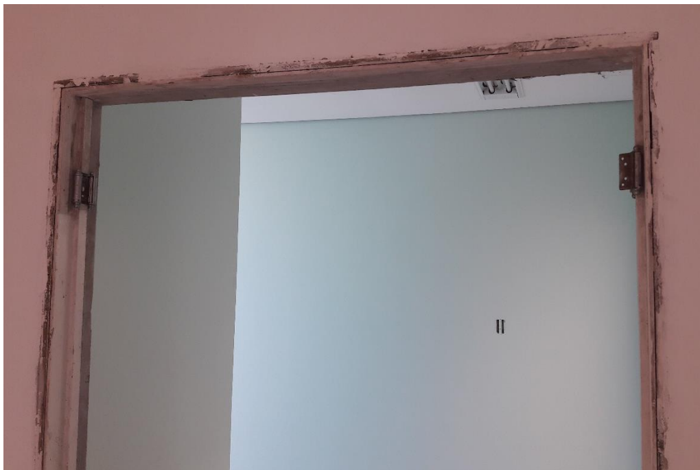
Figura 17: Marco instalado, verificado na 2ª visita (Fonte: Autores)
