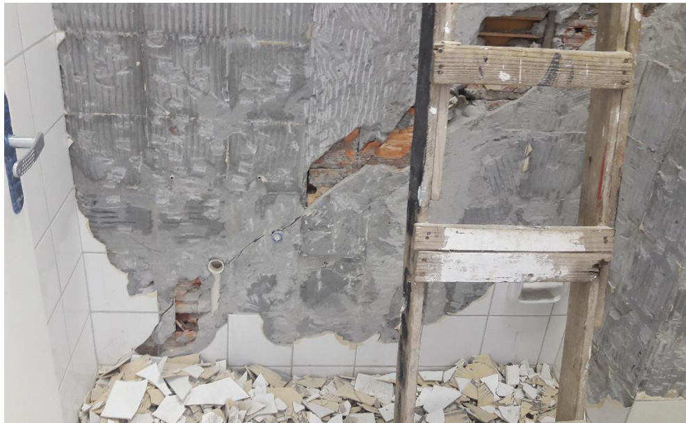
Figura 27: Remoção do azulejo no sanitário (Fonte: Autores)
