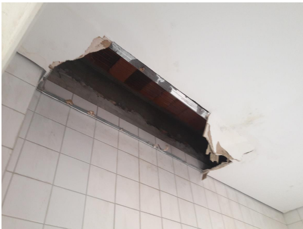
Figura 14: Forro sanitário na 1ª visita (Fonte: Autores)
