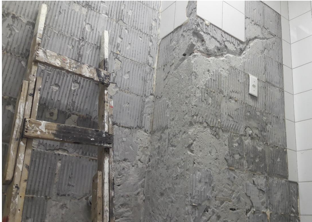
Figura 28: Remoção do azulejo no sanitário (Fonte: Autores)
