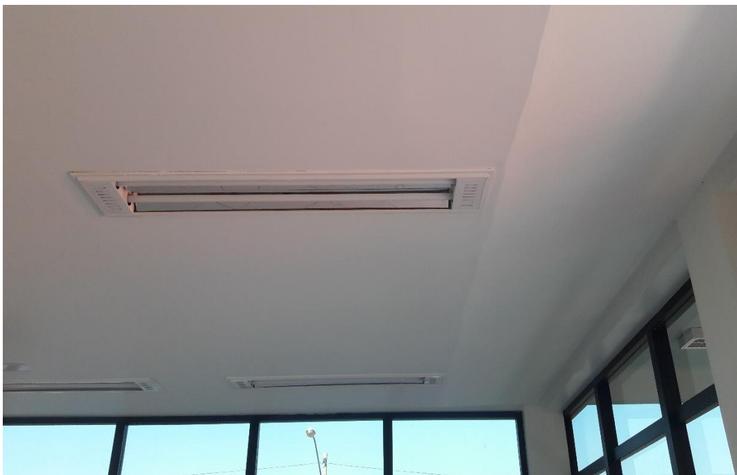
Figura 15: Forro reformado, verificado na 2ª visita (Fonte: Autores)
