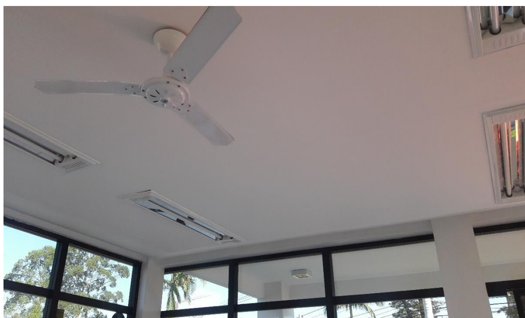
Figura 16: Forro reformado, verificado na 2ª visita (Fonte: Autores)
