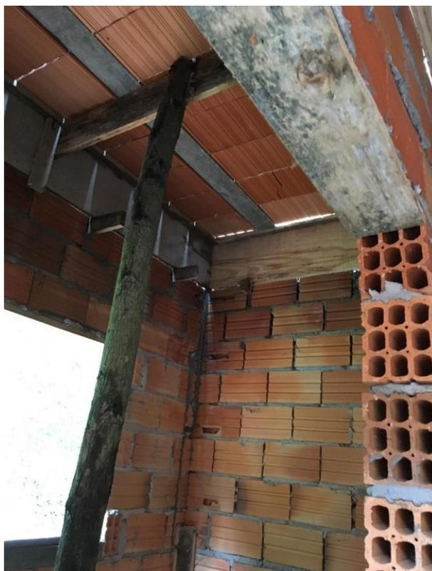
**Figura 11:** Estrutura da laje pré-moldada. (Fonte: Dos Autores 2018)
