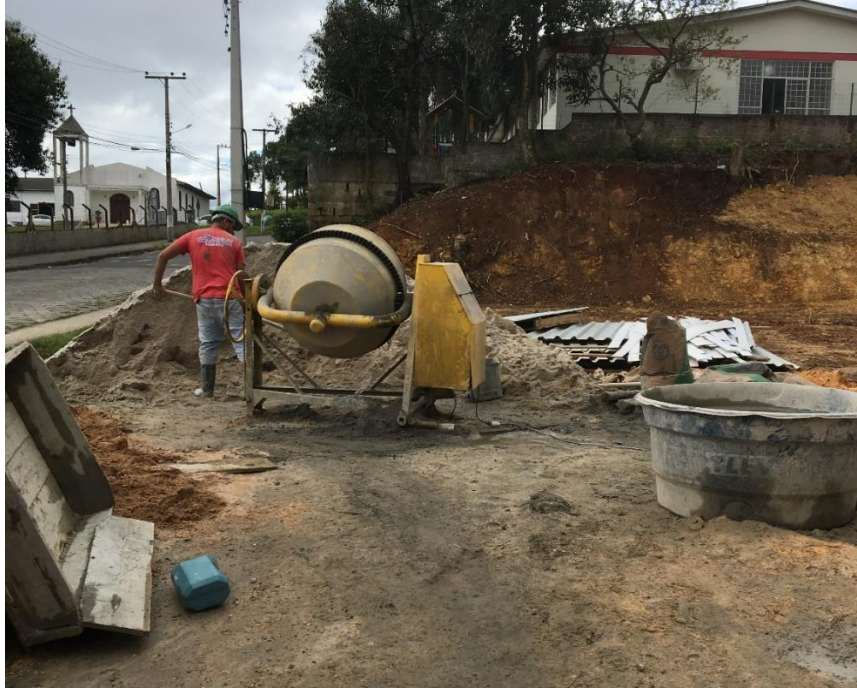
Figura 10: Execução de argamassa in loco . (Fonte: Dos Autores 2018)
