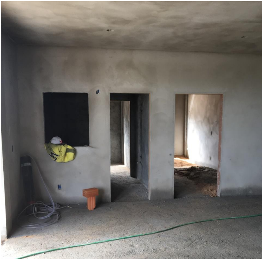
Figura 11: Argamassa de revestimento concluída. (Fonte: Dos Autores 2018)
