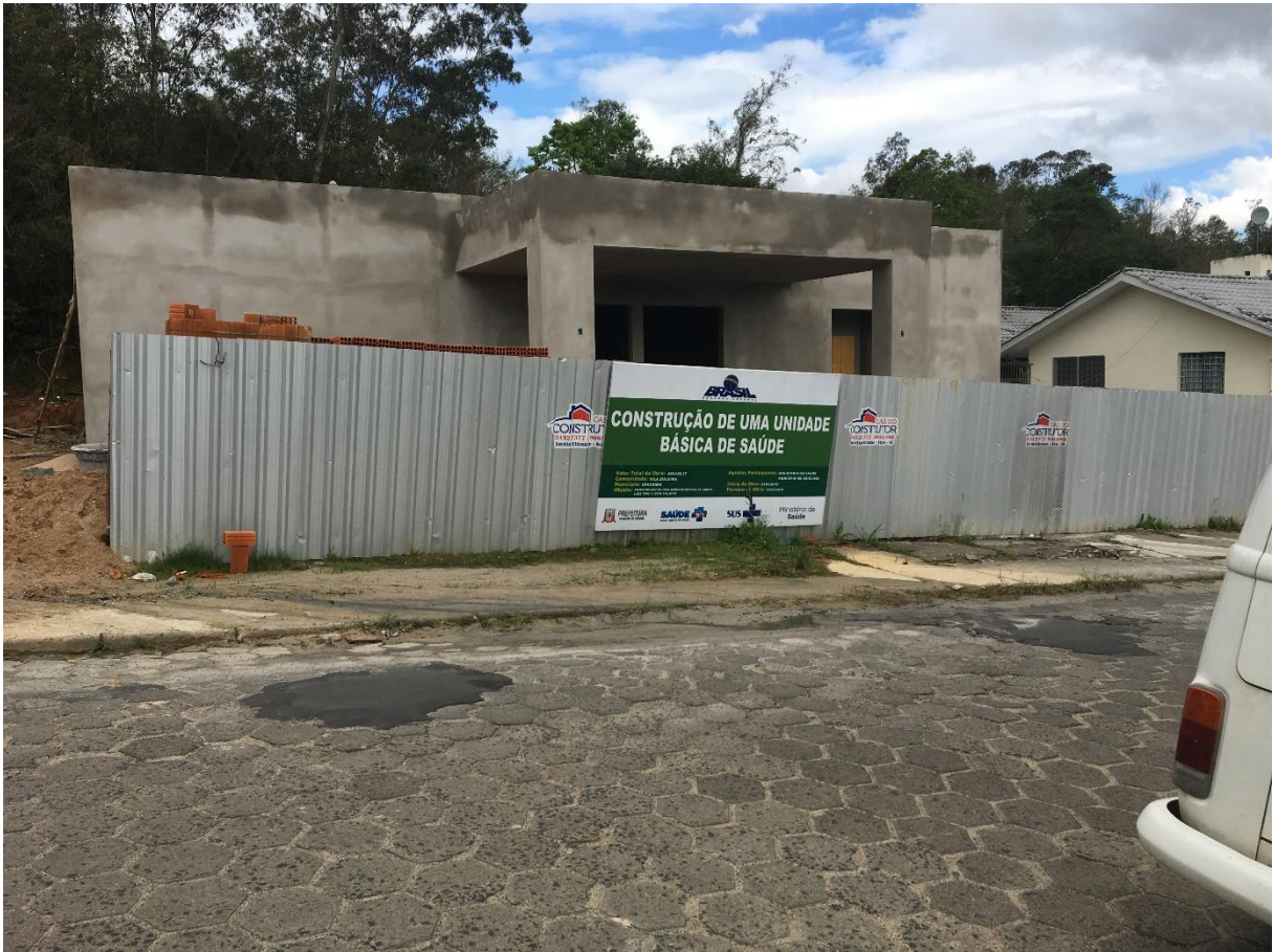
Figura 4: Vista frontal da unidade. (Fonte: Dos Autores 2018)
