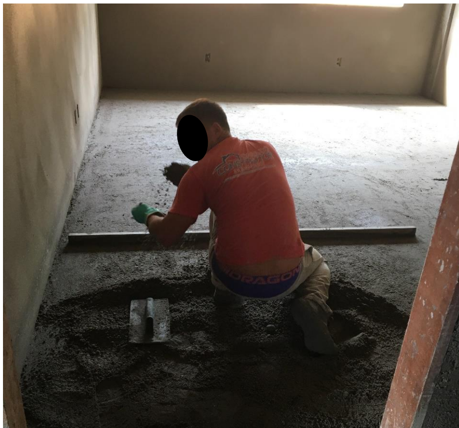
Figura 13: Execução do contrapiso. (Fonte: Dos Autores 2018)
