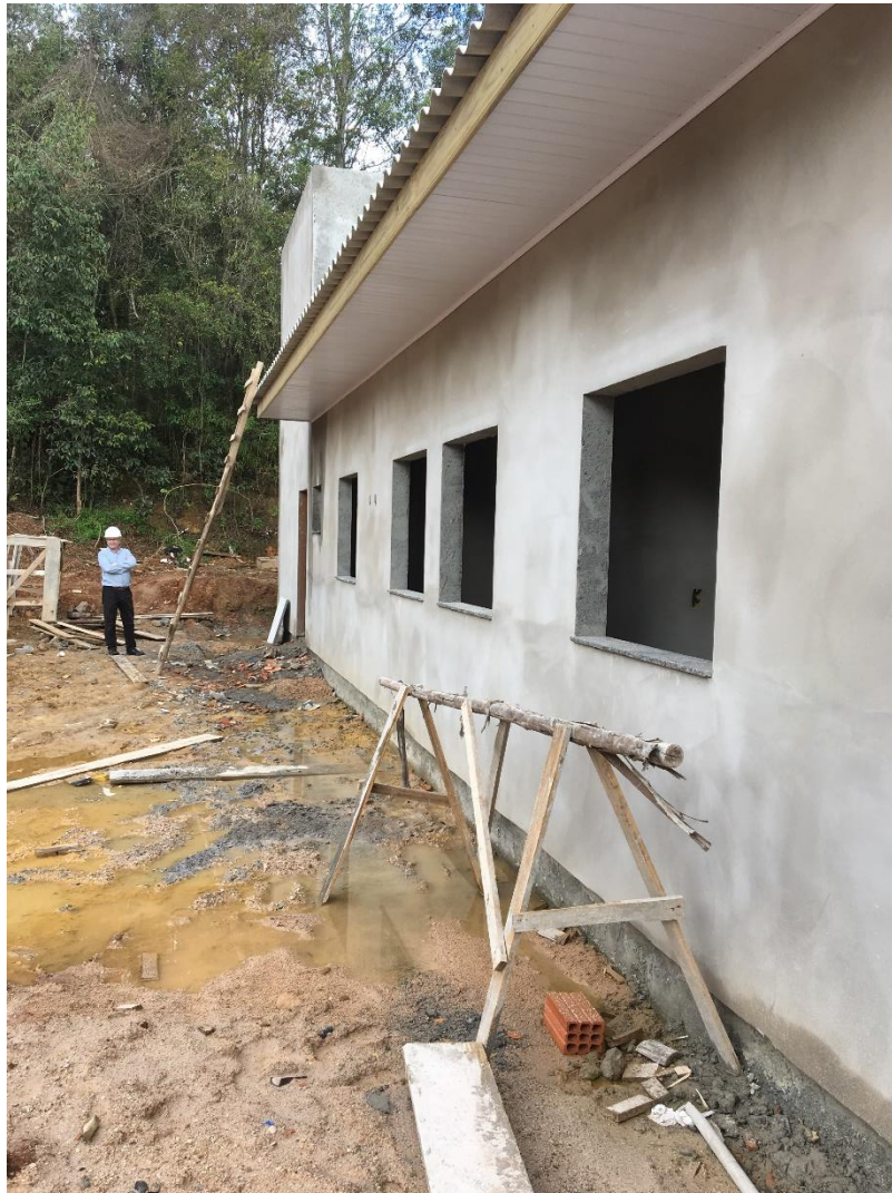
Figura 9: Forro do beiral do telhado. (Fonte: Dos Autores 2018)
