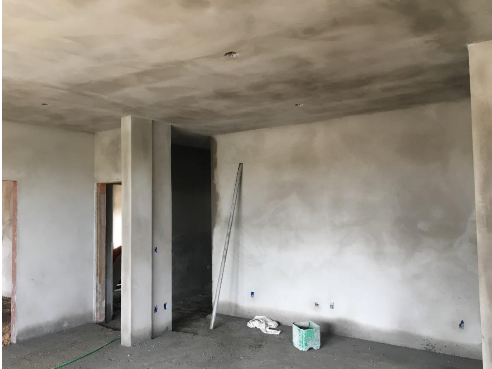
Figura 12: Argamassa de revestimento concluída. (Fonte: Dos Autores 2018)
