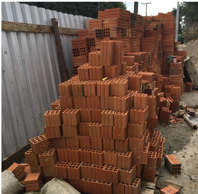
Figura 7: Tijolos armazenados corretamente em cima de paletes. (Fonte: Dos Autores 2018)
