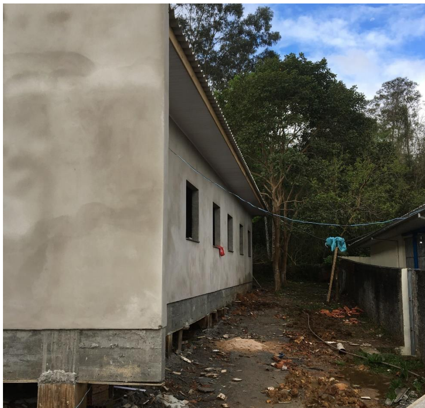
Figura 6: Fachada lateral. (Fonte: Dos Autores 2018)
