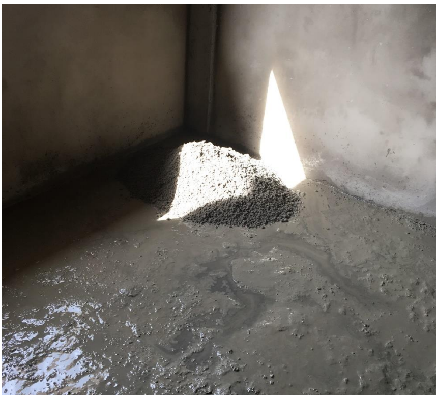
Figura 14: Massa para execução de contrapiso. (Fonte: Dos Autores 2018)
