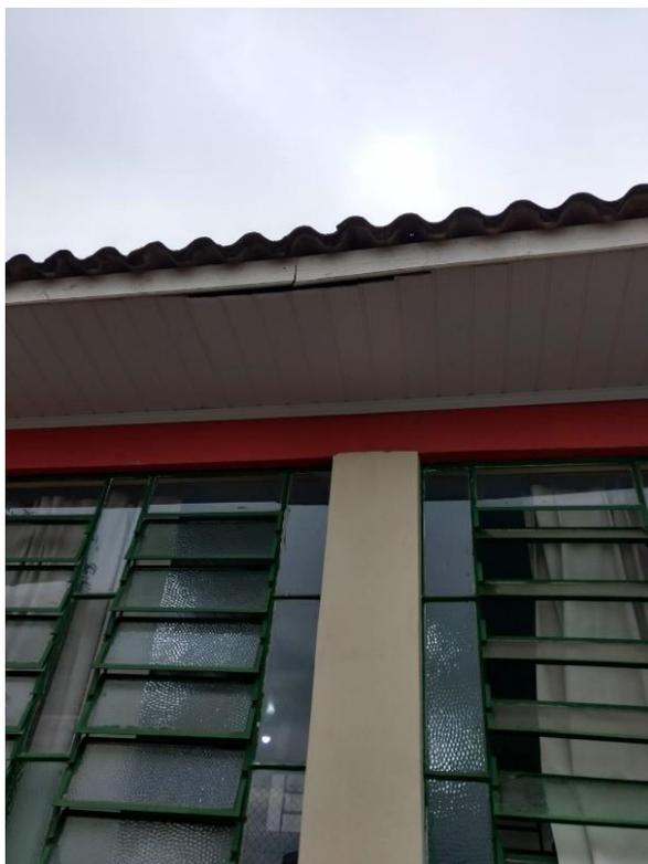
**Figura 8:** Rachadura no forro do beiral. (Fonte: Dos Autores 2018)
