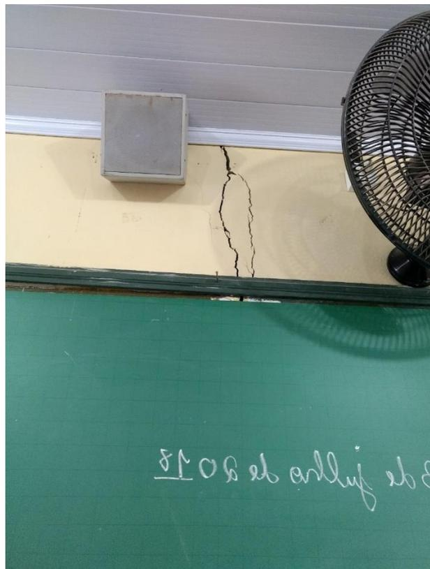
**Figura 11:** Rachadura na sala 03. (Fonte: Dos Autores 2018)
