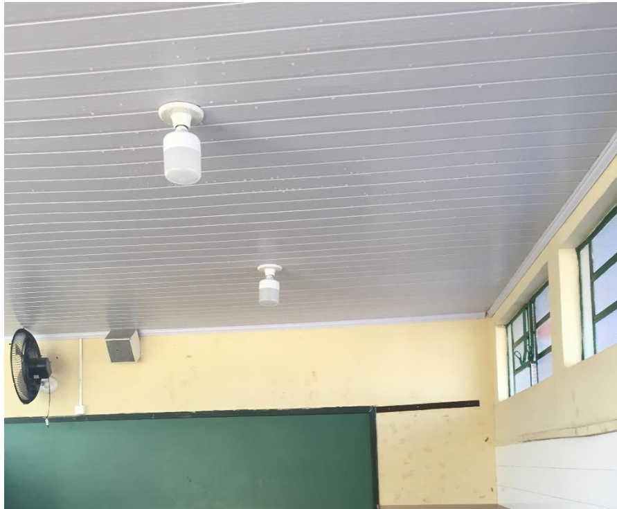
Figura 7: Forro de PVC e lâmpadas. (Fonte: Dos Autores 2018)
