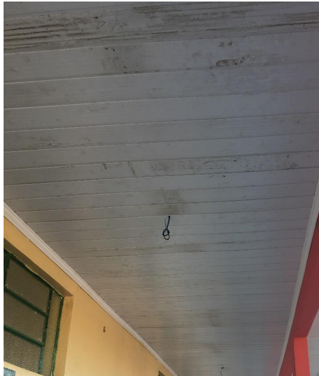
Figura 11: Forro de PVC reutilizado na região dos corredores. (Fonte: Dos Autores 2018)
