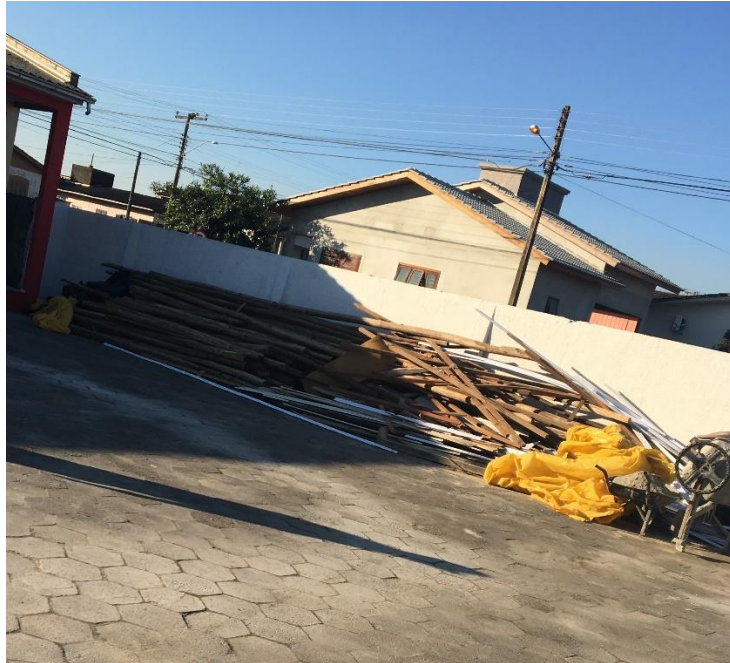
Figura 5: Madeiras da antiga armação do telhado. (Fonte: Dos Autores 2018)
