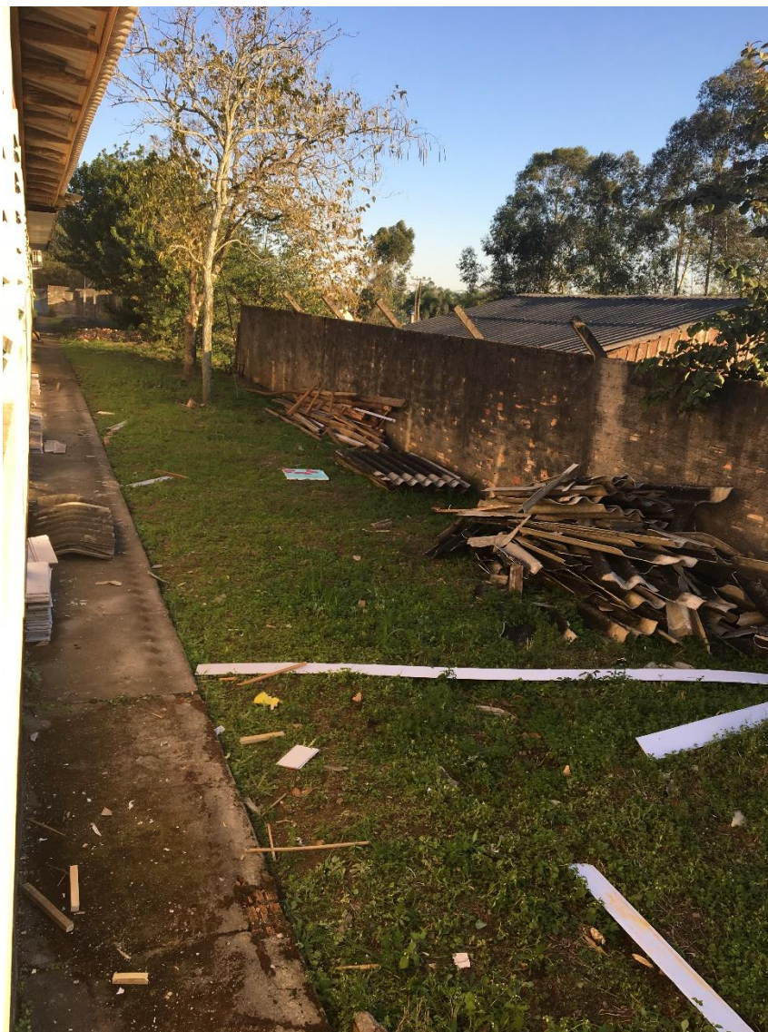
Figura 15: Região onde será construído o muro de arrimo. (Fonte: Dos Autores 2018)
