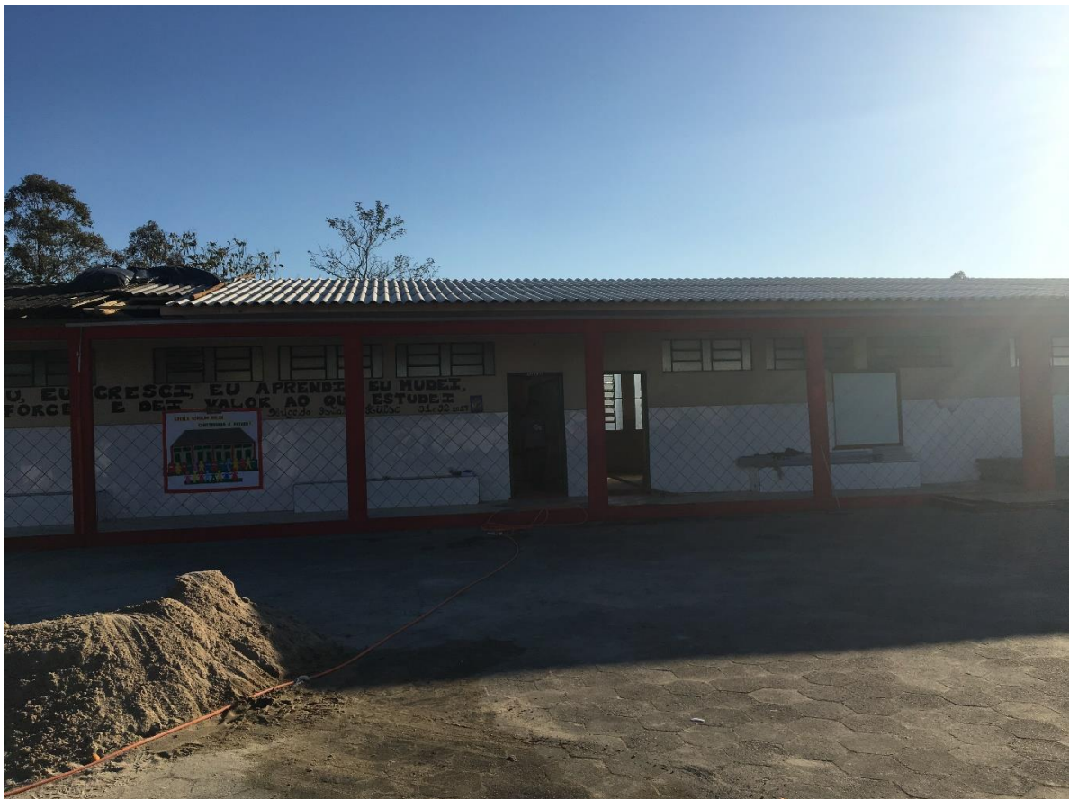
Figura 4: Parte da reforma do telhado já concluída. (Fonte: Dos Autores 2018)
