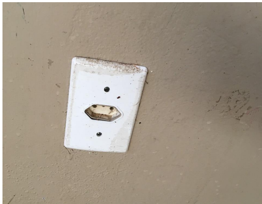
Figura 10: Tomada desgastada. (Fonte: Dos Autores 2018)
