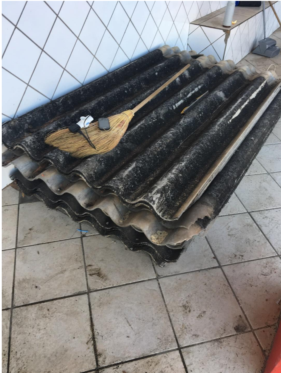
Figura 14: Peças retiradas do telhado que poderão ser reaproveitadas. (Fonte: Dos Autores 2018)
