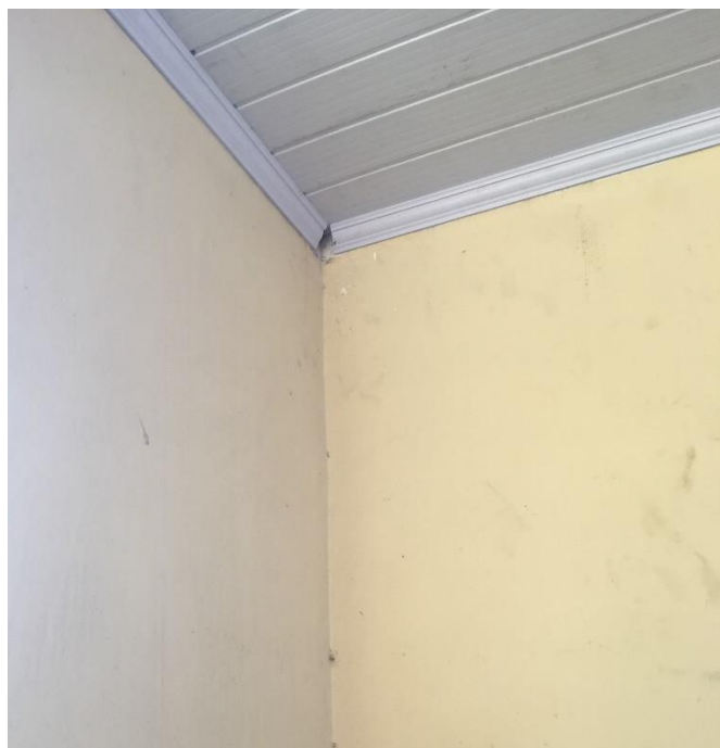
Figura 8: Junção de meia canas sem acabamento. (Fonte: Dos Autores 2018)
