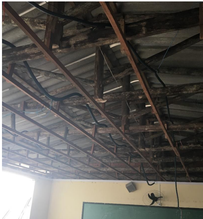
Figura 6: Nova armação do telhado. (Fonte: Dos Autores 2018)
