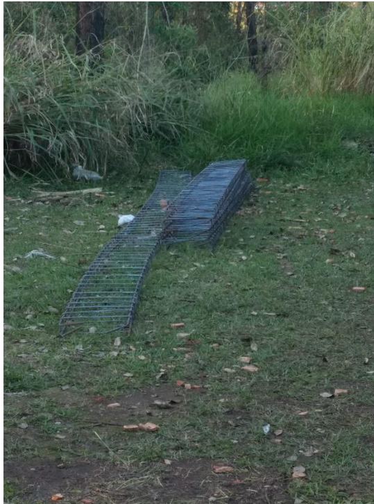
Figura 7: Ferragens das vigas. (Fonte: Dos Autores 2018)
