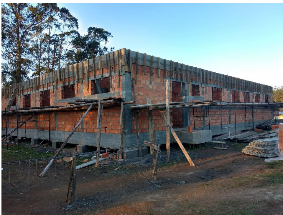
Figura 4: Vista lateral da unidade de saúde. (Fonte: Dos Autores 2018)
