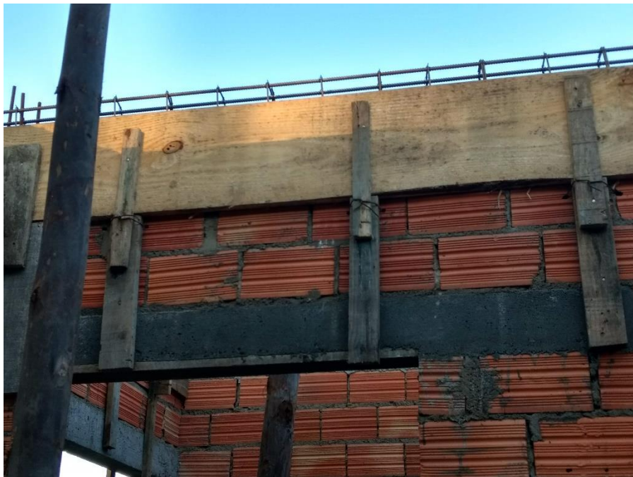
Figura 6: Forma e ferragens da viga. (Fonte: Dos Autores 2018)
