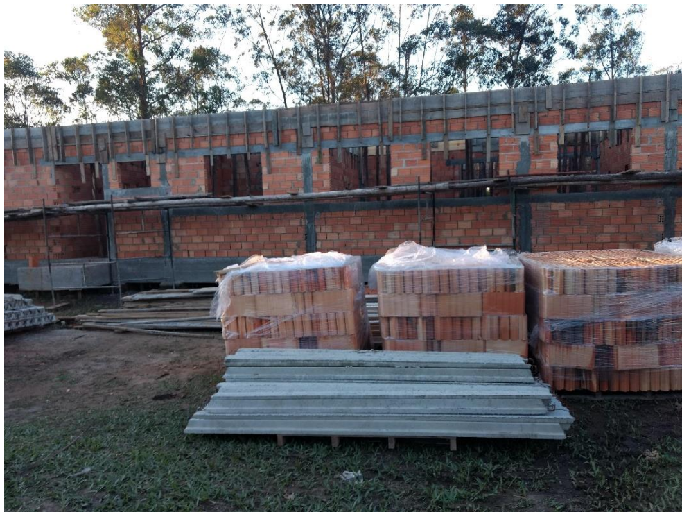
Figura 8: Armazenamento de materiais. (Fonte: Dos Autores 2018)
