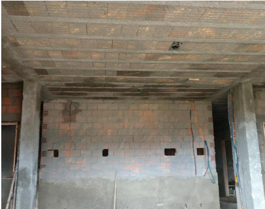
Figura 8: Região interna da construção. (Fonte: Dos Autores 2018)
