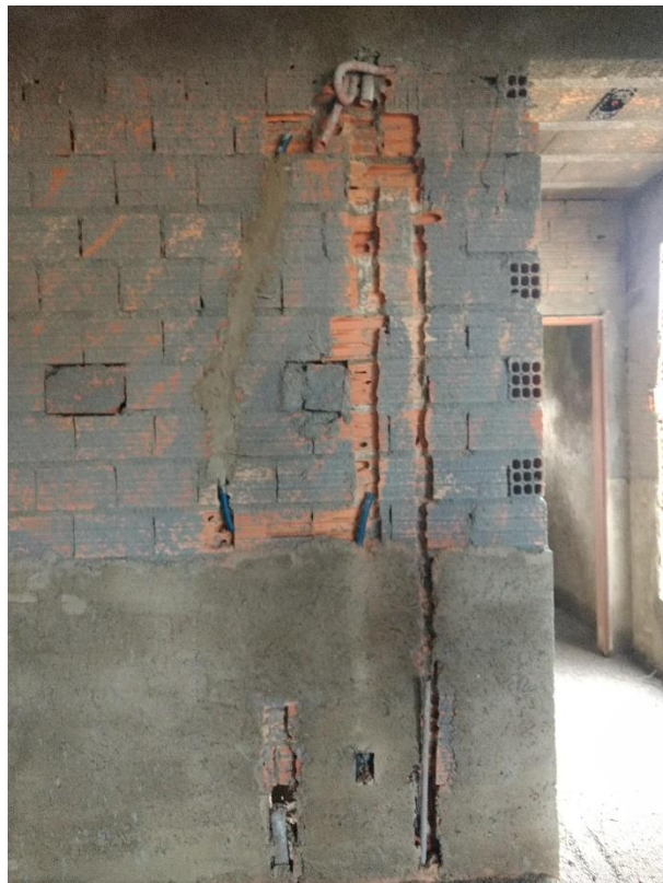
Figura 11: Abertura para instalação de eletrodutos. (Fonte: Dos Autores 2018)
