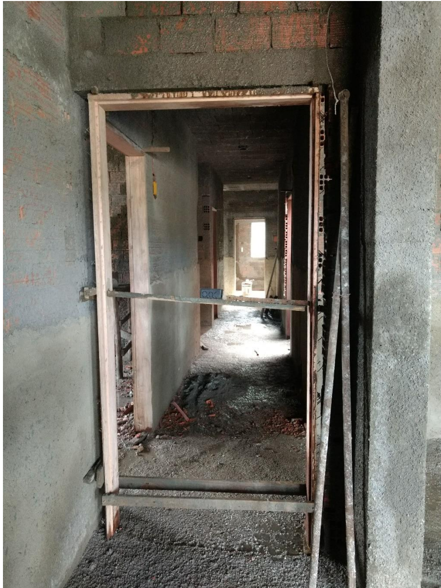
Figura 10: Instalação do marco da porta. (Fonte: Dos Autores 2018)
