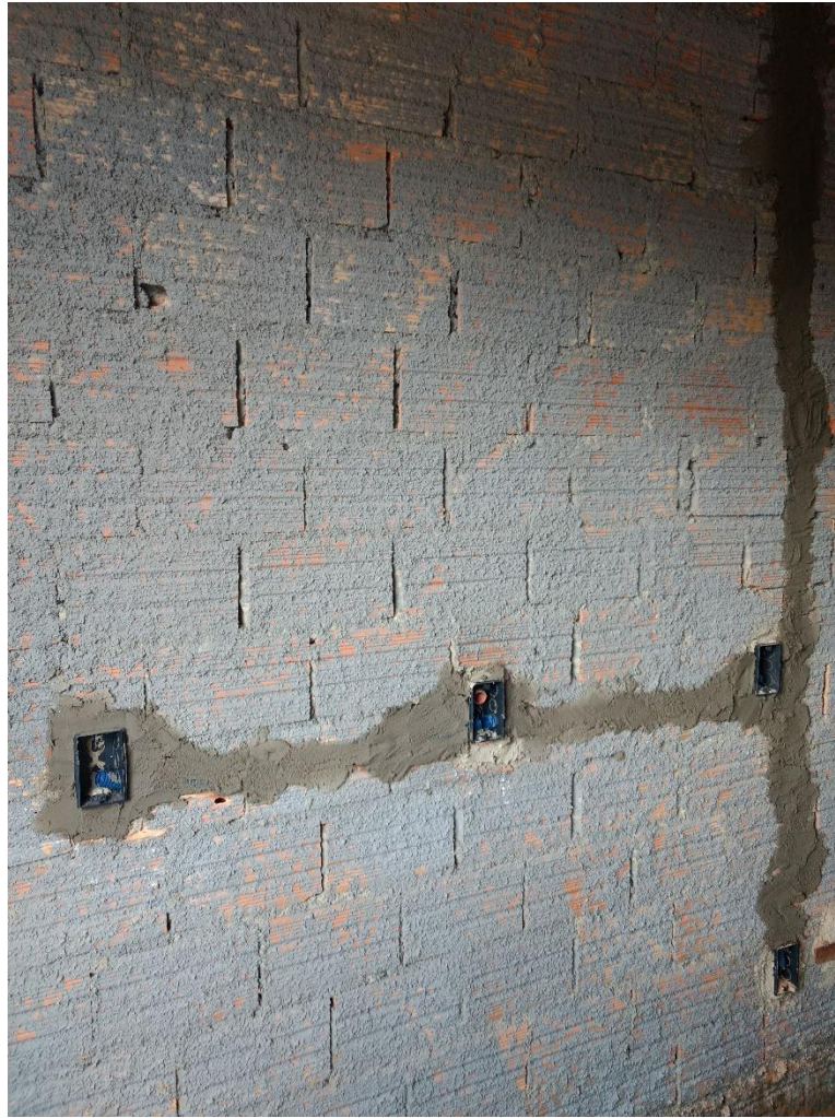
Figura 13: Instalação dos eletrodutos finalizada. (Fonte: Dos Autores 2018)
