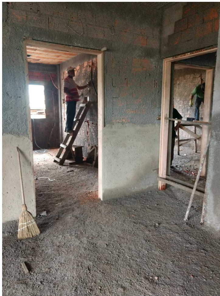
Figura 9: Massa de emboço em processo de execução. (Fonte: Dos Autores 2018)
