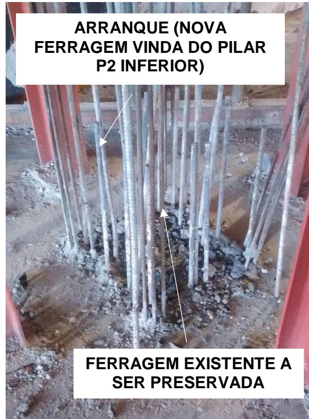
Figura 15: Ferragens do pilar P2. (Fonte: Dos autores 2016)
