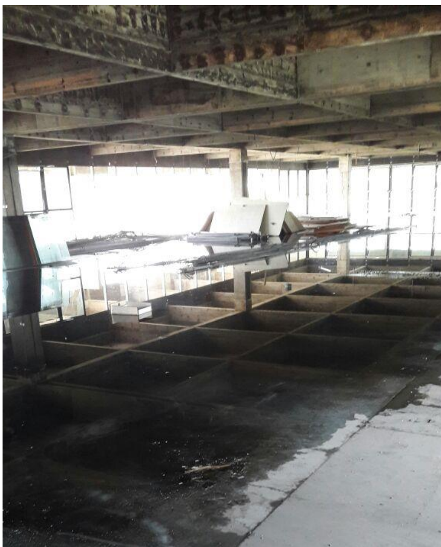
Figura 25: Limpeza do Paço Municipal Marcos Rovaris concluída. (Fonte: Dos autores 2016)
