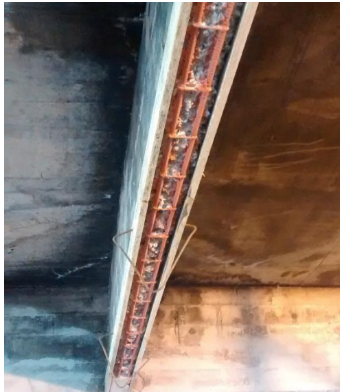
Figura 19: Detalhe recuperação de uma das vigas. (Fonte: Dos autores 2016)
