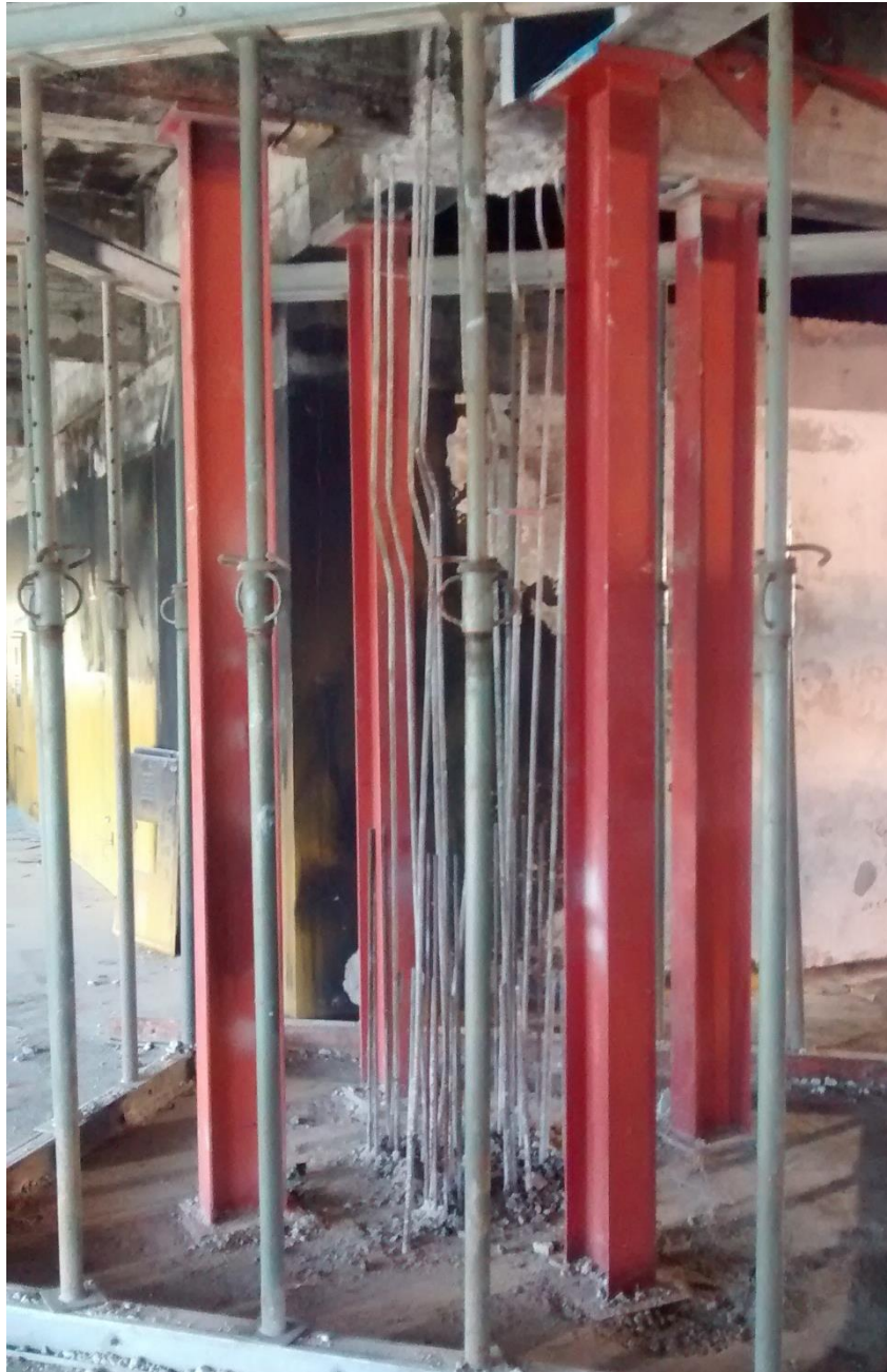
Figura 14: Pilar P2 demolido. (Fonte: Dos autores 2016)
