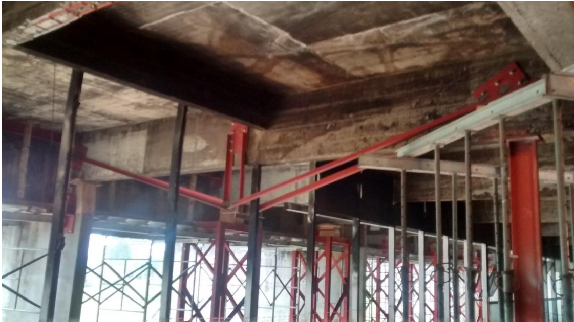
Figura 17: Reforço provisório da viga V16. (Fonte: Dos autores 2016)
