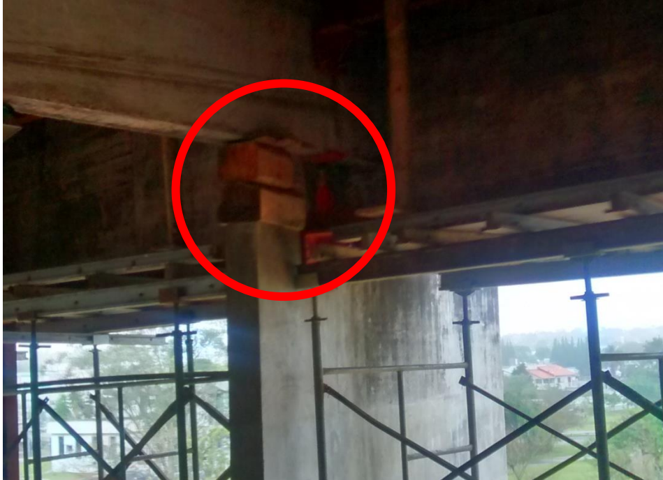
Figura 23: Detalhe do escoramento próximo ao macaco hidráulico. (Fonte: Dos autores 2016)
