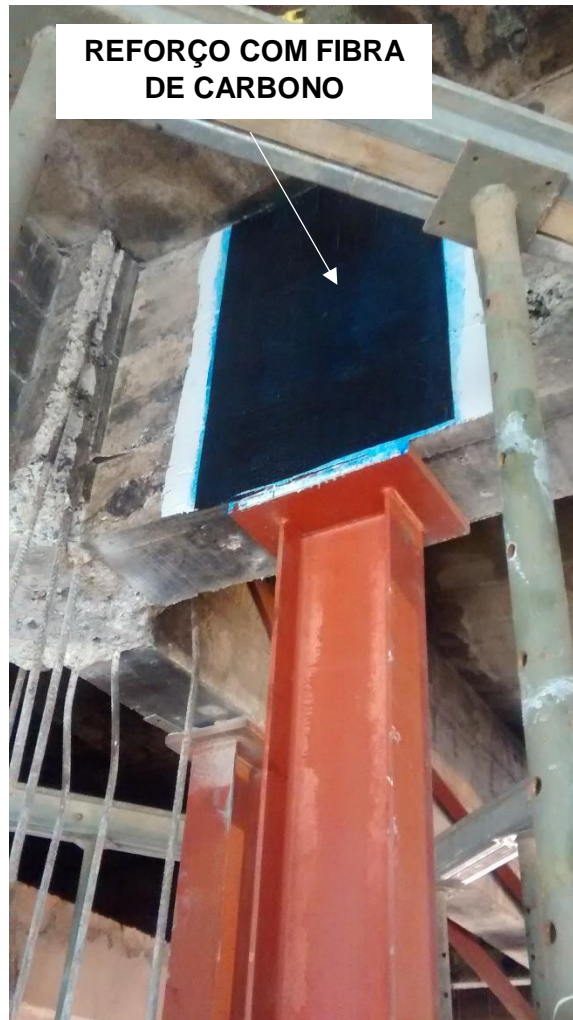
Figura 09: Escoramento dos pilares afetados. (Fonte: Dos autores 2016)
