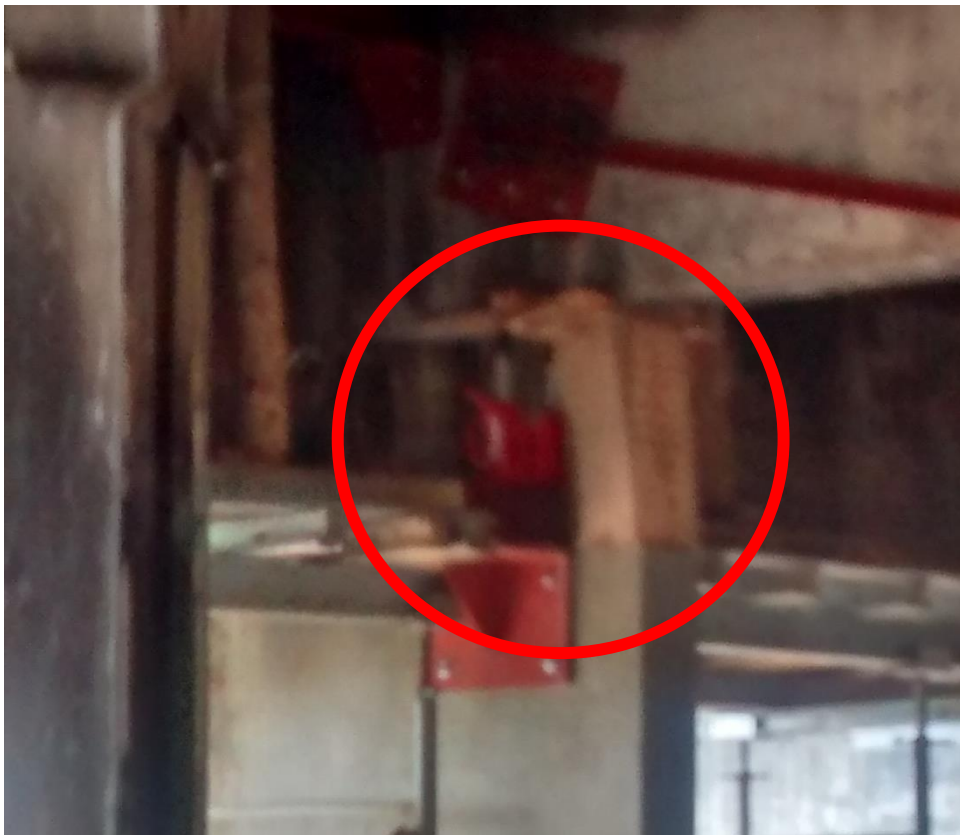
Figura 24: Detalhe do escoramento próximo ao macaco hidráulico. (Fonte: Dos autores 2016)
