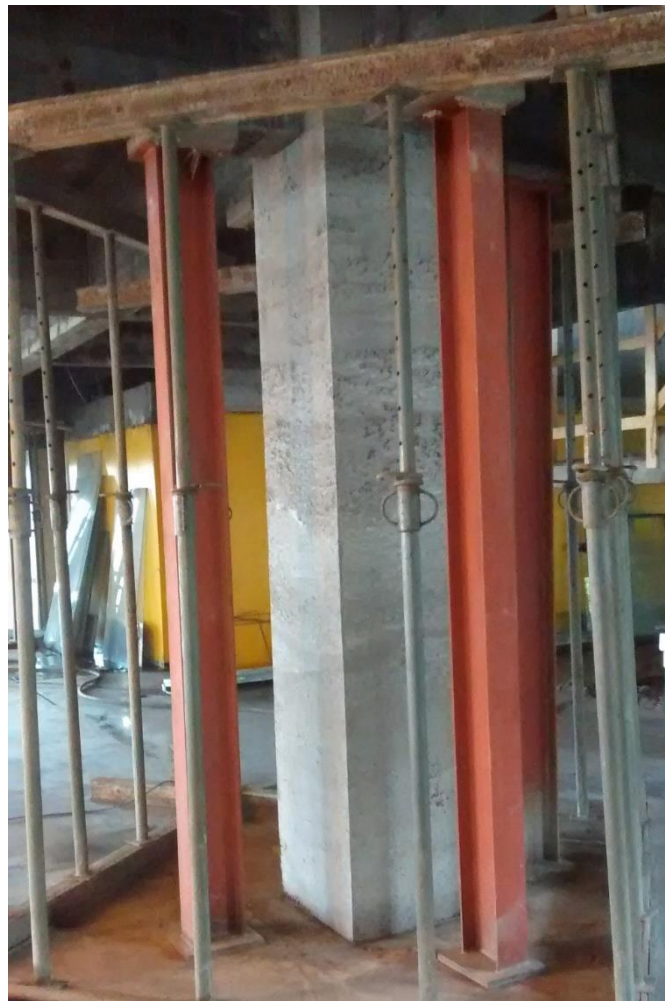
Figura 10: Pilar P6 recuperado. (Fonte: Dos autores 2016)
