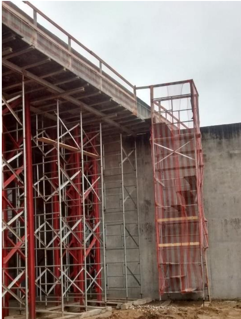
Figura 07: Estruturas metálicas, guarda-corpo e dispositivo de acesso. (Fonte: Dos autores 2016)
