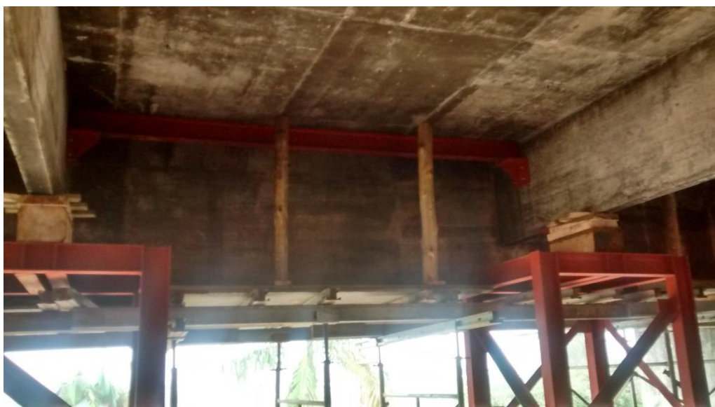
Figura 22: Escoramentos das vigas com calços de madeiras. (Fonte: Dos autores 2016)
