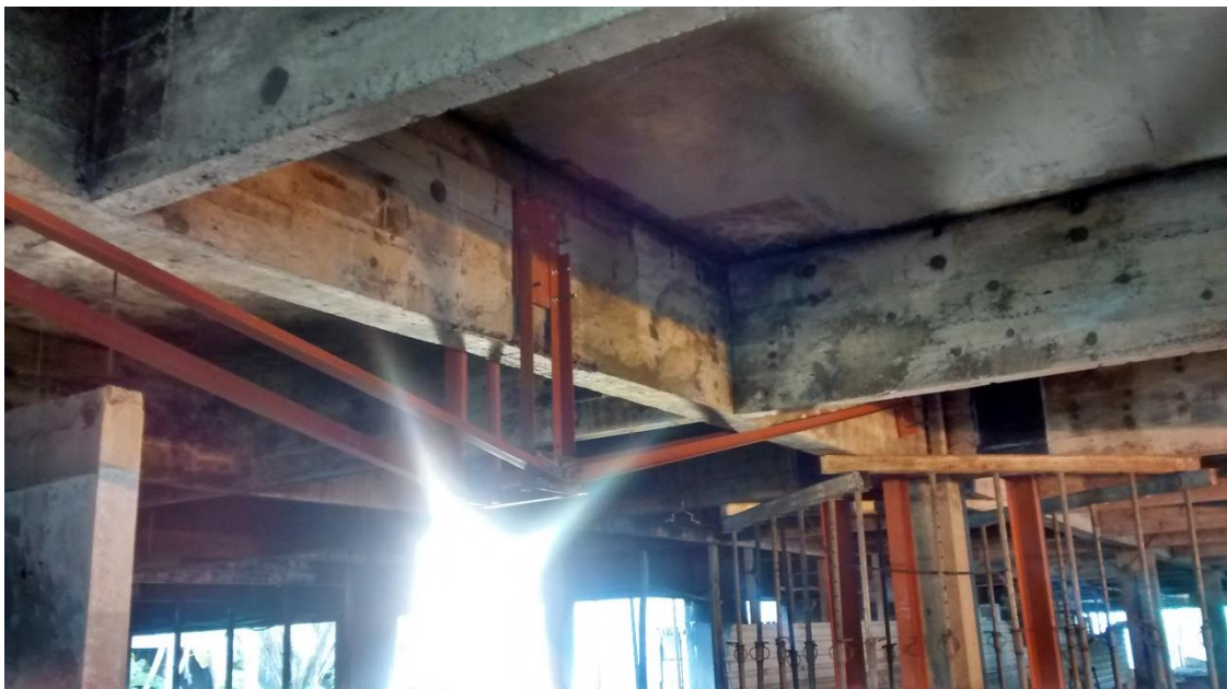
Figura 18: Reforço provisório da viga V16. (Fonte: Dos autores 2016)
