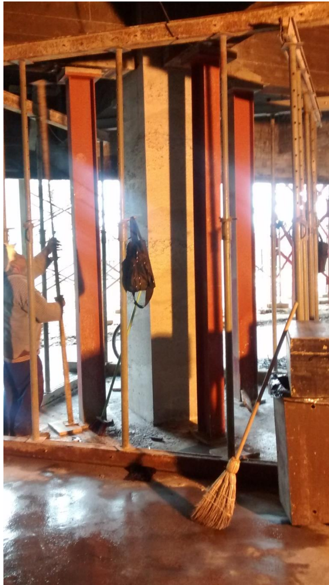
Figura 08: Escoramento dos pilares afetados. (Fonte: Dos autores 2016)
