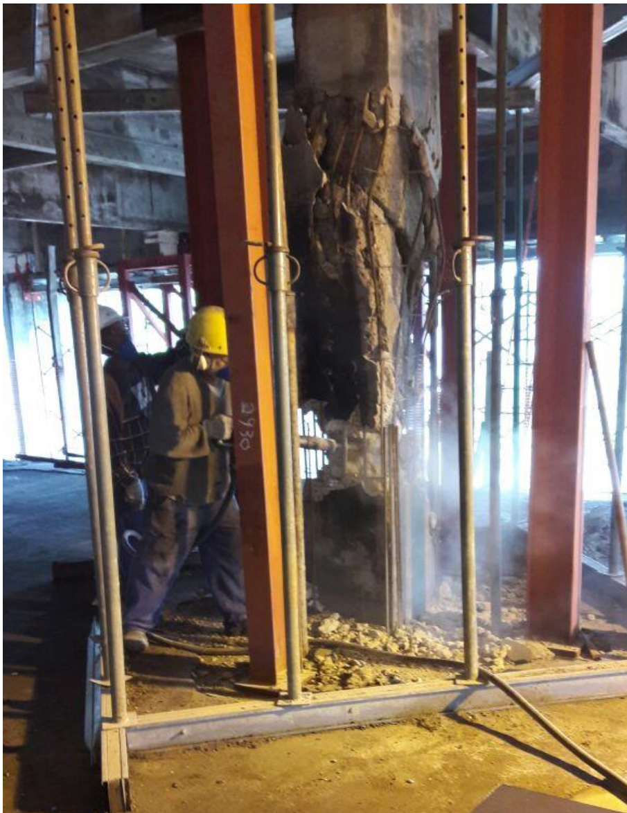
Figura 13: Demolição do pilar P7. (Fonte: Dos autores 2016)
