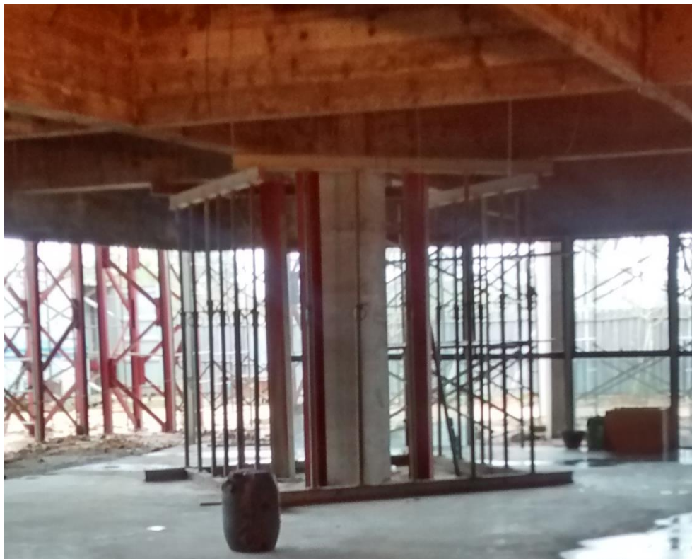
Figura 12: Recuperação pilar P1. (Fonte: Dos autores 2016)
