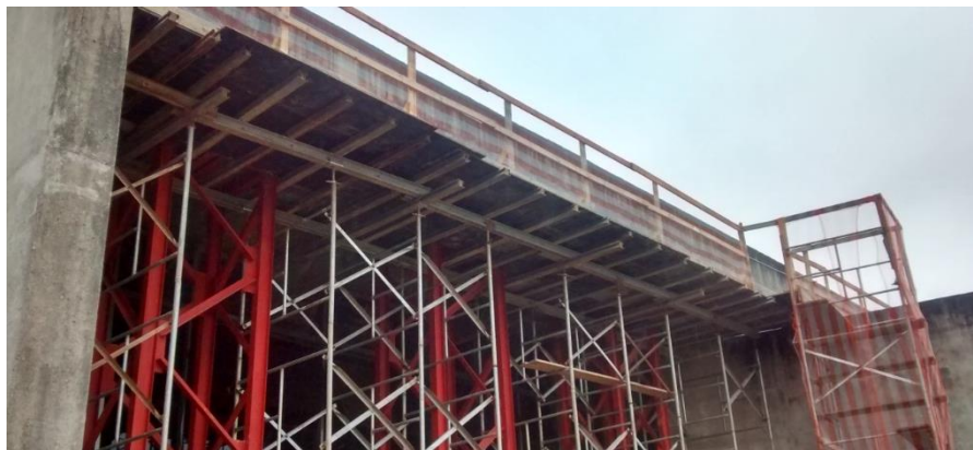
Figura 05: Estruturas metálicas de apoio. (Fonte: Dos autores 2016)
