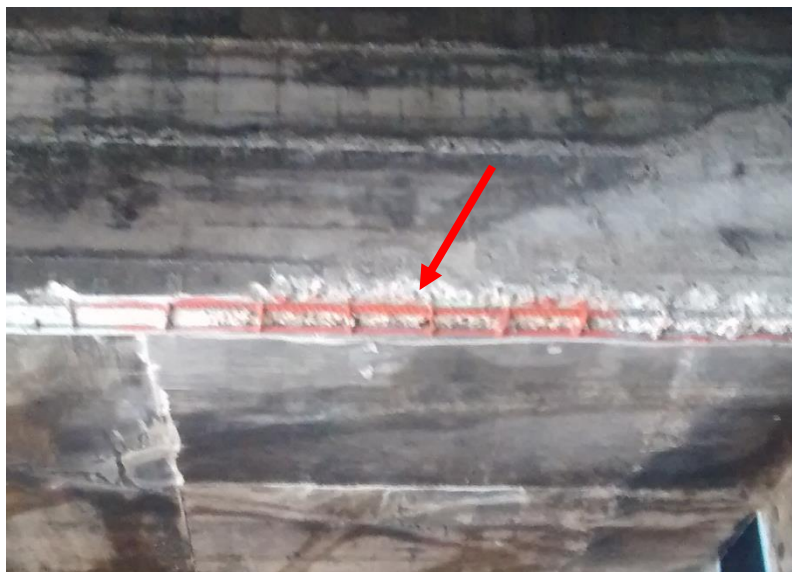
Figura 21: Detalhe tratamento das armaduras. (Fonte: Dos autores 2016)
