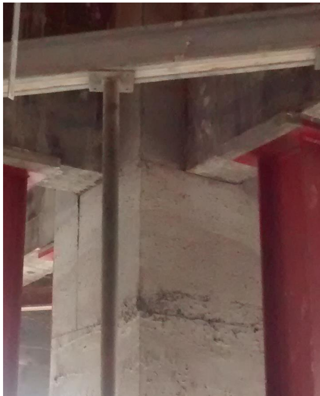
Figura 09: Detalhe de um dos pilares após sua recomposição. (Fonte: Dos autores 2016)
