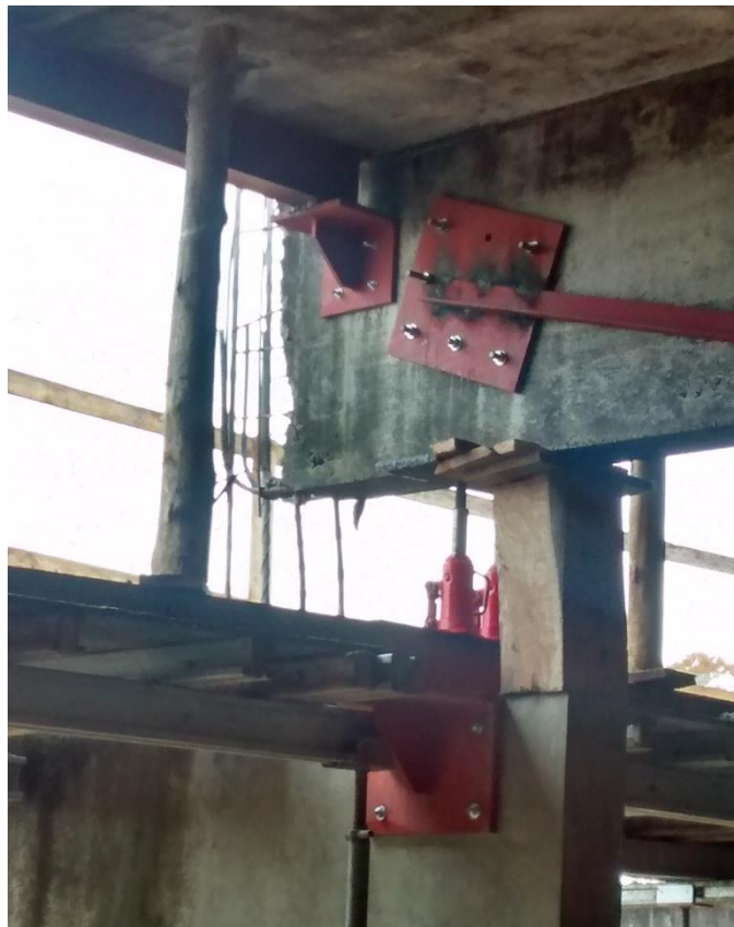
Figura 24: Detalhe da demolição complementar de 18 cm. (Fonte: Dos autores 2016)
