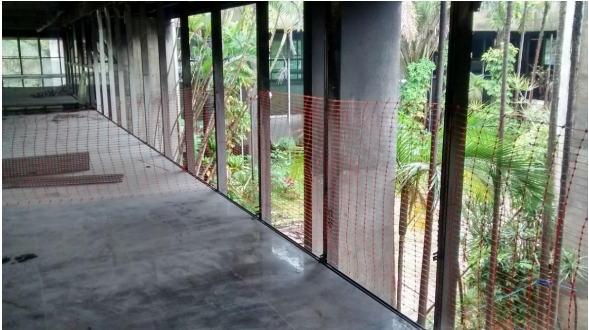
Figura 31: Tela de isolamento instalada na área de execução das obras. (Fonte: Dos autores 2016)
