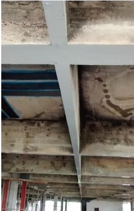
Figura 11: Detalhe das vigas após aplicação do regularizador de superfície. (Fonte: Dos autores 2016)
