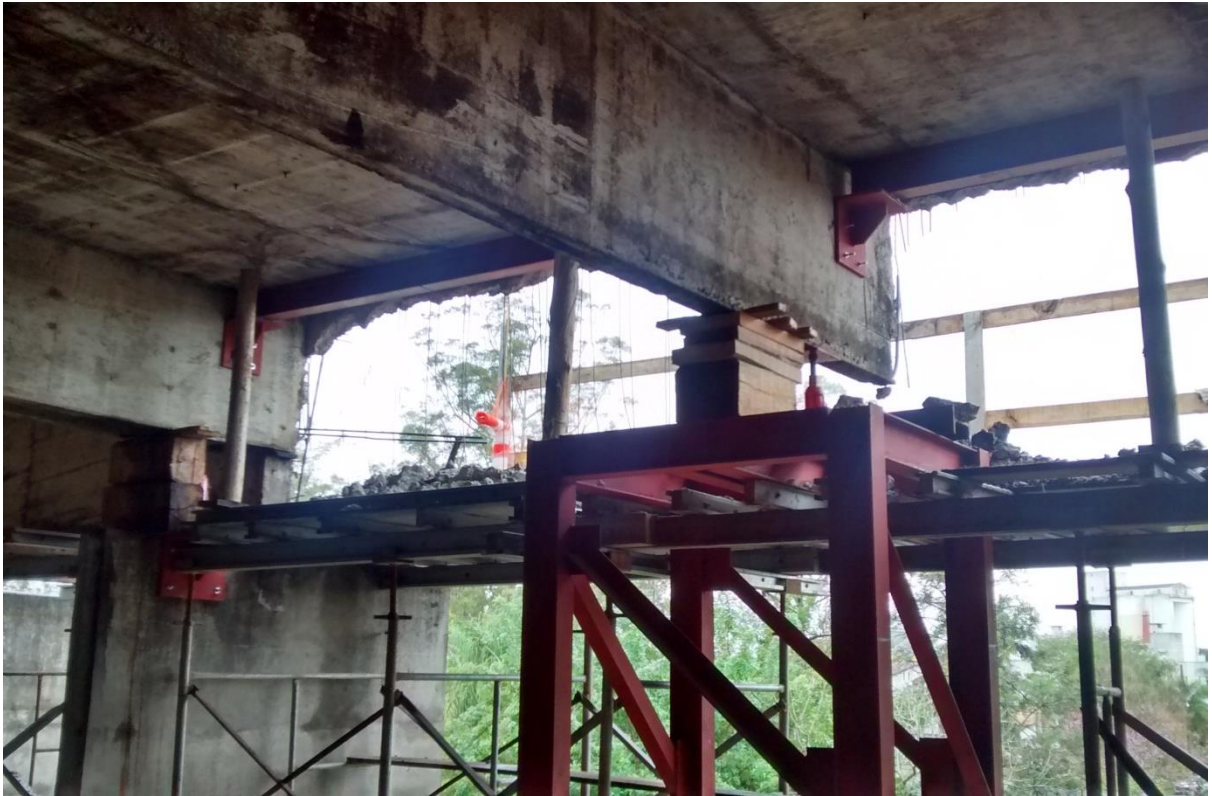
Figura 27: Vista interna da demolição da viga de bordo V11. (Fonte: Dos autores 2016)
