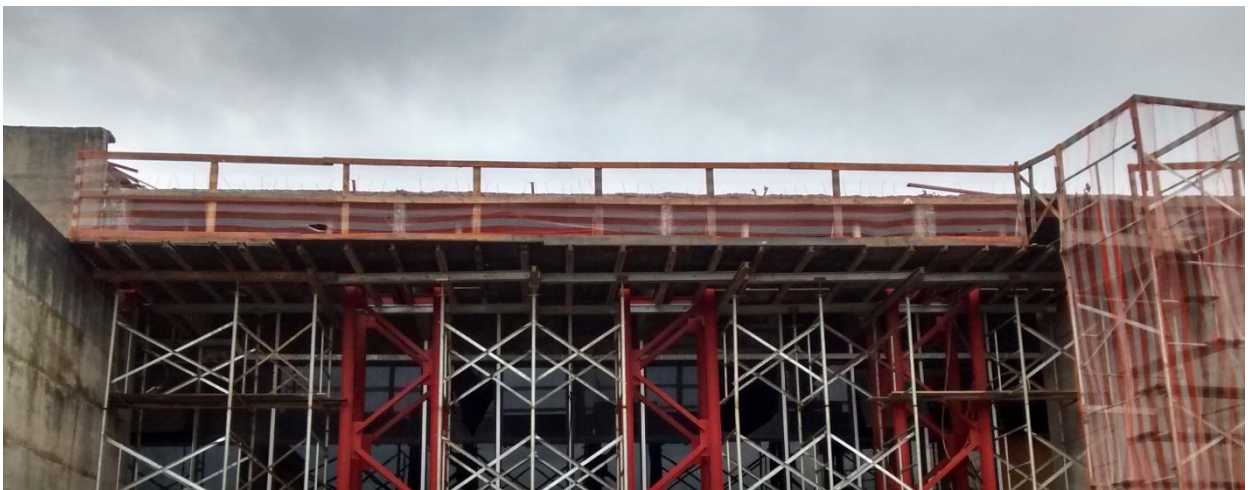
Figura 26: Vista externa da demolição da viga de bordo V1. (Fonte: Dos autores 2016)
