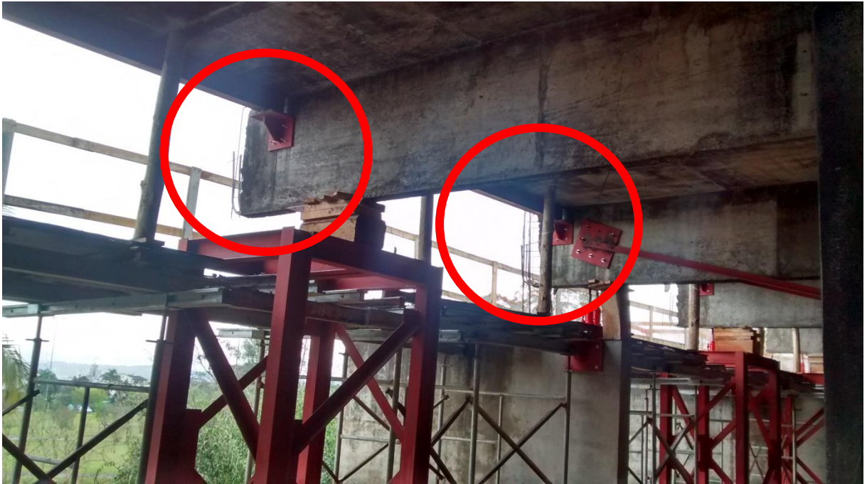
Figura 23: Detalhe da demolição complementar de 18 cm. (Fonte: Dos autores 2016)
