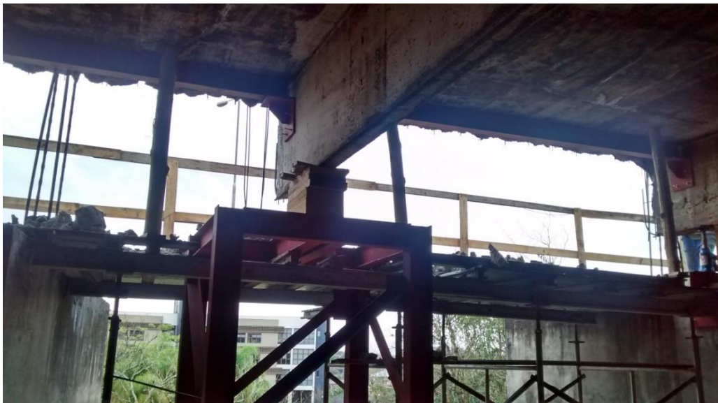
Figura 20: Viga de bordo V1 após demolição. (Fonte: Dos autores 2016)
