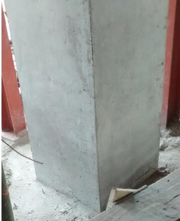
Figura 08: Detalhe da base de um dos pilares após sua recomposição. (Fonte: Dos autores 2016)
