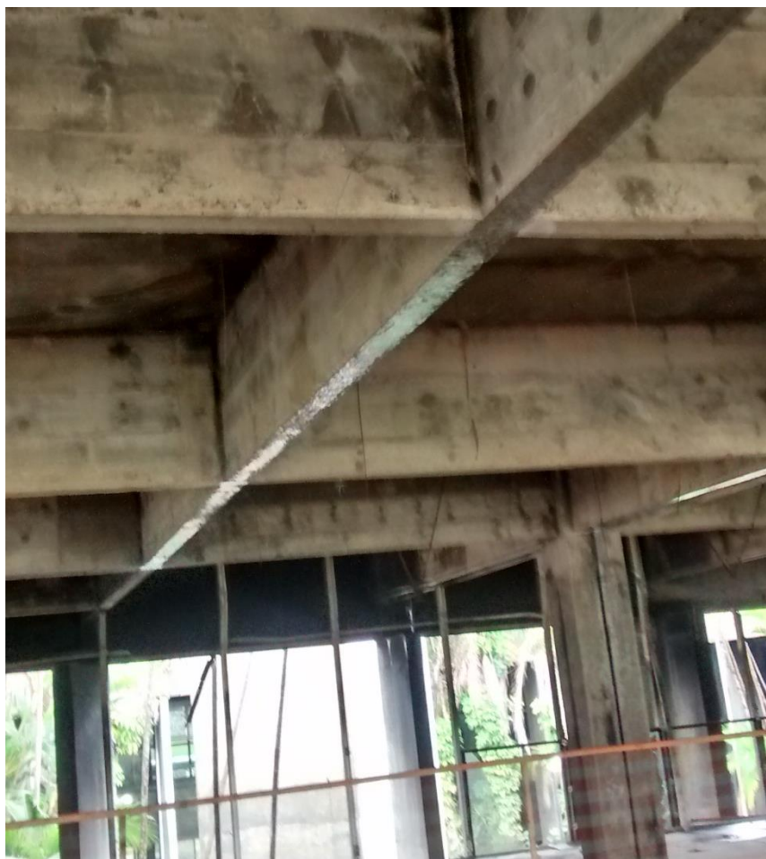
Figura 10: Vigas recebendo a aplicação do imprimador primário. (Fonte: Dos autores 2016)
