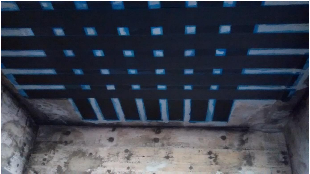
Figura 16: Detalhe dos reforços com fibra de carbono. (Fonte: Dos autores 2016)
