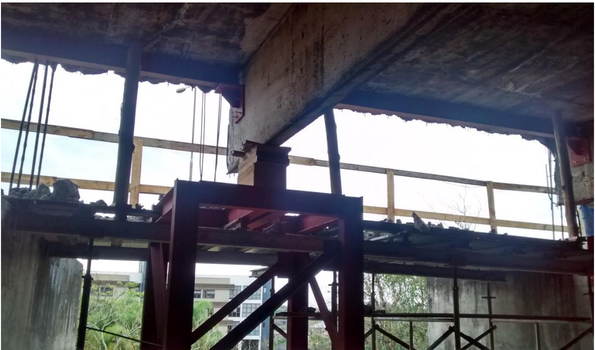
Figura 28: Detalhe do apoio de uma das vigas na estrutura metálica. (Fonte: Dos autores 2016)
