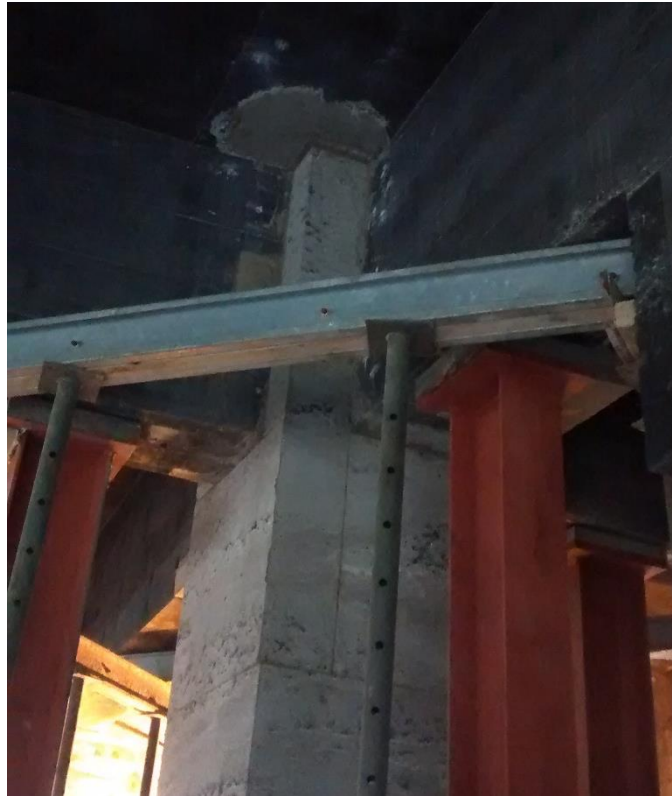
Figura 06: Detalhe do pilar ultrapassando a laje de cobertura. (Fonte: Dos autores 2016)
