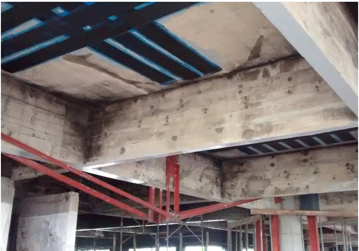
Figura 14: Reforços com fibra de carbono aplicados nas lajes. (Fonte: Dos autores 2016)
