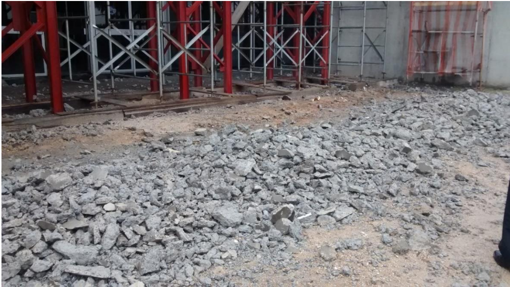
Figura 19: Resíduos resultantes da demolição das vigas de bordo. (Fonte: Dos autores 2016)
