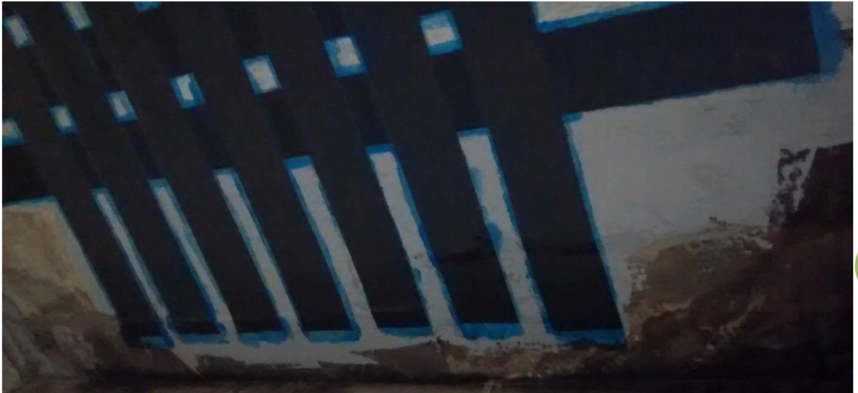
Figura 17: Detalhe dos reforços com fibra de carbono. (Fonte: Dos autores 2016)
