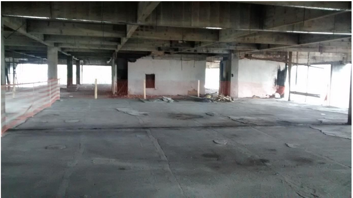
Figura 32: Tela de isolamento instalada na área de execução das obras. (Fonte: Dos autores 2016)
