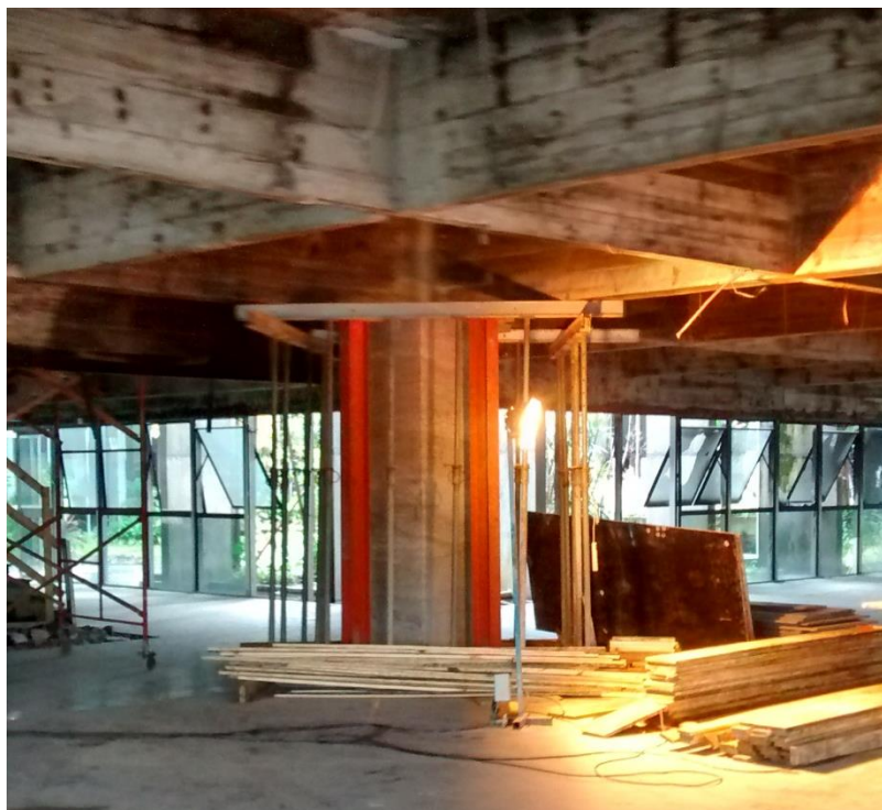
Figura 07: Pilar P6 (pavimento inferior) recomposto. (Fonte: Dos autores 2016)
