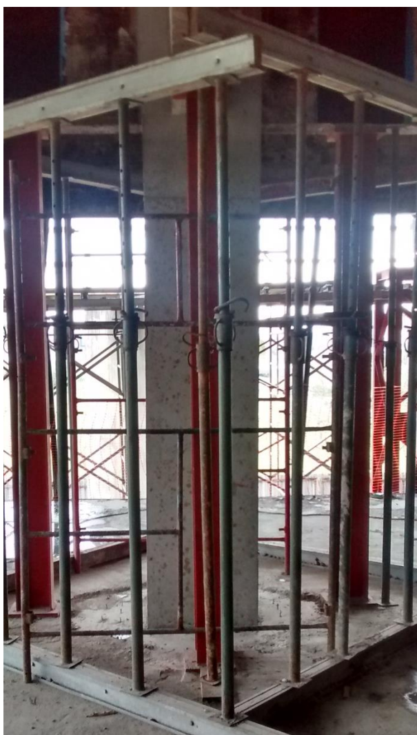
Figura 05: Pilares P1 e P6 (pavimento superior) recompostos. (Fonte: Dos autores 2016)
