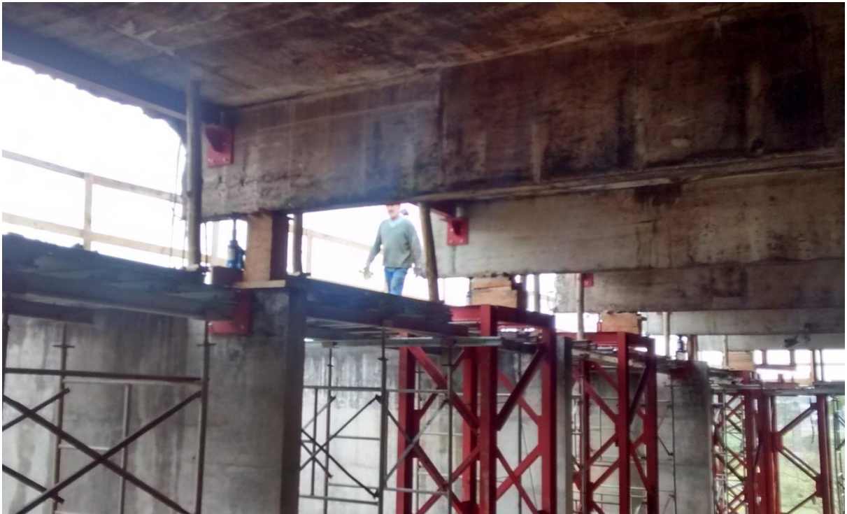
Figura 21: Viga de bordo V11 após demolição. (Fonte: Dos autores 2016)
