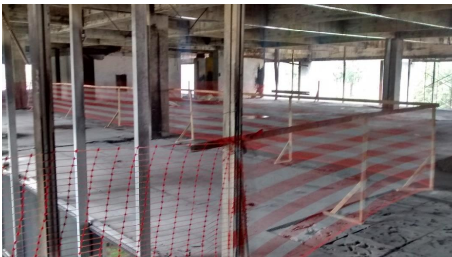
Figura 30: Tela de isolamento instalada na área de execução das obras. (Fonte: Dos autores 2016)
