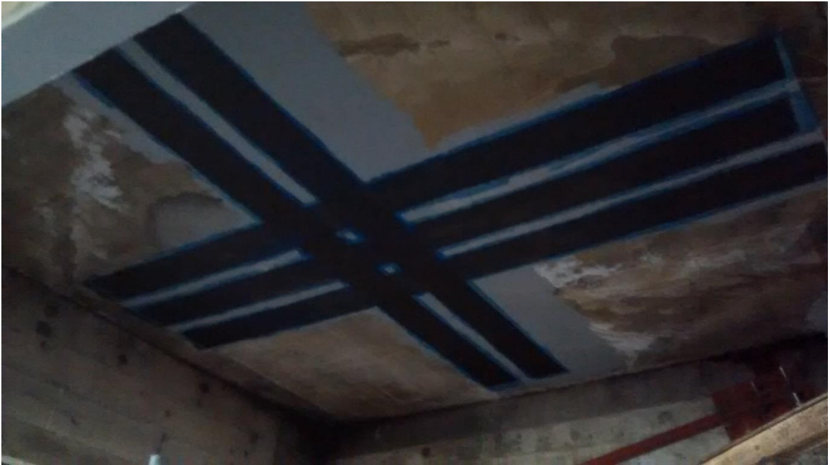
Figura 13: Aplicação dos reforços com fibras de carbono. (Fonte: Dos autores 2016)
