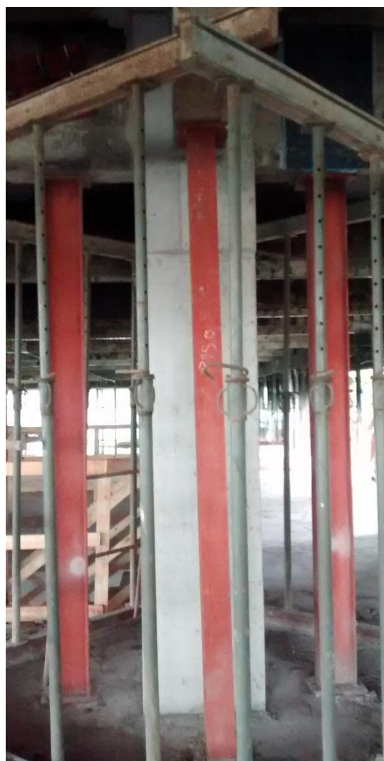
Figura 05: Pilares P1 e P6 (pavimento superior) recompostos. (Fonte: Dos autores 2016)
