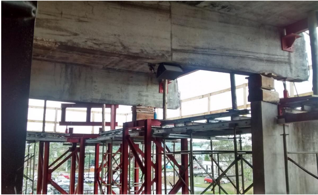
Figura 29: Detalhe do apoio das vigas nas estruturas metálicas e nos macacos hidráulicos (Fonte: Dos autores 2016)
