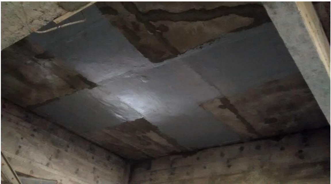
Figura 12: Detalhe de uma das lajes após aplicação do regularizador de superfície. (Fonte: Dos autores 2016)
