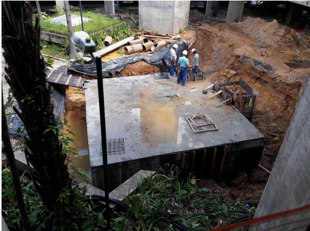
Figura 08: Serviços no reservatório de águas pluviais. (Fonte: Dos autores 2017)
