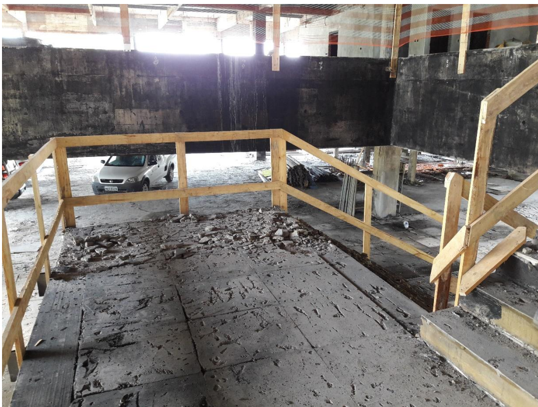
Figura 25: Guarda corpo escadaria. (Fonte: Dos autores 2017)
