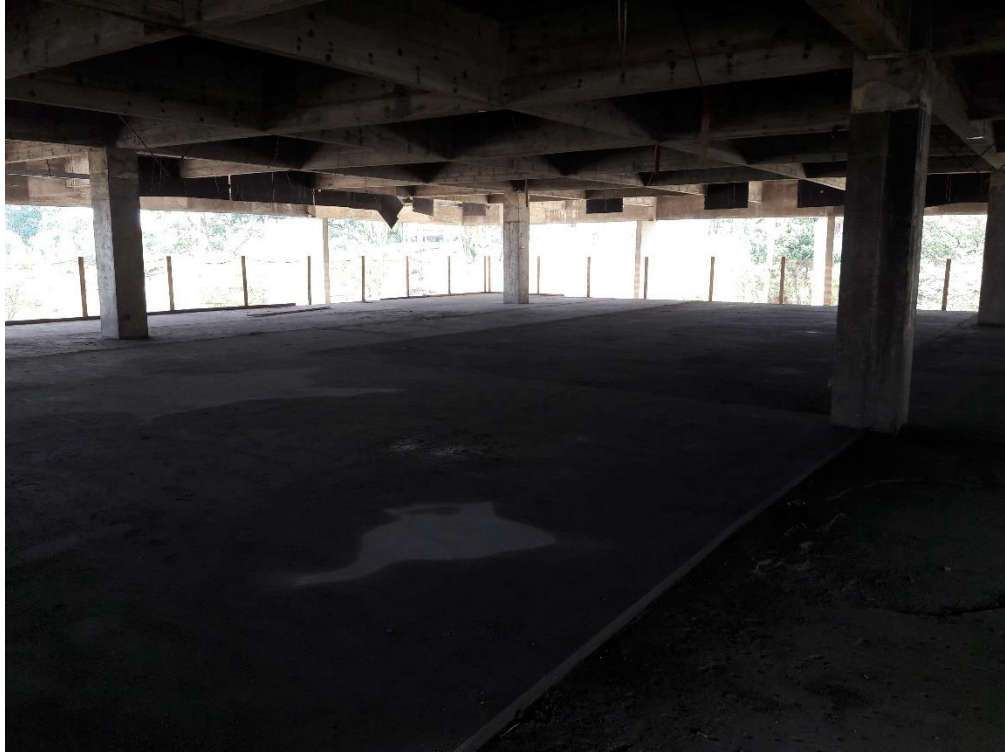
Figura 14: Contrapiso finalizado. (Fonte: Dos autores 2017)
