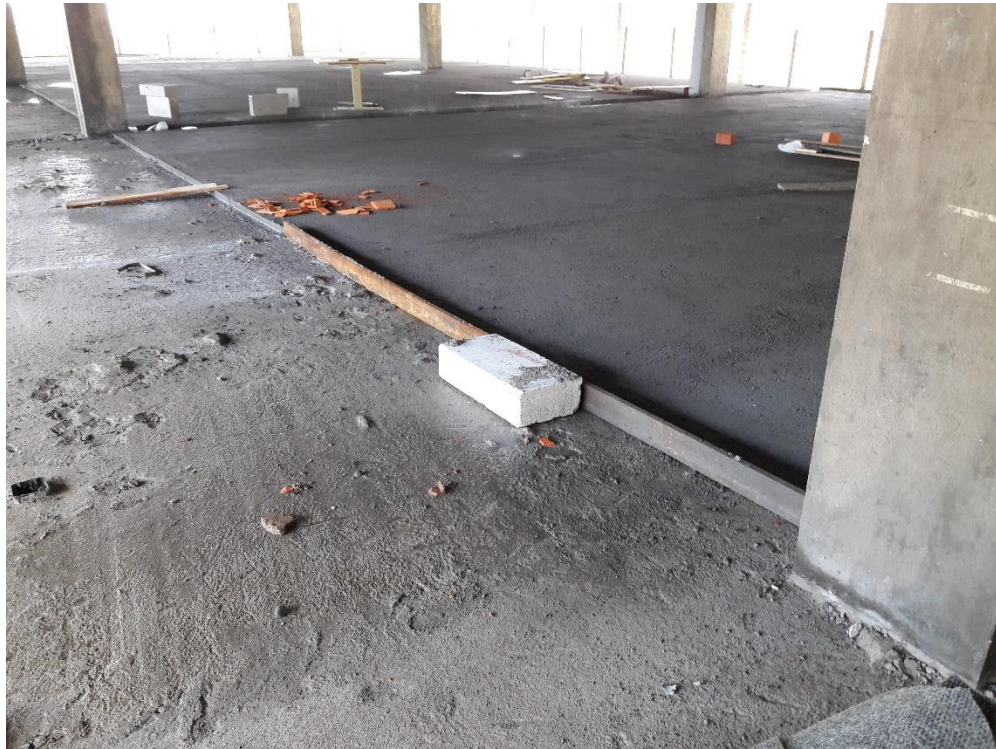
Figura 15: Fôrma do contrapiso. (Fonte: Dos autores 2017)
