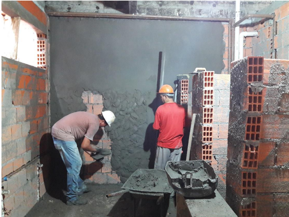
Figura 20: Banheiro sendo rebocado. (Fonte: Dos autores 2017)
