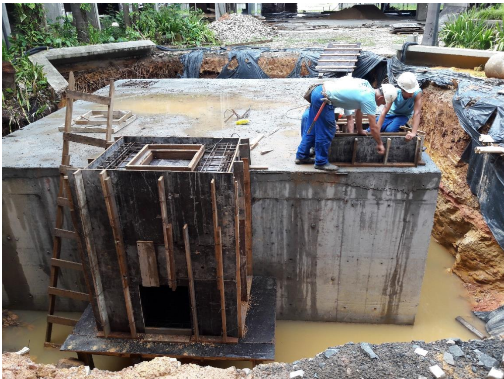
Figura 09: Finalização das fôrmas para concretagem. (Fonte: Dos autores 2017)
