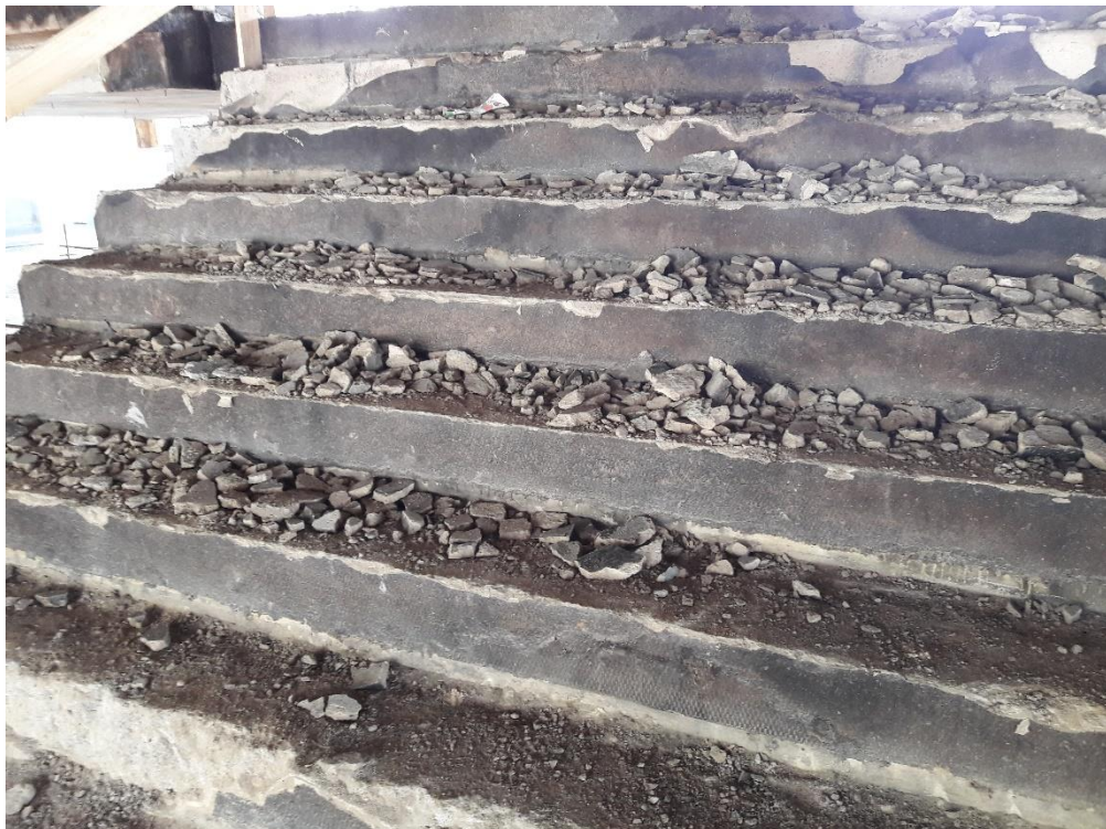
Figura 07: Remoção contrapiso escadaria. (Fonte: Dos autores 2017)
