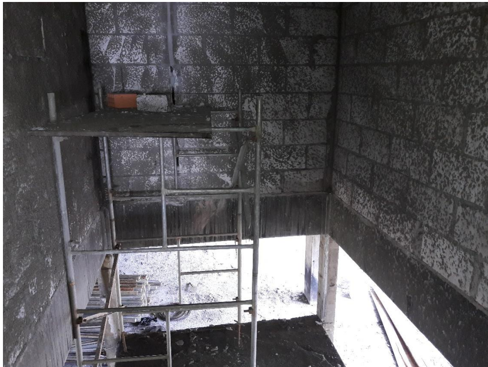
Figura 18: Paredes internas escadaria chapiscada. (Fonte: Dos autores 2017)
