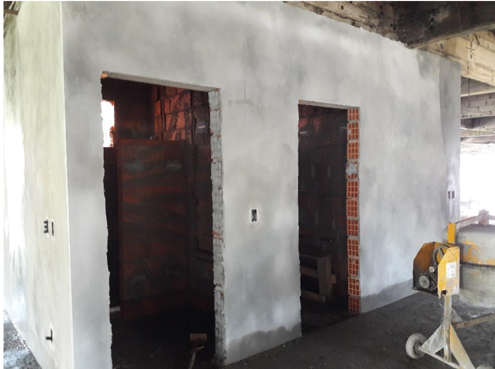
Figura 17: Banheiro chapiscado internamente. (Fonte: Dos autores 2017)
