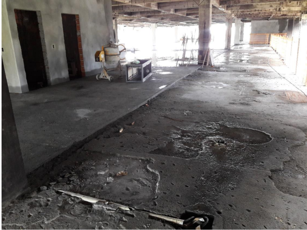
Figura 16: Contrapiso finalizado e alvenaria pronta com reboco. (Fonte: Dos autores 2017)
