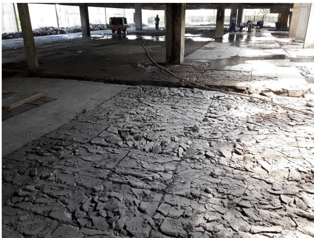
Figura 05: Rompimento do contrapiso sendo realizado. (Fonte: Dos autores 2017)
