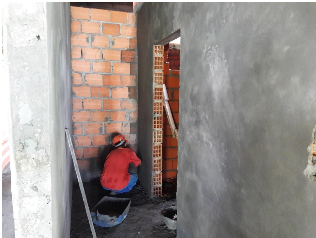
Figura 19: Paredes sendo rebocada. (Fonte: Dos autores 2017)
