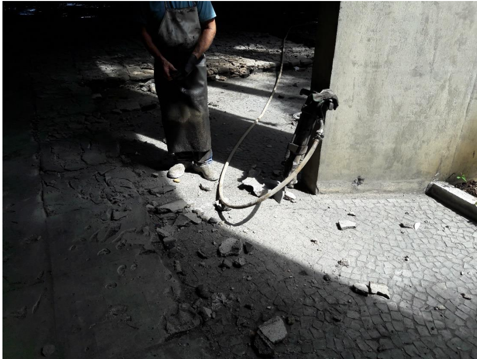
Figura 06: Equipamento para rompimento do contrapiso. (Fonte: Dos autores 2017)
