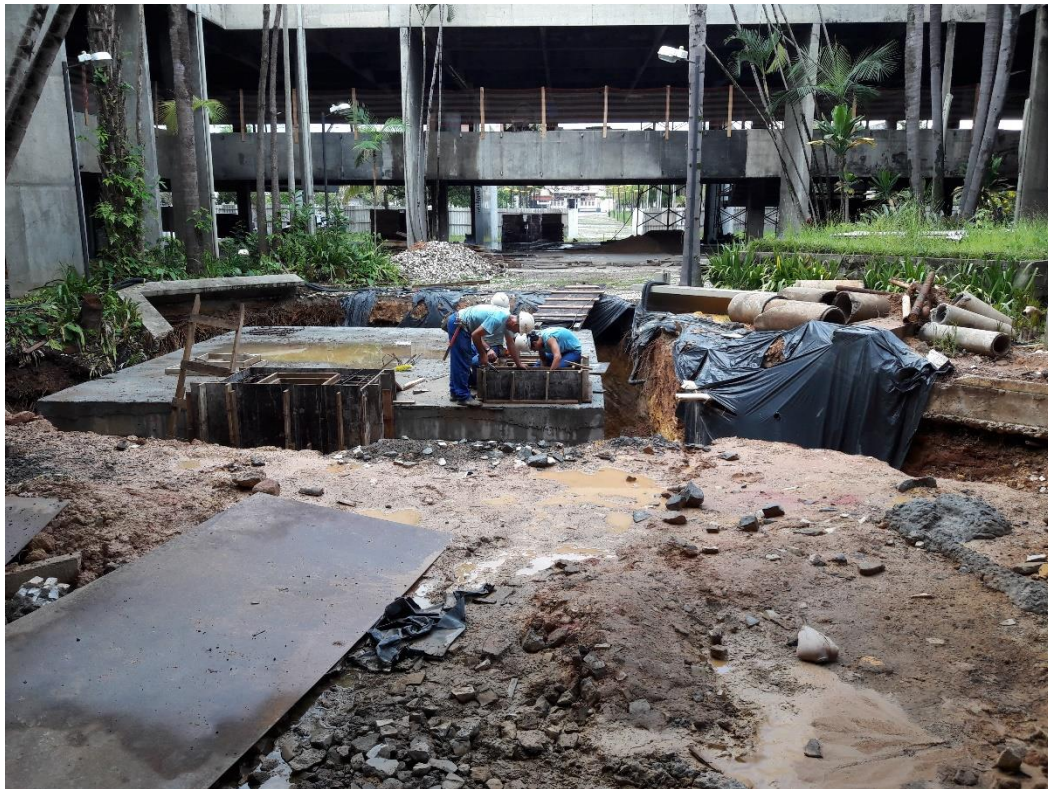
Figura 13: Ambiente ao redor do reservatório. (Fonte: Dos autores 2017)
