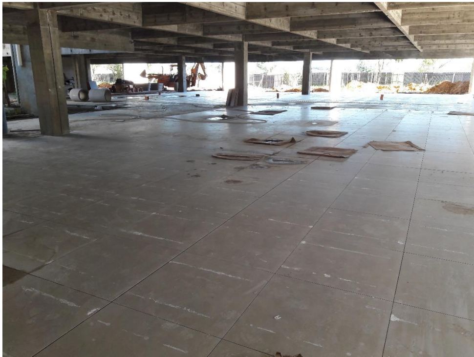
Figura 05: Piso assentado no pavimento inferior. (Fonte: Dos autores 2017)
