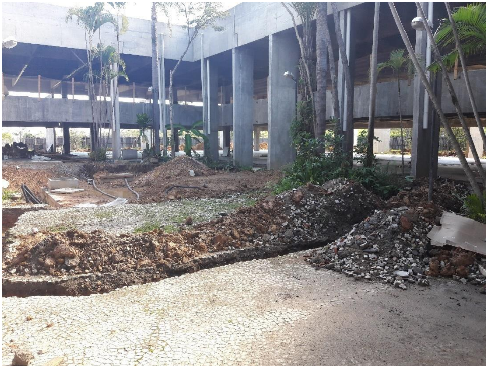
Figura 19: Trabalho finalizado na cisterna. (Fonte: Dos autores 2017)
