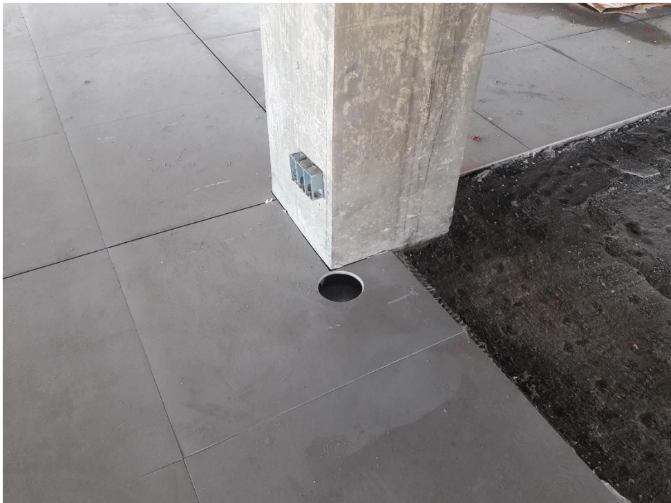
Figura 07: Corte para passagem de tubulação. (Fonte: Dos autores 2017)
