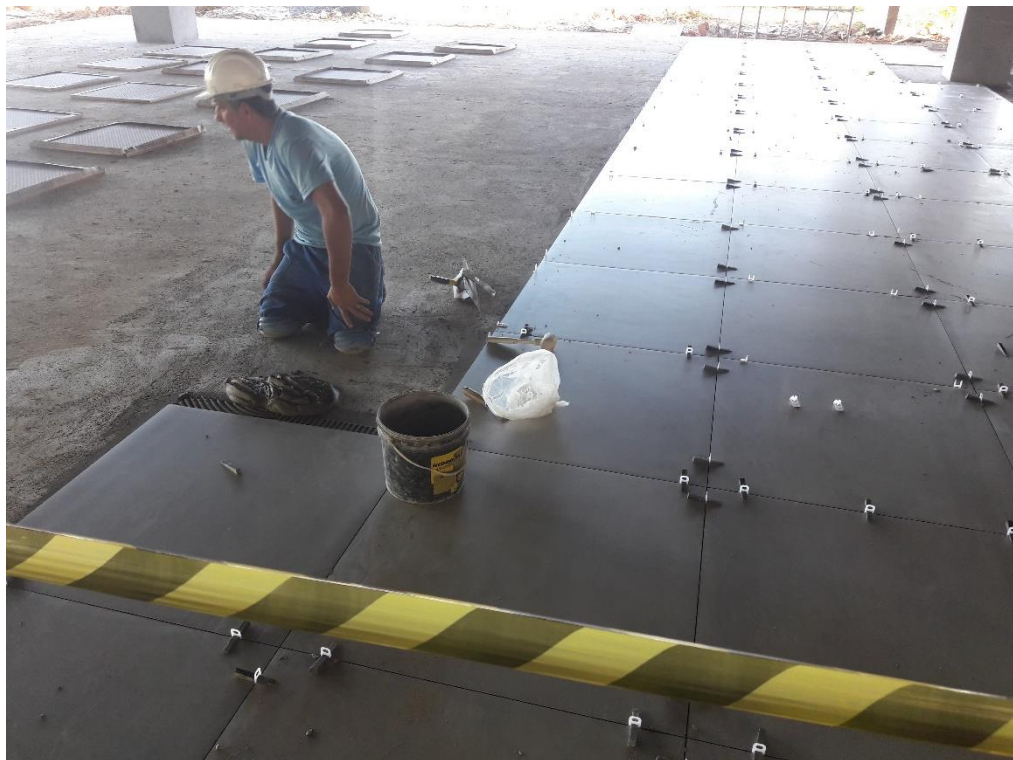
Figura 12: Assentamento e nivelamento piso cerâmico. (Fonte: Dos autores 2017)
