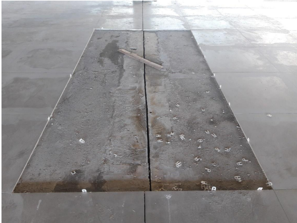
Figura 11: Junta estrutural. (Fonte: Dos autores 2017)
