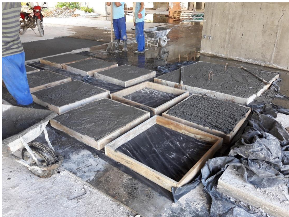
Figura 18: Concretagem das tampas. (Fonte: Dos autores 2017)
