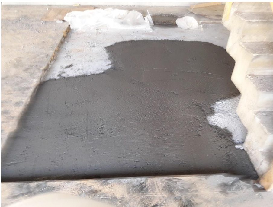
Figura 16: Regularização com argamassa. (Fonte: Dos autores 2017)
