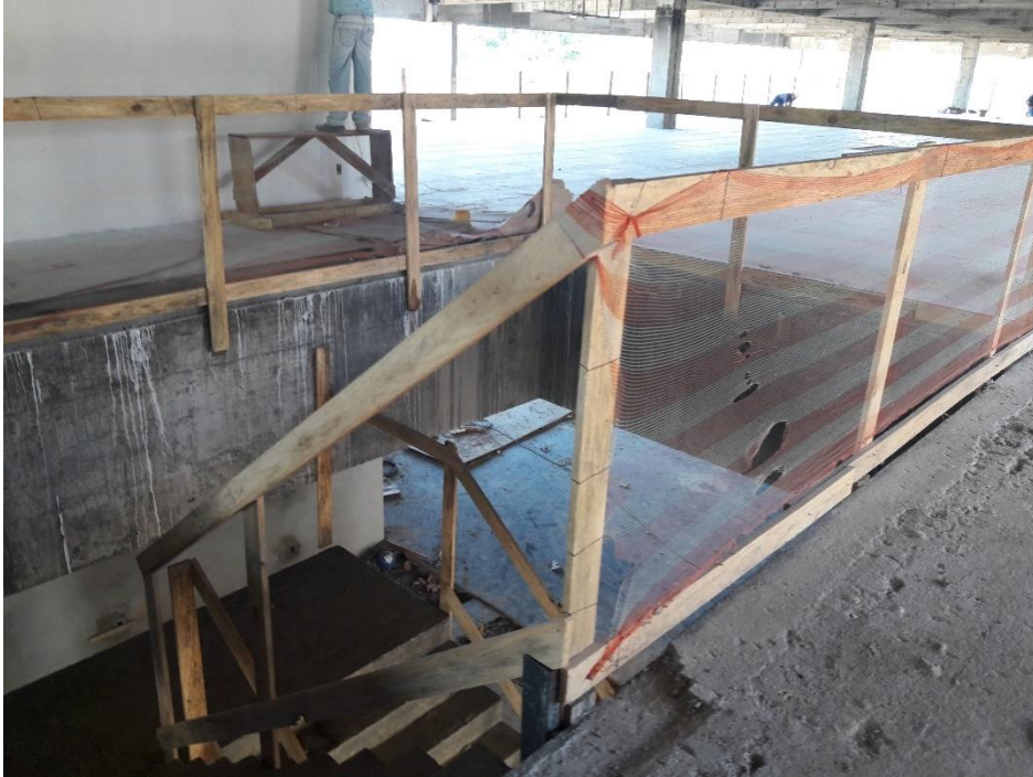
Figura 29: Guarda corpo segundo pavimento. (Fonte: Dos autores 2017)
