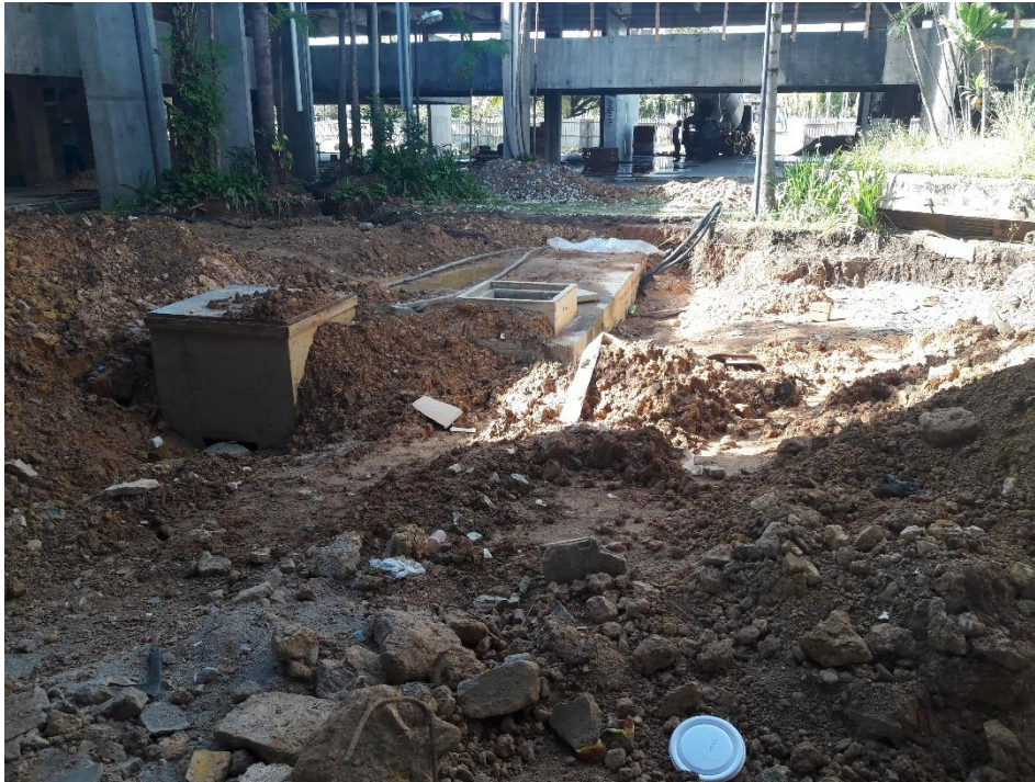
Figura 20: Trabalho finalizado na cisterna. (Fonte: Dos autores 2017)
