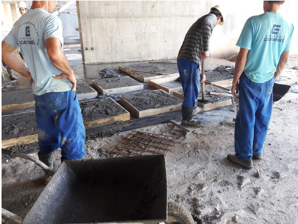
Figura 17: Concretagem das tampas. (Fonte: Dos autores 2017)
