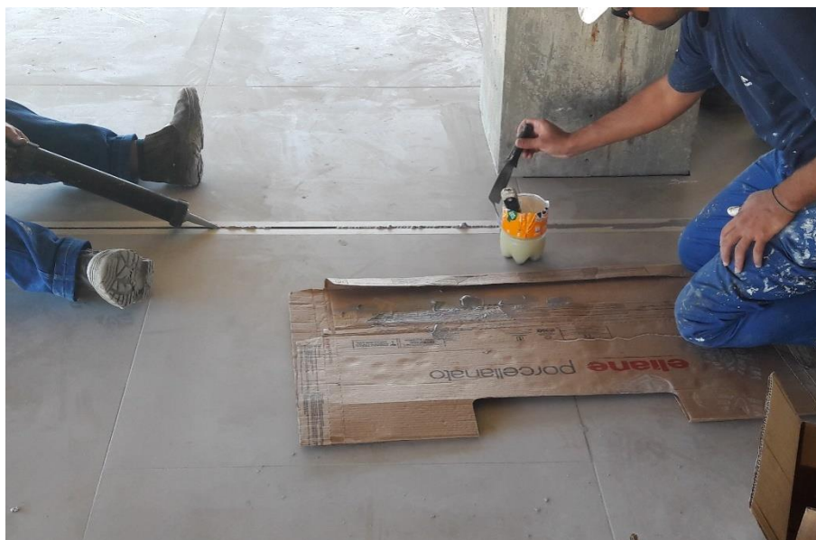
Figura 08: Aplicação do selante. (Fonte: Dos autores 2017)
