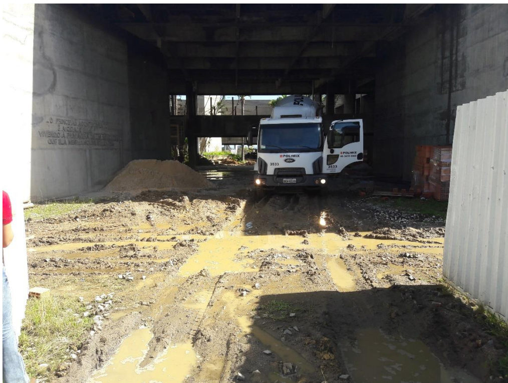
Figura 26: Entrada canteiro de obra. (Fonte: Dos autores 2017)
