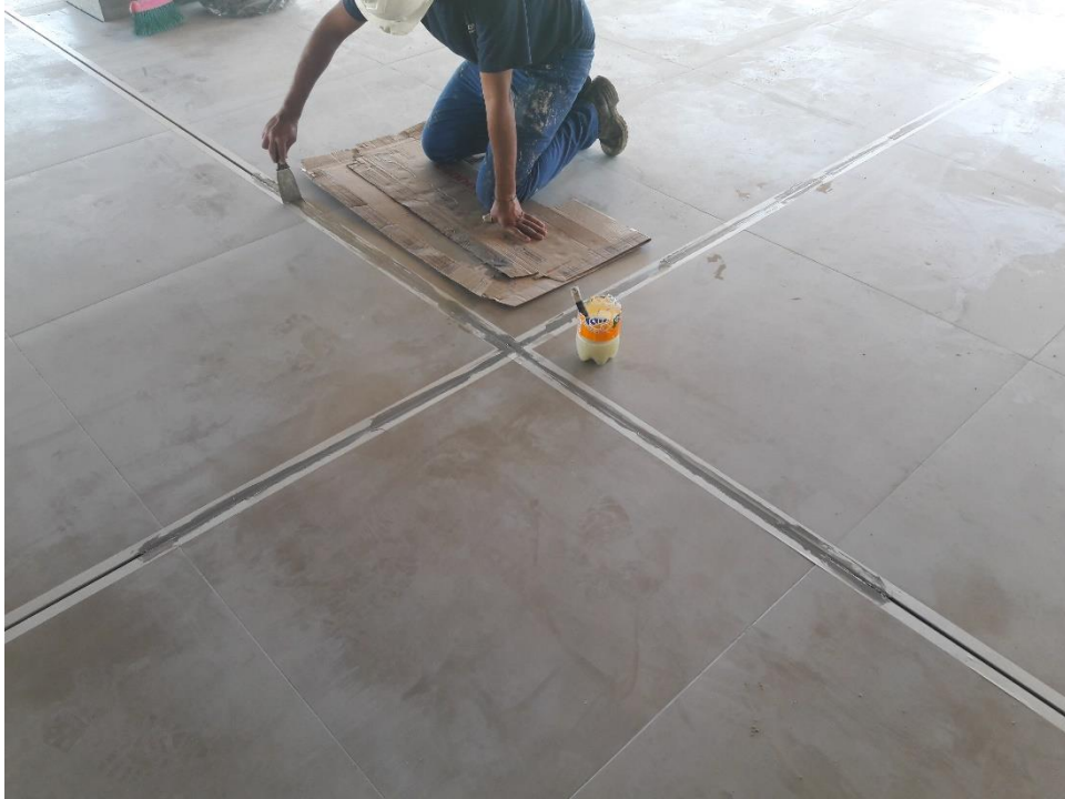
Figura 09: Aplicação selante. (Fonte: Dos autores 2017)
