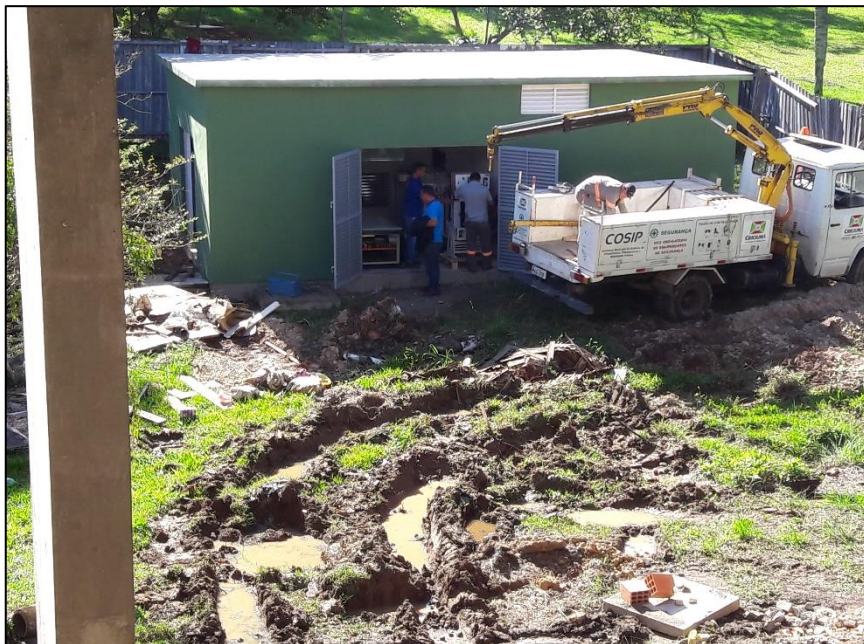
Figura 25: Instalação dos equipamentos na subestação. (Fonte: Dos autores 2017)
