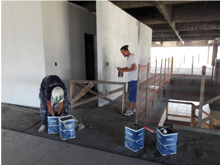
Figura 13: Aplicação da massa fina. (Fonte: Dos autores 2017)
