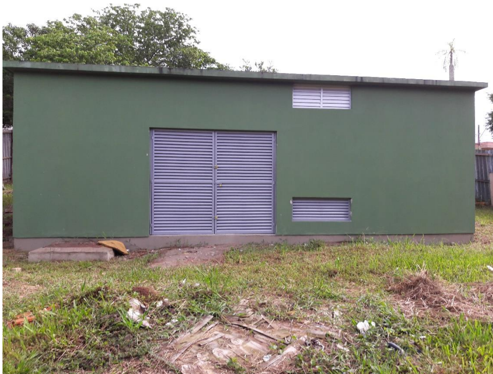
Figura 23: Novas aberturas instaladas. (Fonte: Dos autores 2017)
