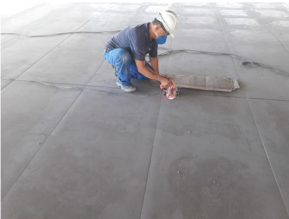
Figura 11 0: Corte das juntas de movimentação. (Fonte: Dos autores 2017)
