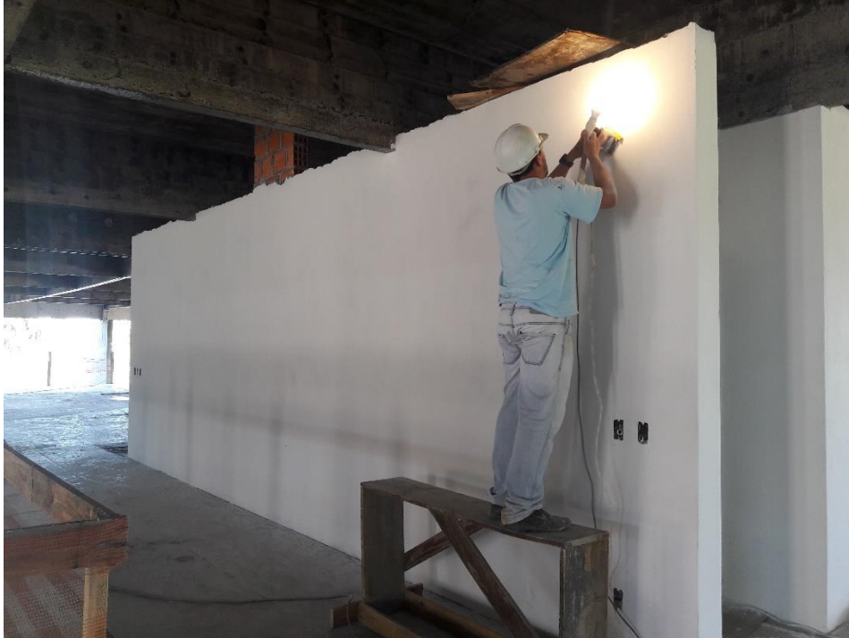
Figura 14: Trabalho realizado na parede com massa fina. (Fonte: Dos autores 2017)
