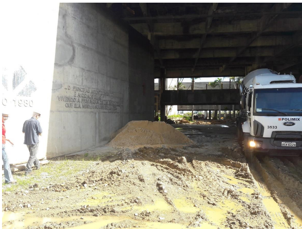
Figura 04: Entrada frontal do Paço Municipal Marcos Rovaris. (Fonte: Dos autores 2017)
