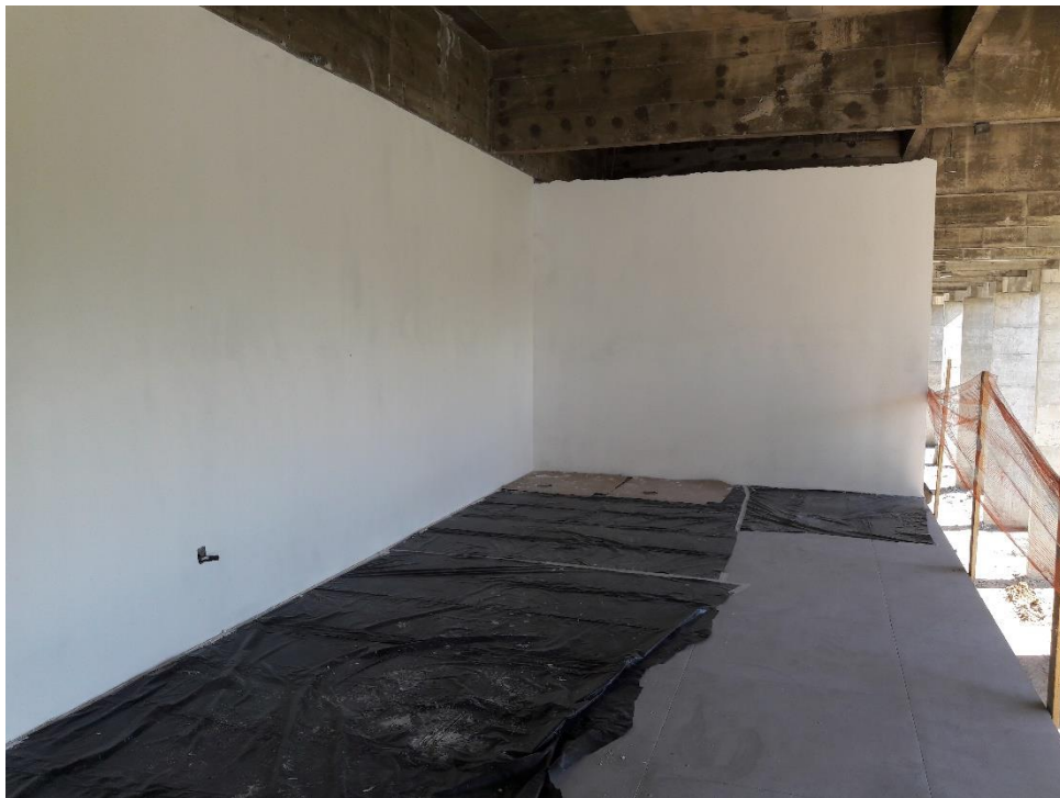
Figura 15: Parede finalizada área externa ao sanitário. (Fonte: Dos autores 2017)
