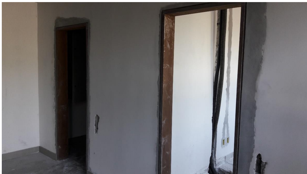
Figura 27: Instalação do marco nas aberturas (Fonte: Autores)
