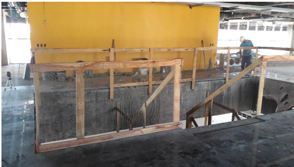
Figura 21: Guarda-corpo e rede de proteção instaladas na escadaria (Fonte: Autores)
