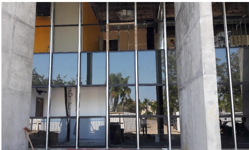
Figura 9: Esquadrias e vidros instalados (Fonte: Autores)
