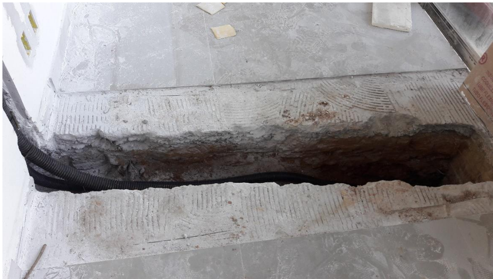
Figura 13: Detalhe corte para passagem da rede (Fonte: Autores)
