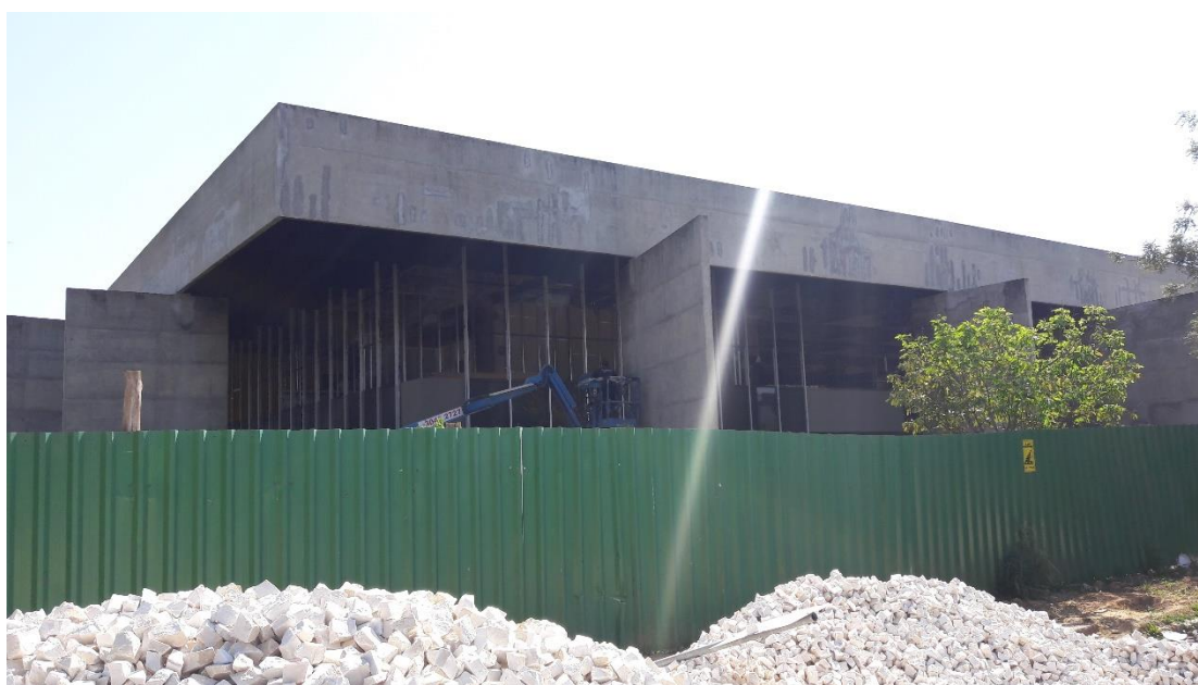
Figura 2: Vista externa do Paço Municipal (Fonte: Autores)
