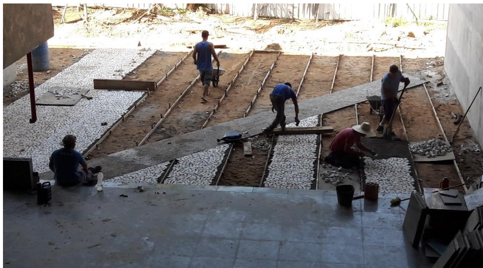
Figura 4: Assentamento pedra portuguesa (Fonte: Autores)
