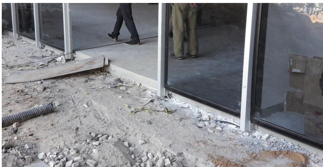
Figura 10: Detalhe na instalação da esquadria e vidro (Fonte: Autores)
