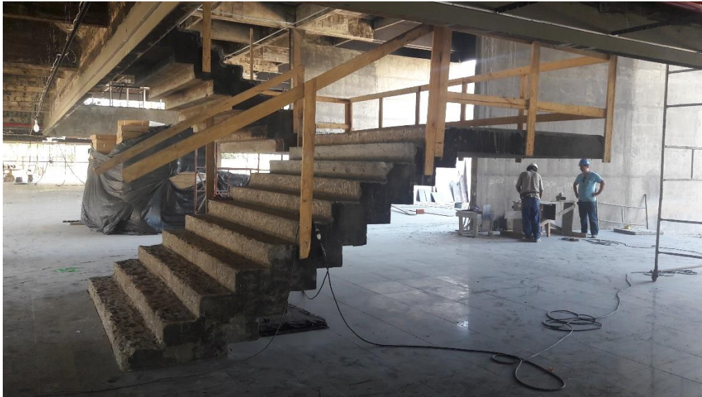
Figura 20: Escadaria com guarda-corpo (Fonte: Autores)
