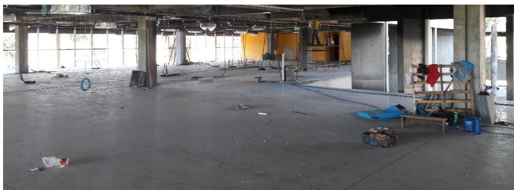
Figura 8: Piso assentado no segundo pavimento (Fonte: Autores)
