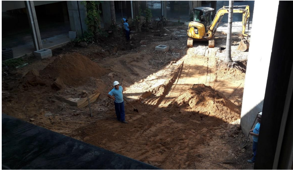
Figura 30: Trabalhos no canteiro central (Fonte: Autores)
