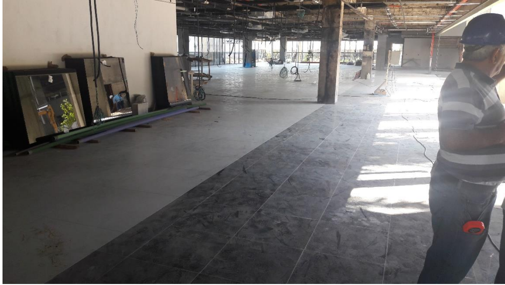
Figura 5: Piso cerâmico à esquerda e granito à direita (Fonte: Autores)
