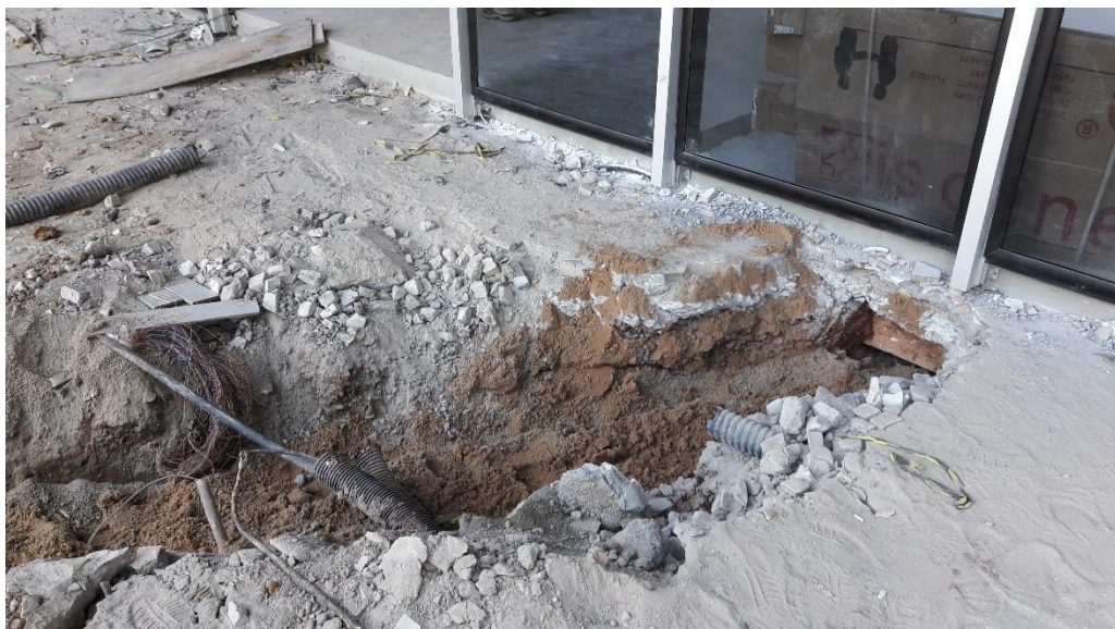
Figura 14: Detalhe corte para passagem da rede (Fonte: Autores)
