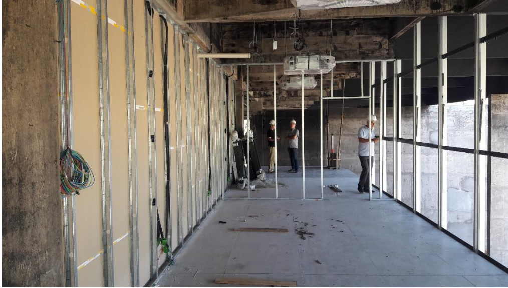
Figura 11: Instalação das divisórias (Fonte: Autores)
