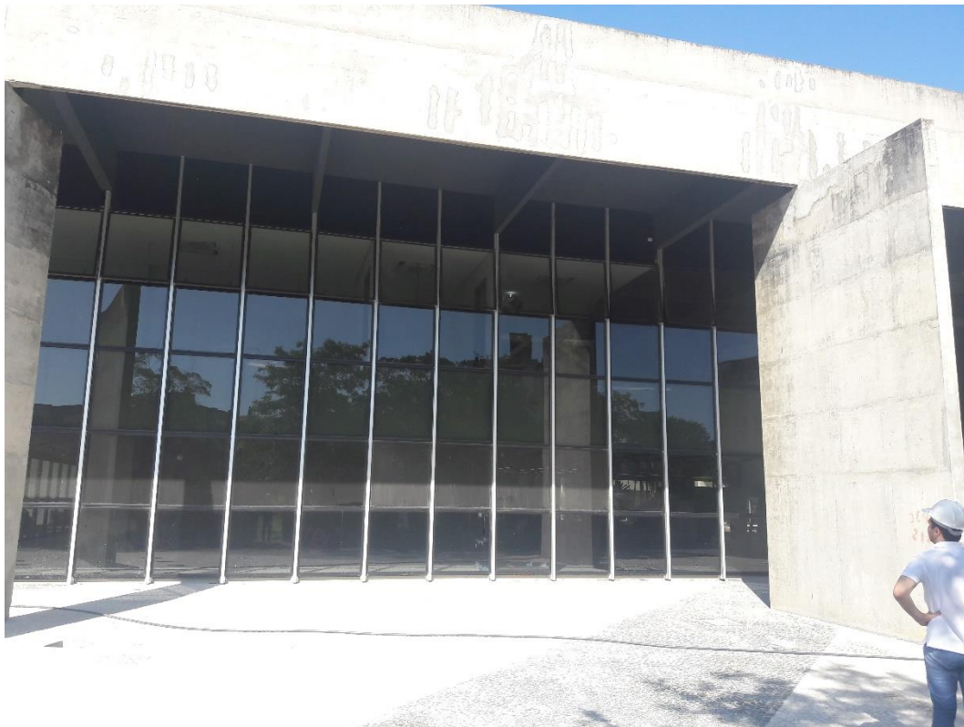
Figura 11: Esquadrias e vidros instalados (Fonte: Autores)
