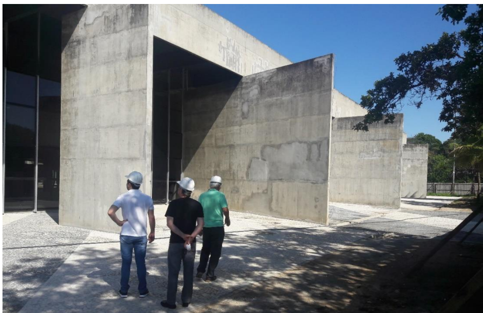
Figura 2: Vista externa do Paço Municipal (Fonte: Autores)
