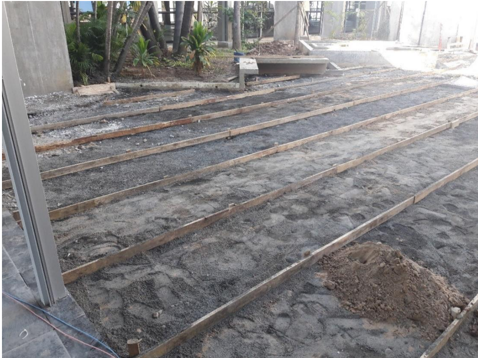
Figura 5: Serviço para assentamento no canteiro central (Fonte: Autores)
