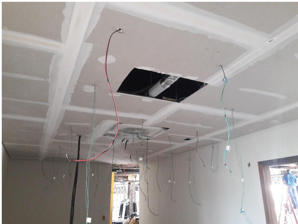
Figura 15: Forro instalado, faltando acabamento (Fonte: Autores)
