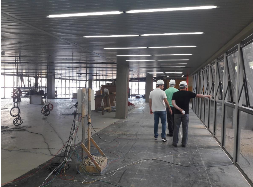
Figura 16: Forro e luminárias instaladas no térreo (Fonte: Autores)
