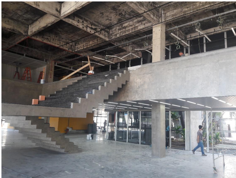
Figura 9: Visão geral apresentando cerâmicas assentadas (Fonte: Autores)
