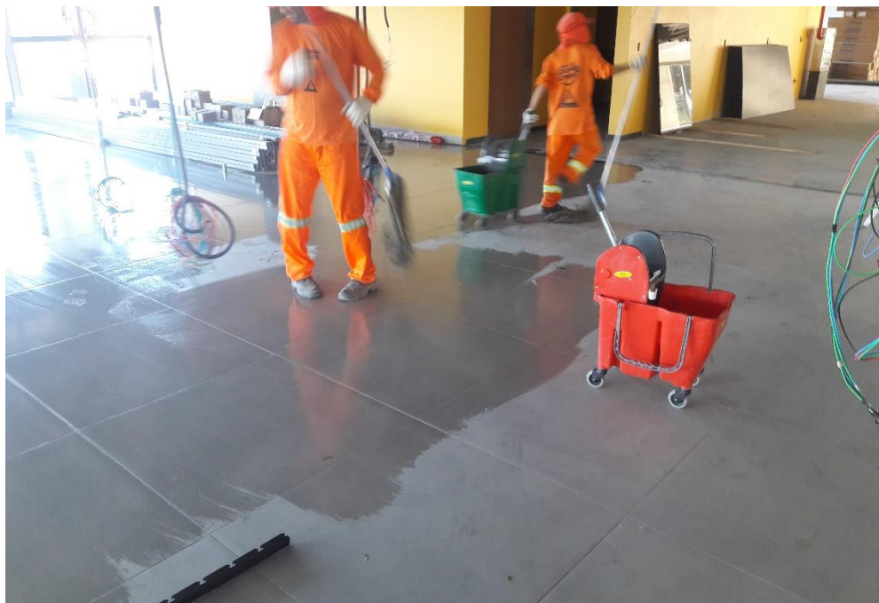
Figura 7: Limpeza do piso cerâmico (Fonte: Autores)
