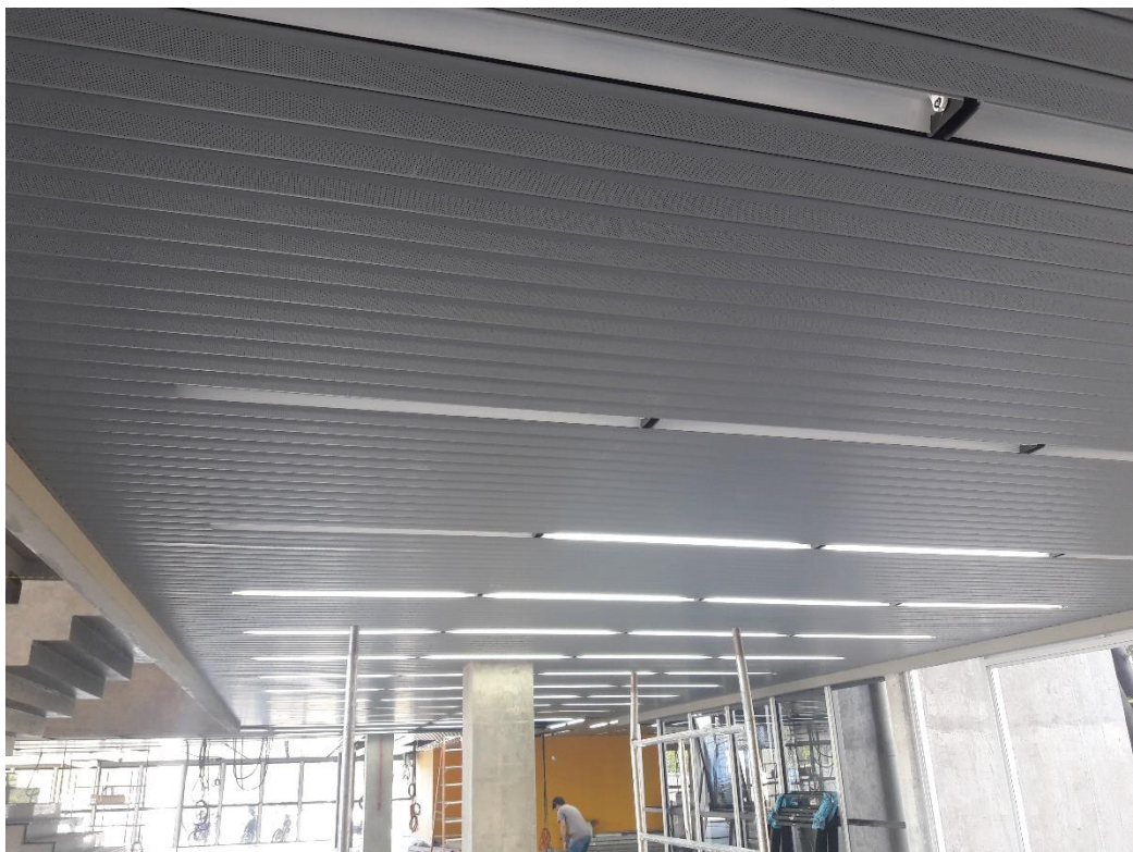
Figura 17: Detalhe forro (Fonte: Autores)
