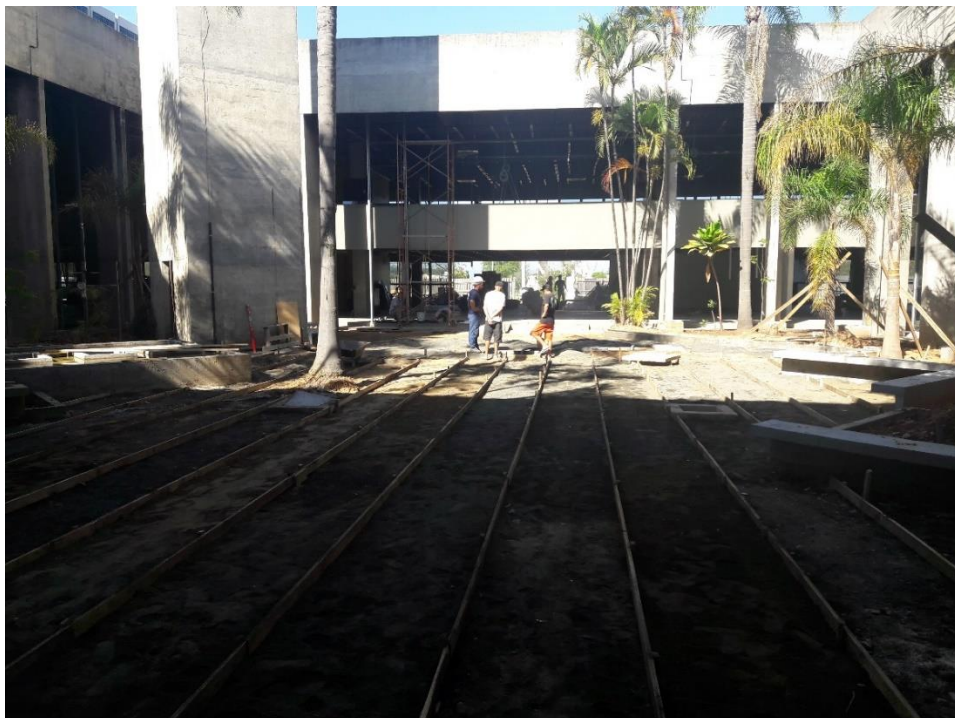
Figura 6: Serviço para assentamento no canteiro central (Fonte: Autores)
