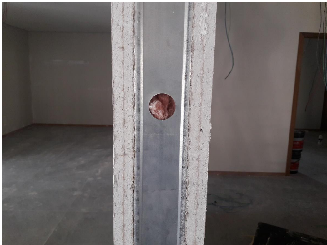
Figura 13: Detalhe da divisória (Fonte: Autores)
