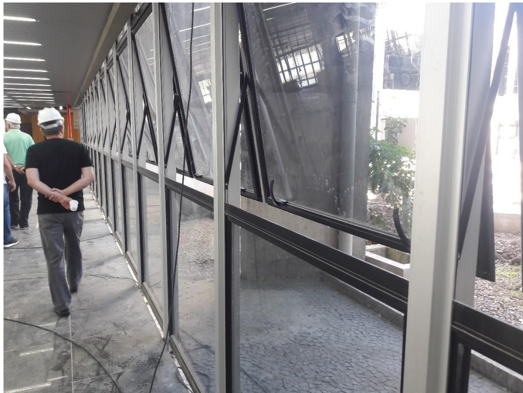
Figura 12: Detalhe na instalação da esquadria e vidro (Fonte: Autores)
