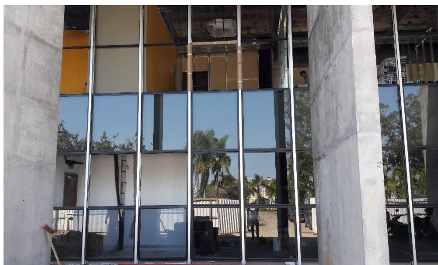
Figura 16: Esquadrias e vidros instalados (Fonte: Autores)
