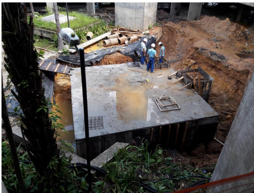
Figura 12: Serviços no reservatório de águas pluviais. (Fonte: Dos autores 2017)
