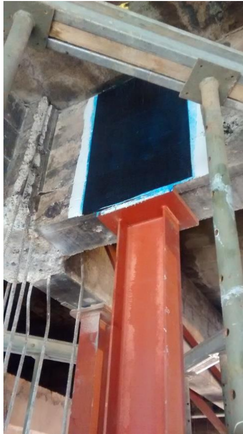
Figura 5: Reforço com fibra de carbono. (Fonte: Dos Autores 2016)
