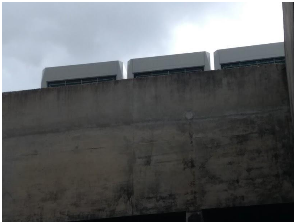
Figura 22: Sistema de refrigeração central (Fonte: Autores).
