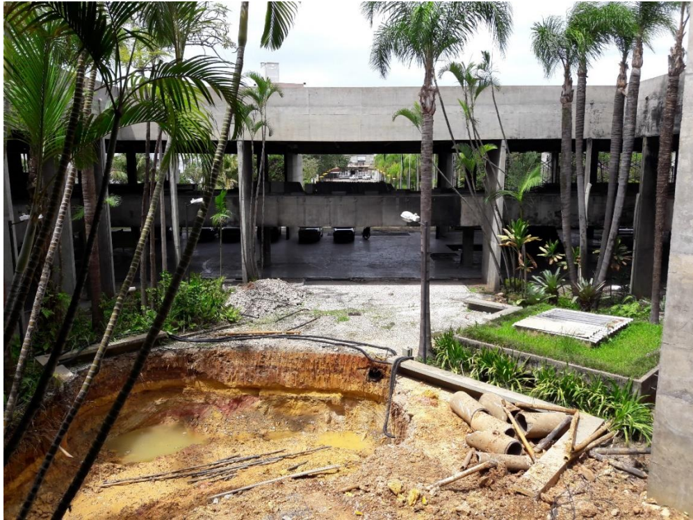
Figura 9: Escavação para construção do reservatório de água pluvial. (Fonte: Dos autores 2017)
