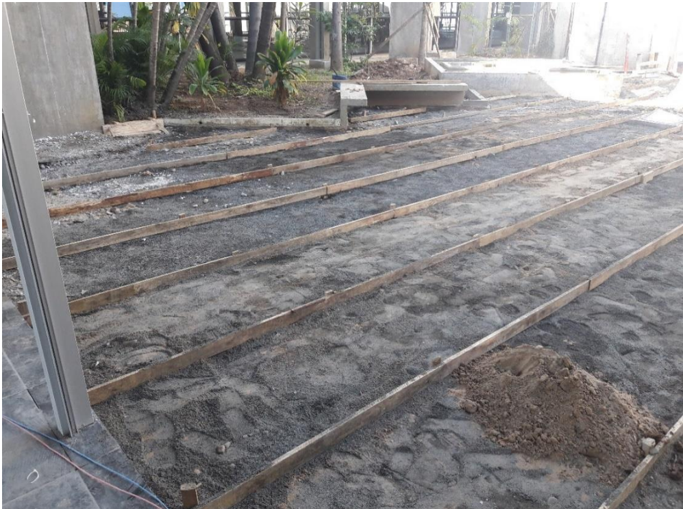
Figura 18: Serviço para assentamento no canteiro central (Fonte: Autores)
