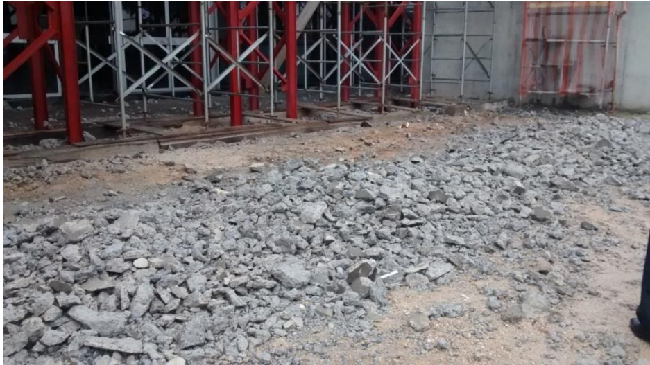
Figura 6: Resíduos resultantes da demolição das vigas de bordo. (Fonte: Dos autores 2016)
