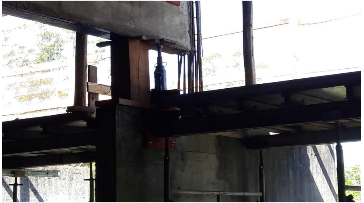
Figura 8: Detalhe da estrutura macaqueada. (Fonte: Dos autores 2016)
