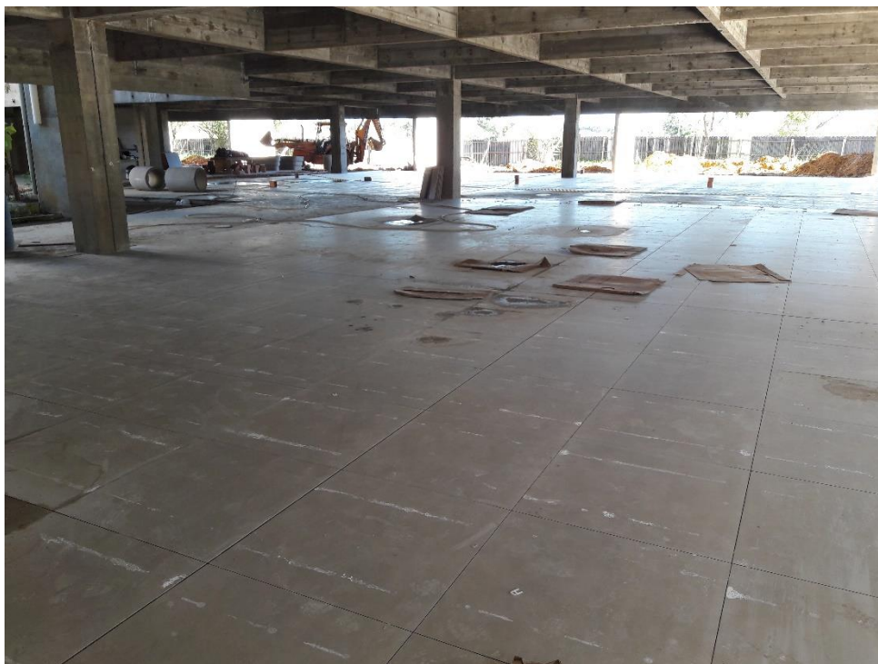
Figura 13: Piso assentado no pavimento inferior. (Fonte: Dos autores 2017)
