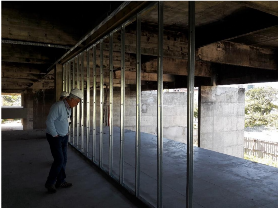
Figura 14: Perfis instalados para divisórias. (Fonte: Dos autores 2017)
