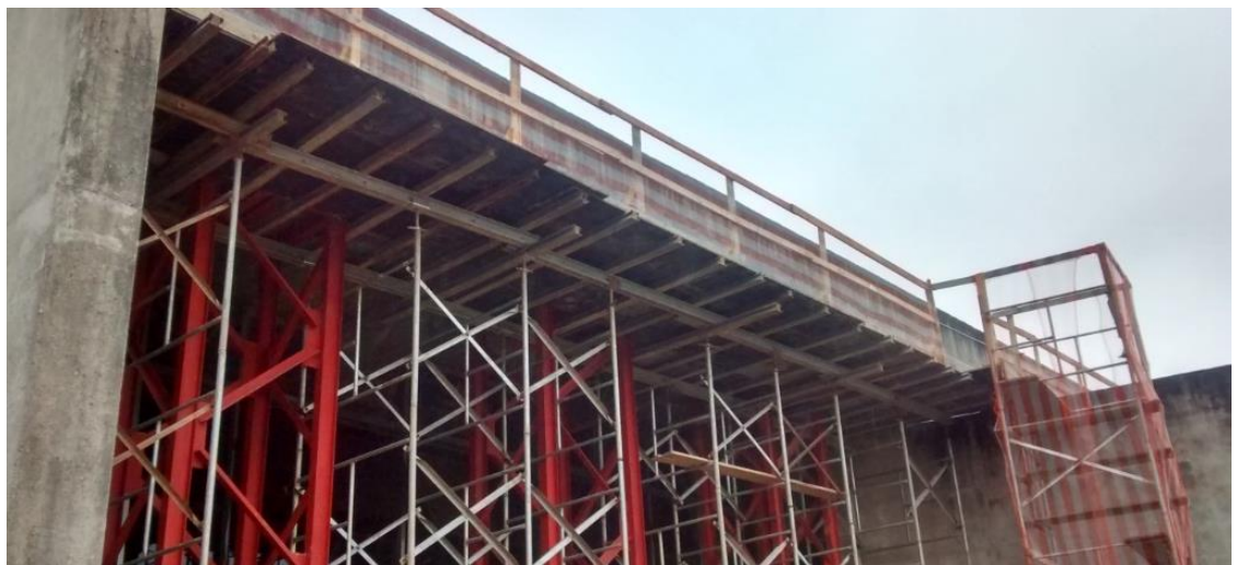
Figura 4: Estruturas metálicas de apoio. (Fonte: Dos autores 2016)
