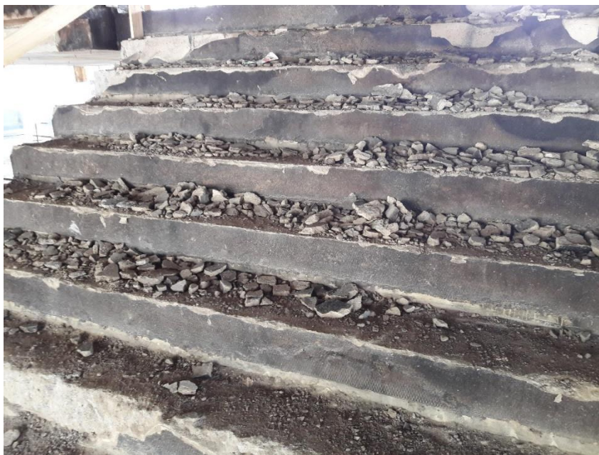
Figura 11: Remoção contrapiso escadaria. (Fonte: Dos autores 2017)
