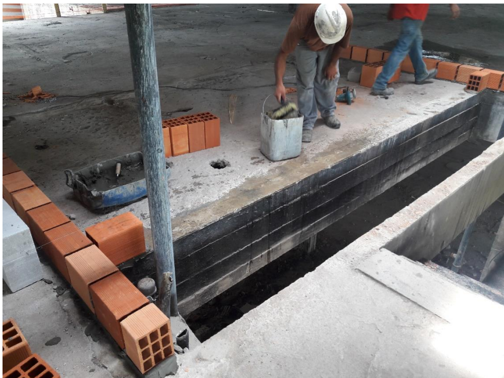
Figura 10: Levantamento da alvenaria do sanitário e escadaria. (Fonte: Dos autores 2017)
