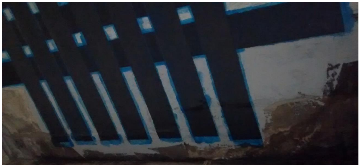
Figura 7: Detalhe dos reforços com fibra de carbono. (Fonte: Dos autores 2016)
