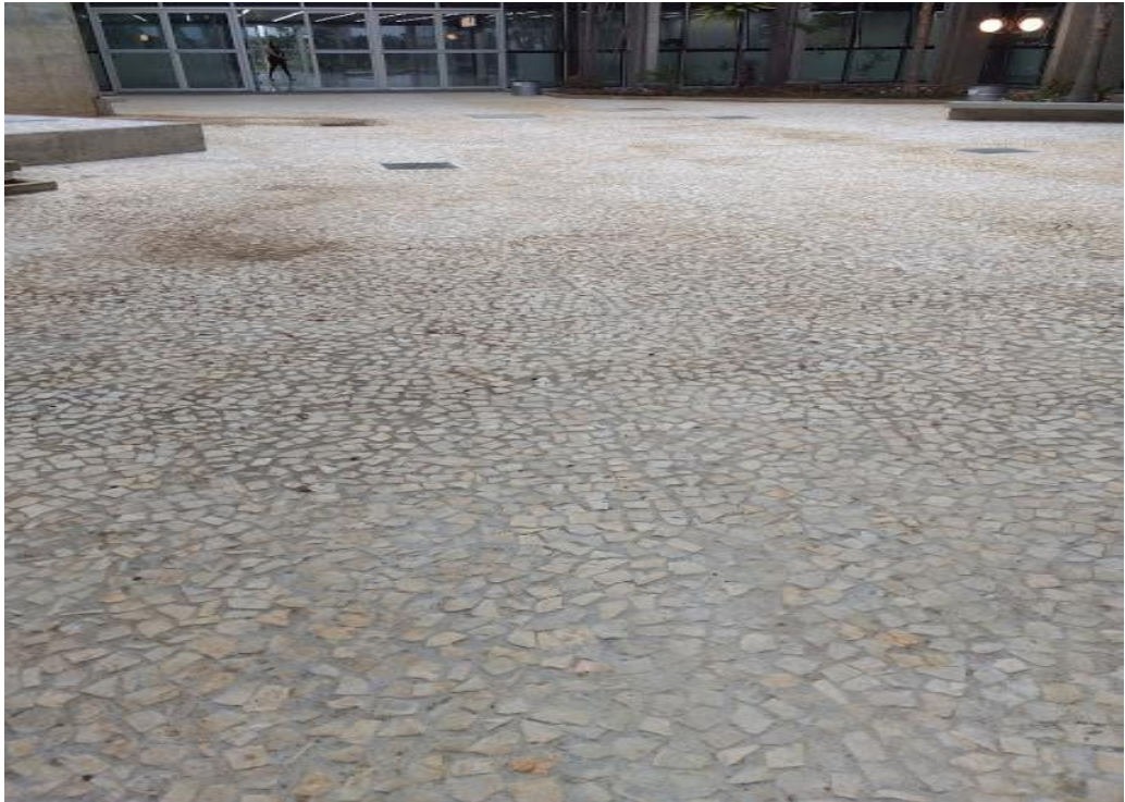
Figura 20: Acabamento final do canteiro central (Fonte: Autores).
