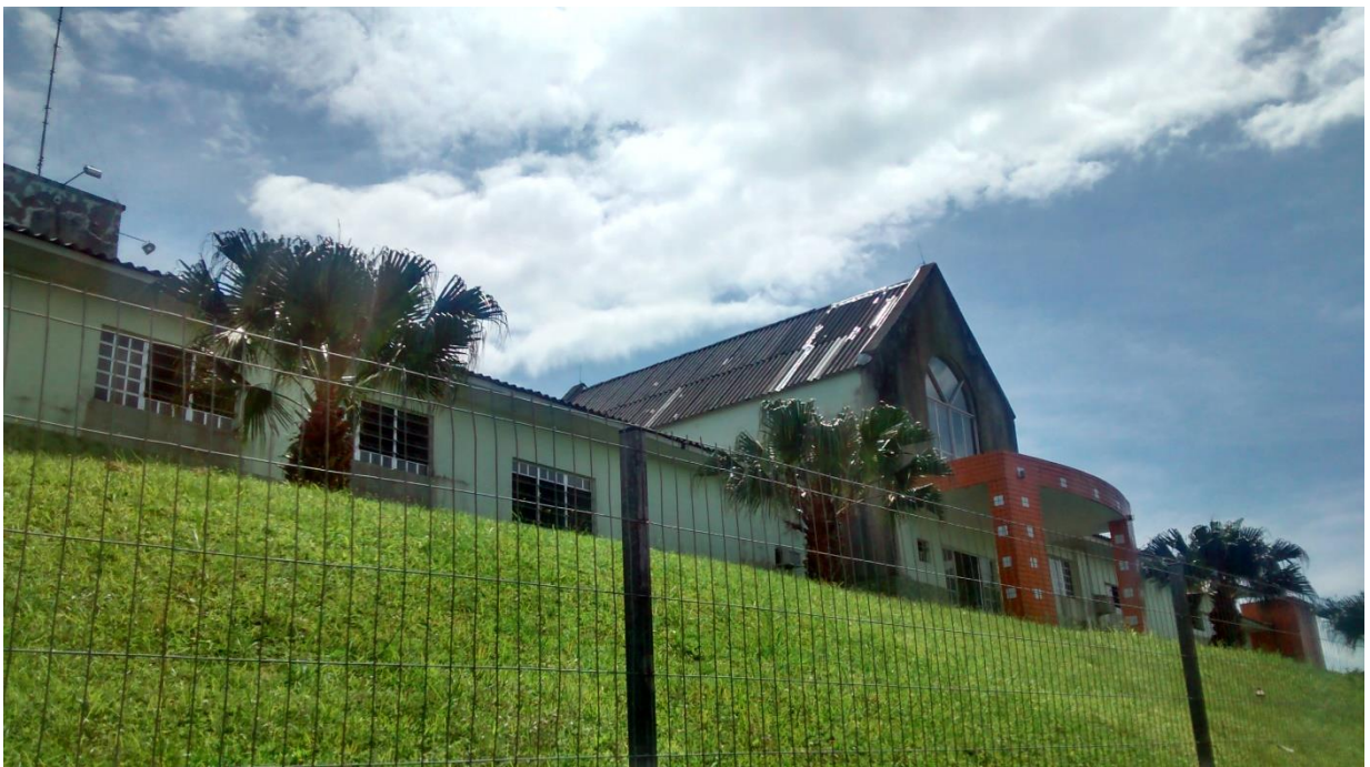
Figura 19: Aspecto da situação externa do prédio. (Fonte: Dos Autores 2015).
