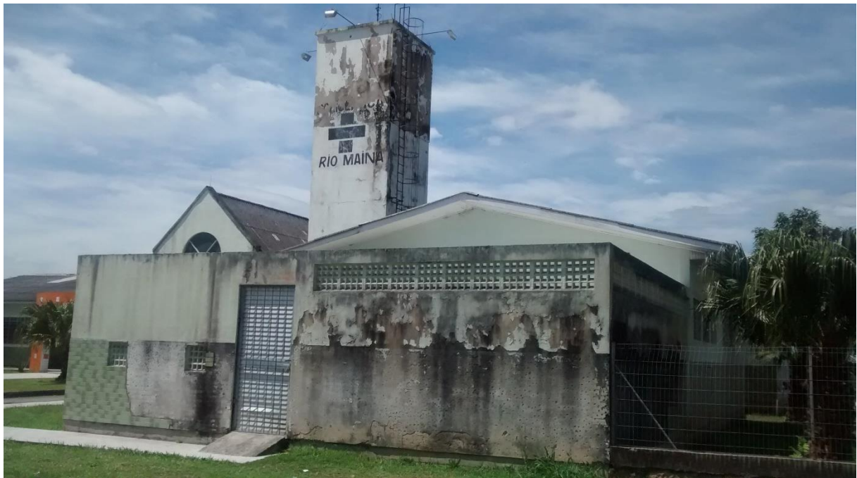
Figura 21: Aspecto da situação externa do prédio. (Fonte: Dos Autores 2015)
