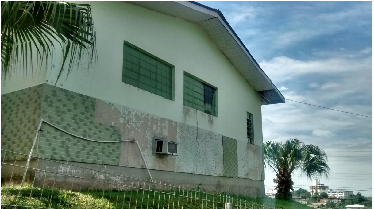
Figura 18: Beiral quebrado, revestimento cerâmico caindo e parede com infiltração. (Fonte: Dos Autores 2015)
