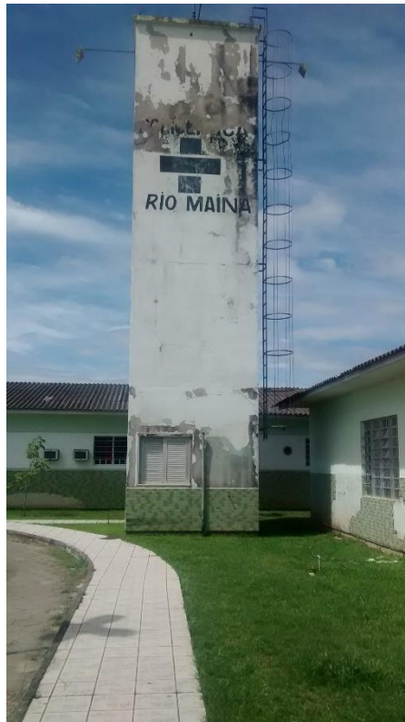
Figura 20: Aspecto da pintura externa do reservatório. (Fonte: Dos Autores 2015).
