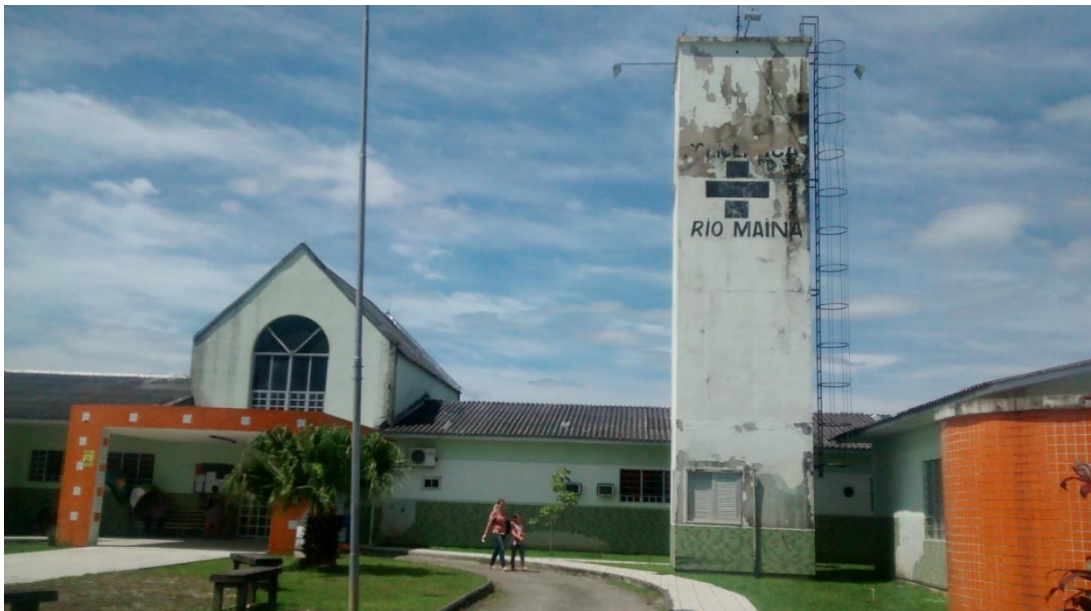
Figura 06: Policlínica do Rio Maina vista frontal. (Fonte: Dos Autores 2015)
