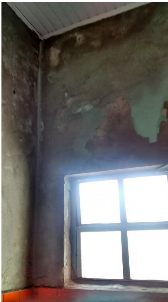
Figura 12: Parede apresentando problemas de infiltração. (Fonte: Dos Autores 2015)
