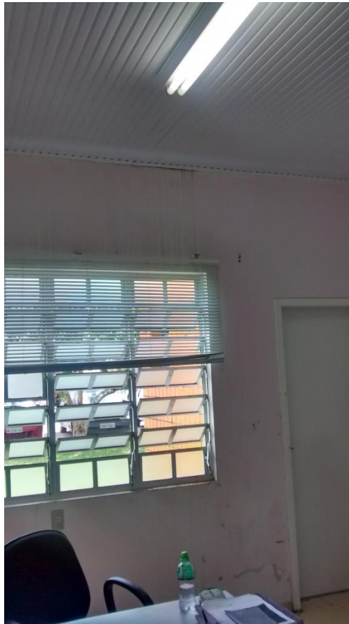
Figura 15: Problema de infiltração e descascamento de tinta em um dos consultórios. (Fonte: Dos Autores 2015)
