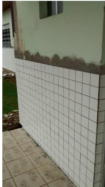
Figura 11: Revestimento cerâmico substituído. (Fonte: Dos Autores 2016)
