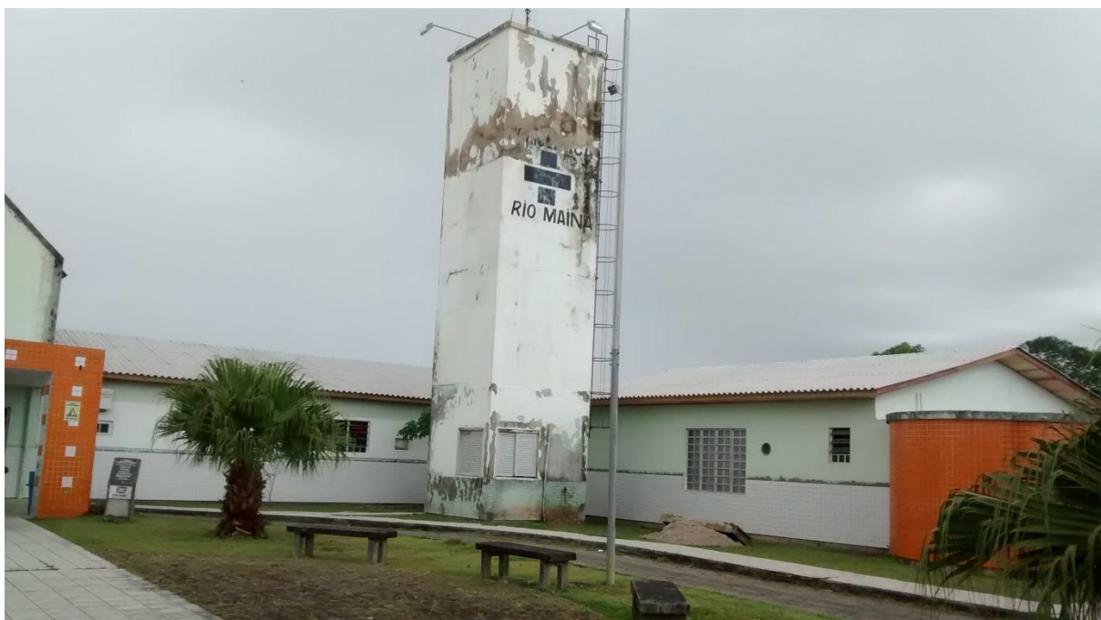
Figura 06: Policlínica do Rio Maina vista frontal. (Fonte: Dos Autores 2016)
