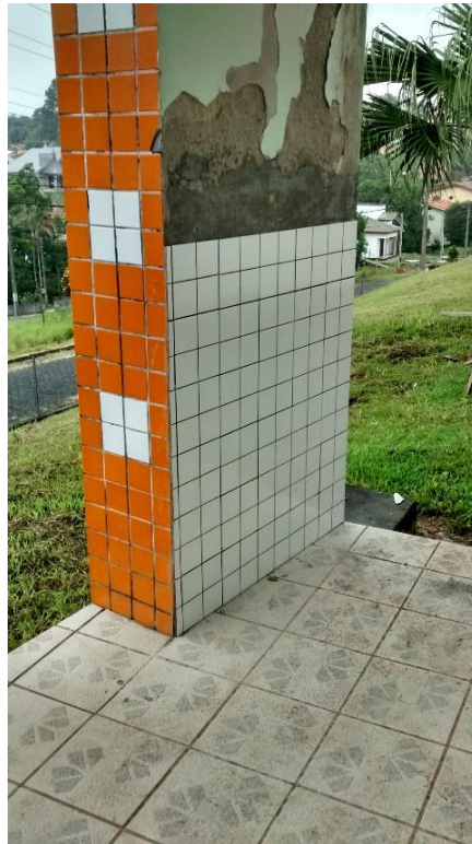
Figura 14: Revestimento cerâmico substituído nos pilares. (Fonte: Dos Autores 2016)
