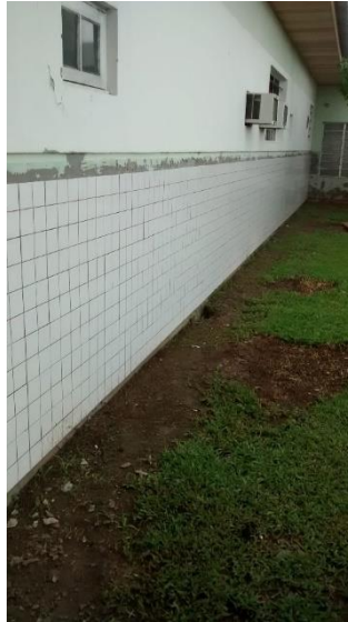
Figura 10: Revestimento cerâmico substituído. (Fonte: Dos Autores 2016)
