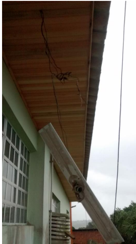
Figura 09: Beiral em madeira instalado. (Fonte: Dos Autores 2016)
