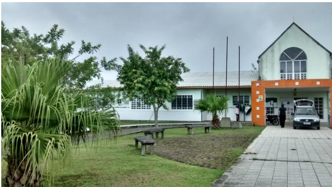
Figura 07: Telhado da policlínica substituído. (Fonte: Dos Autores 2016)
