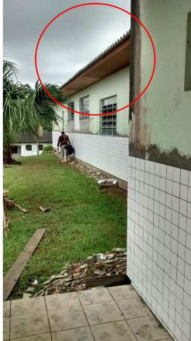
Figura 08: Beiral em madeira instalado. (Fonte: Dos Autores 2016)
