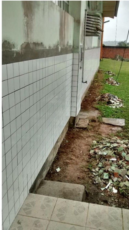
Figura 12: Revestimento cerâmico substituído. (Fonte: Dos Autores 2016)
