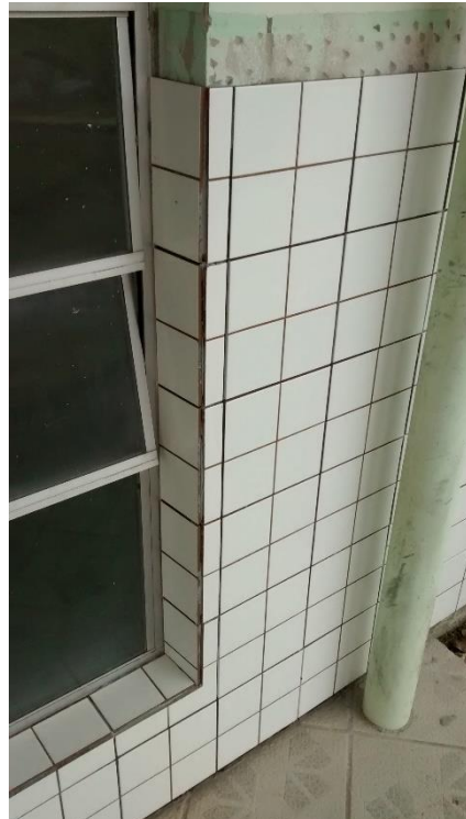
Figura 13: Revestimento cerâmico substituído. (Fonte: Dos Autores 2016)
