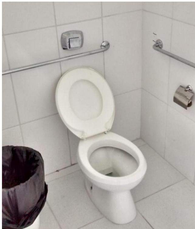
**Figura 25:** Mobília e equipamentos de auxílio no banheiro para PNE. (Fonte: Dos Autores 2016)
