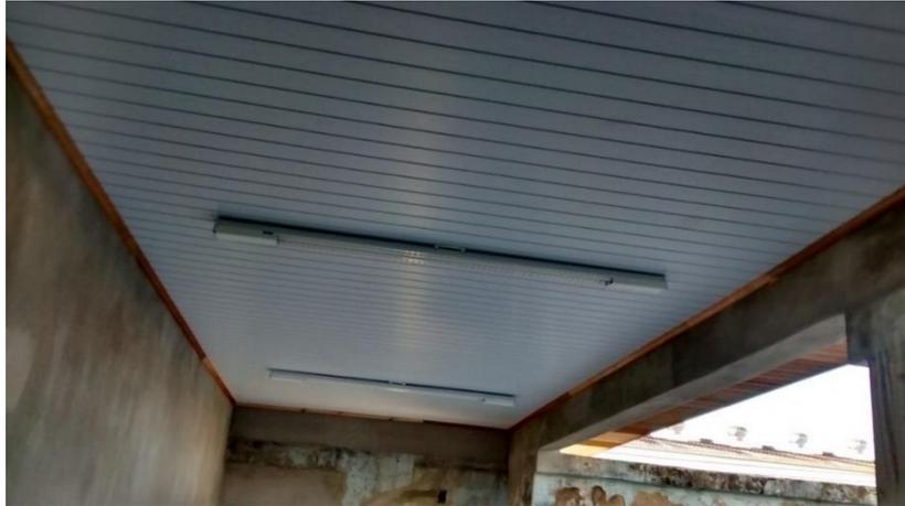
**Figura 19:** Forro em PVC depósitos. (Fonte: Dos Autores 2016)
