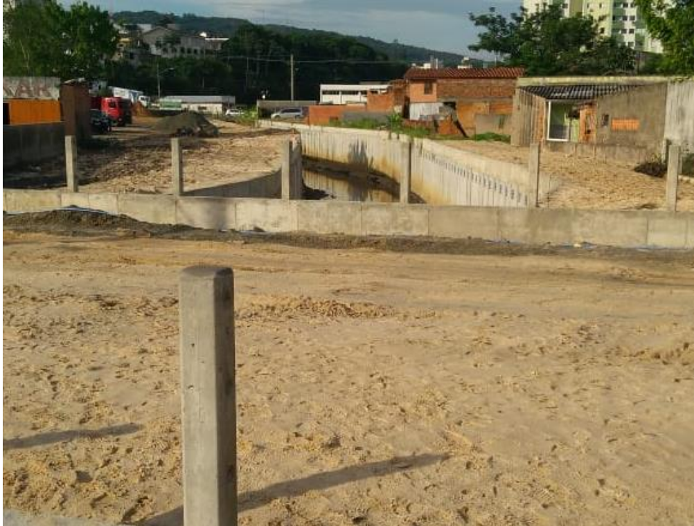
Figura 8: Prolongamento do canal auxiliar entre os lotes 01 e 02. (Fonte: Dos Autores 2019)
