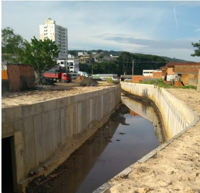
Figura 6: Prolongamento do canal auxiliar entre os lotes 01 e 02. (Fonte: Dos Autores 2019)
