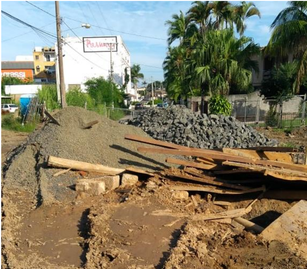
Figura 4: Materiais retirados e armazenados. (Fonte: Dos Autores 2019)
