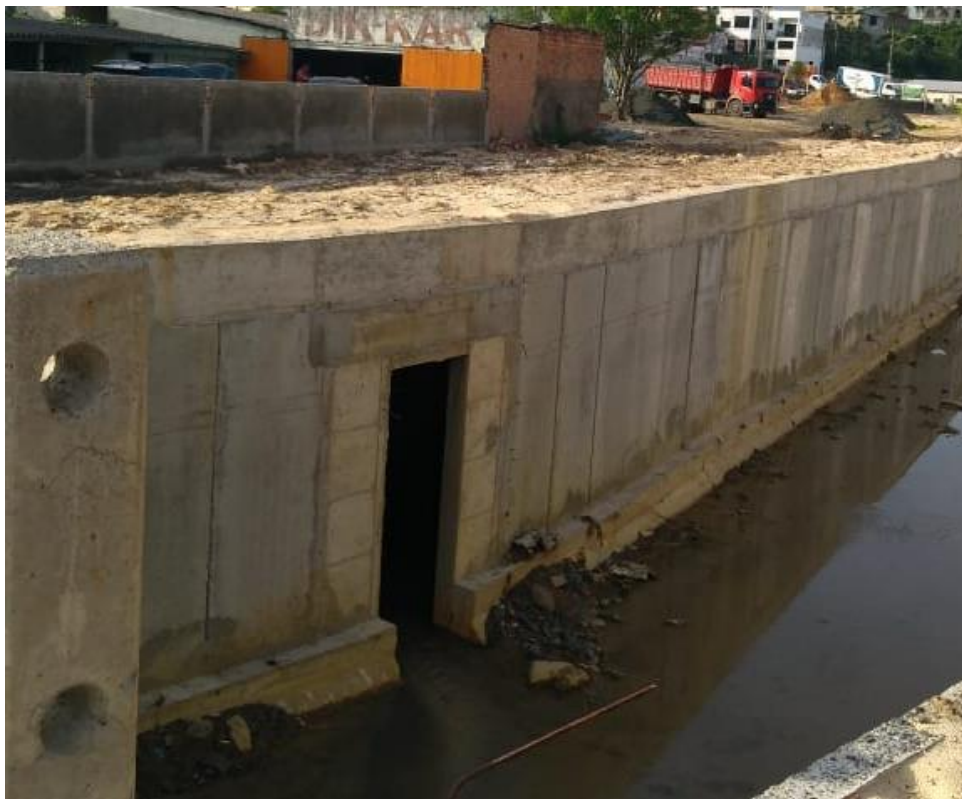
Figura 9: Trecho finalizado. (Fonte: Dos Autores 2019)
