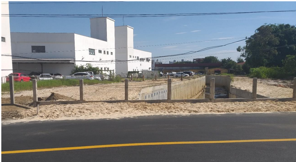
Figura 9: Grande quantidade de areia na obra (Fonte: Dos Autores 2019)
