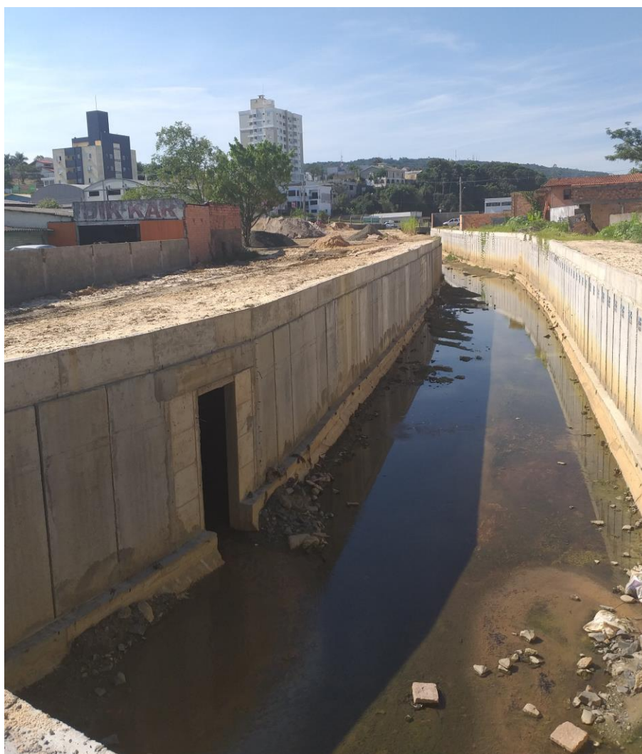
Figura 4: Trecho finalizado (Fonte: Dos Autores 2019)
