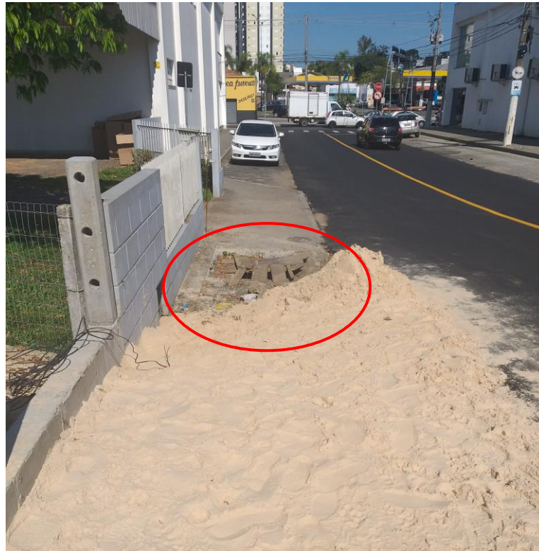
Figura 6: Passeio com areia e boca de lobo sem proteção (Fonte: Dos Autores 2019)
