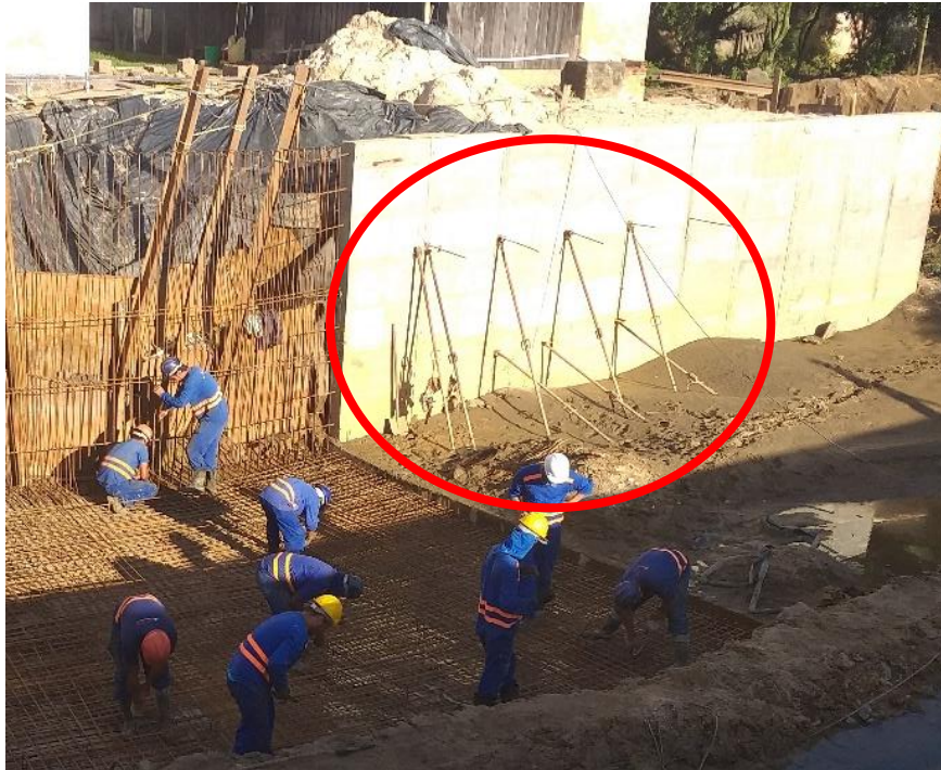
Figura 8: Escoramento. (Fonte: Dos Autores 2019)
