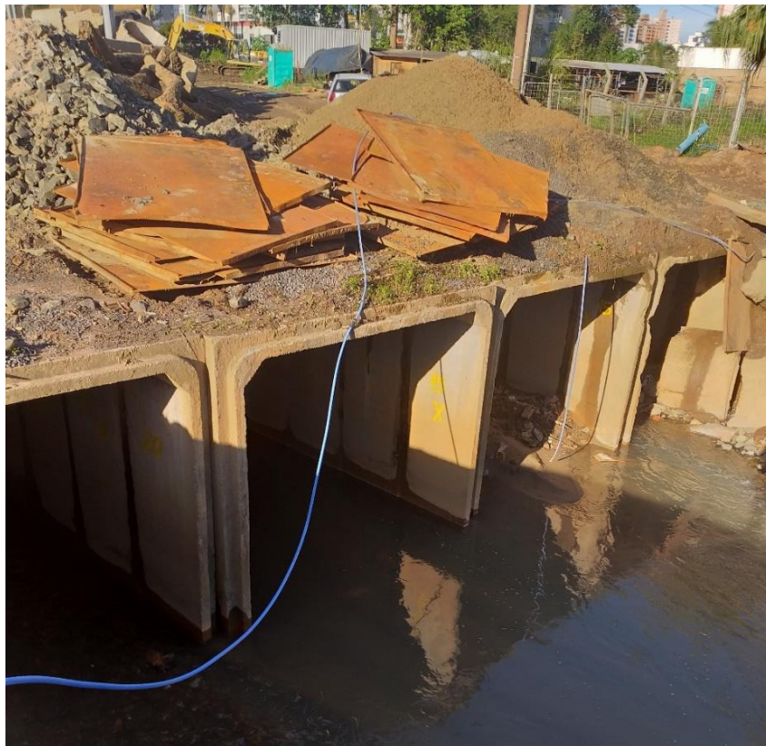
Figura 14: Aduelas na rua Ângelo Peruchi. (Fonte: Dos Autores 2019)
