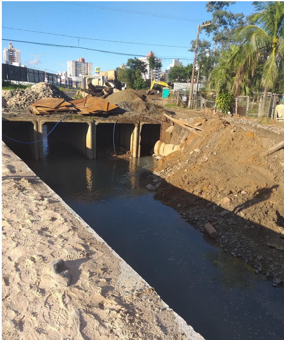
Figura 12: Aduelas na rua Ângelo Peruchi. (Fonte: Dos Autores 2019)
