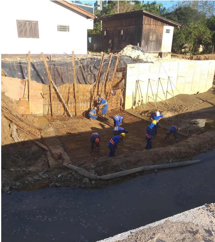
Figura 7: Trabalhadores executando a fundação radier. (Fonte: Dos Autores 2019)
