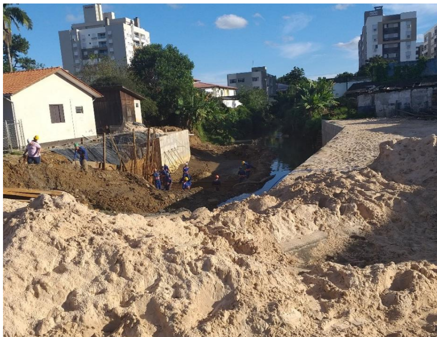
Figura 11: Trecho aterrado. (Fonte: Dos Autores 2019)
