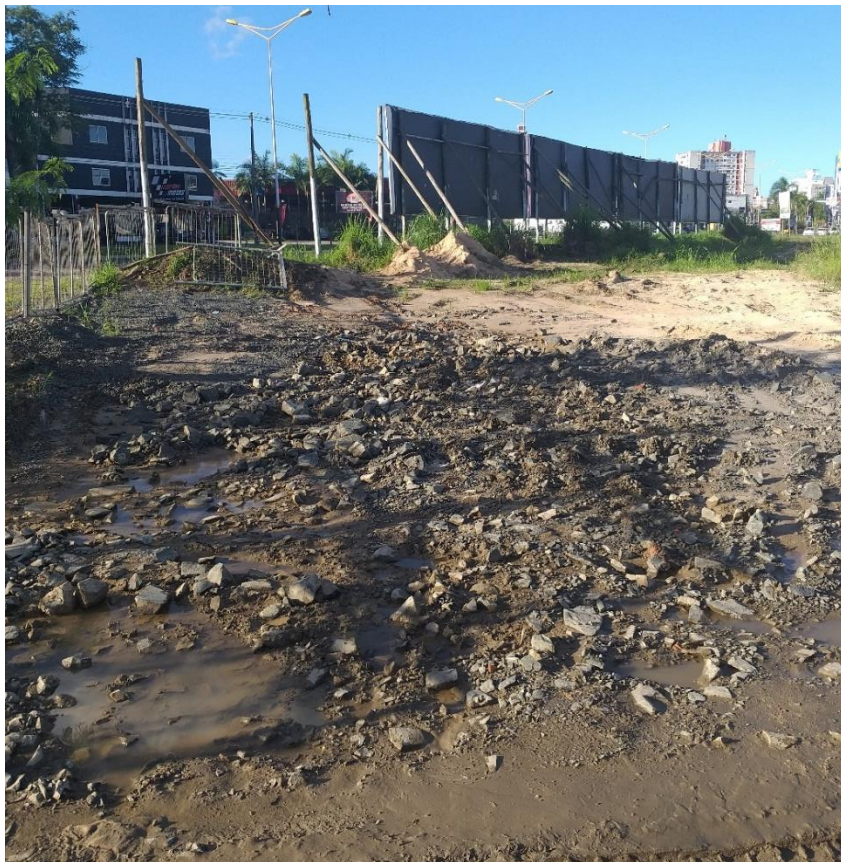
Figura 6: Obra ao lado da Avenida Centenário. (Fonte: Dos Autores 2019)
