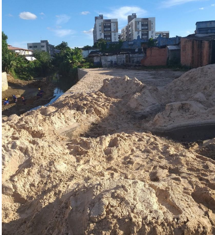
Figura 10: Trecho aterrado. (Fonte: Dos Autores 2019)
