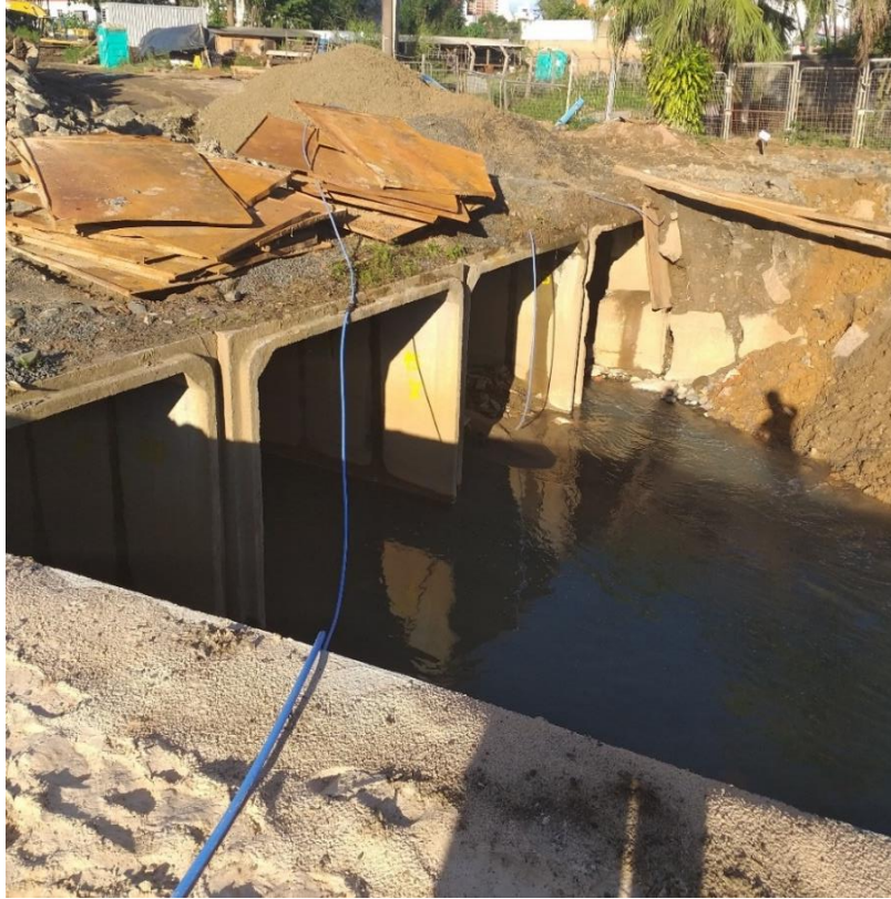
Figura 13: Aduelas na rua Ângelo Peruchi. (Fonte: Dos Autores 2019)
