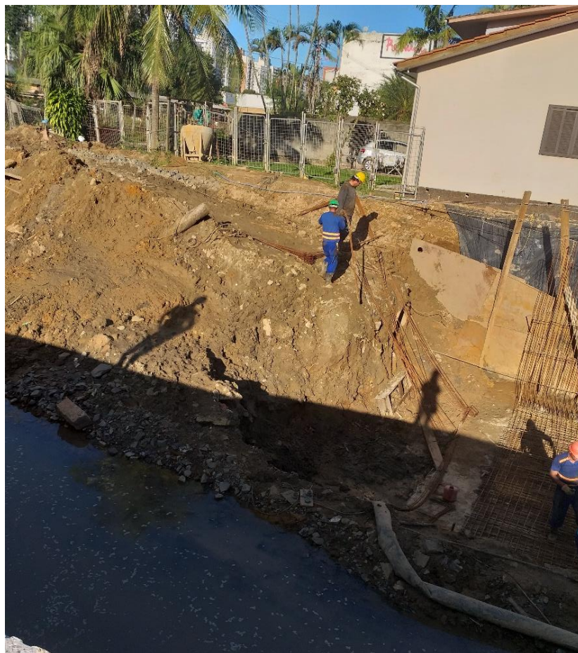
Figura 9: Trabalhadores executando a fundação radier. (Fonte: Dos Autores 2019)
