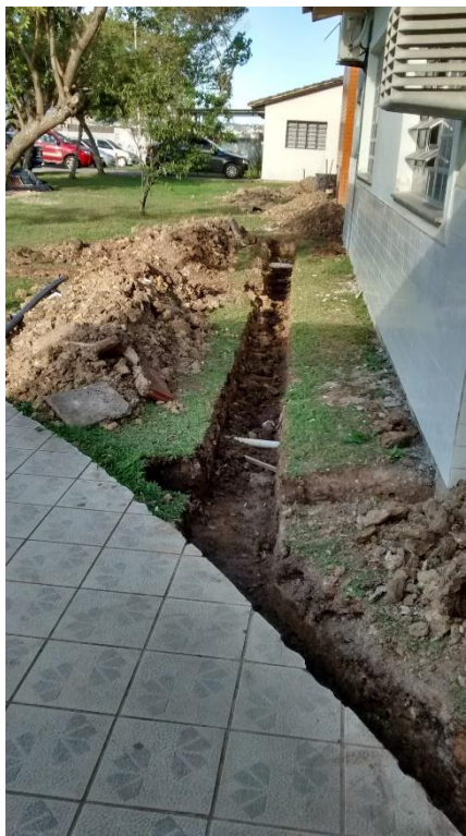
Figura 15: Escavação para instalação da estrutura do SPDA. (Fonte: Dos Autores 2016)
