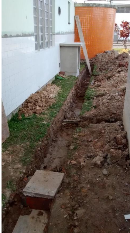
Figura 14: Escavação para instalação da estrutura do SPDA. (Fonte: Dos Autores 2016)
