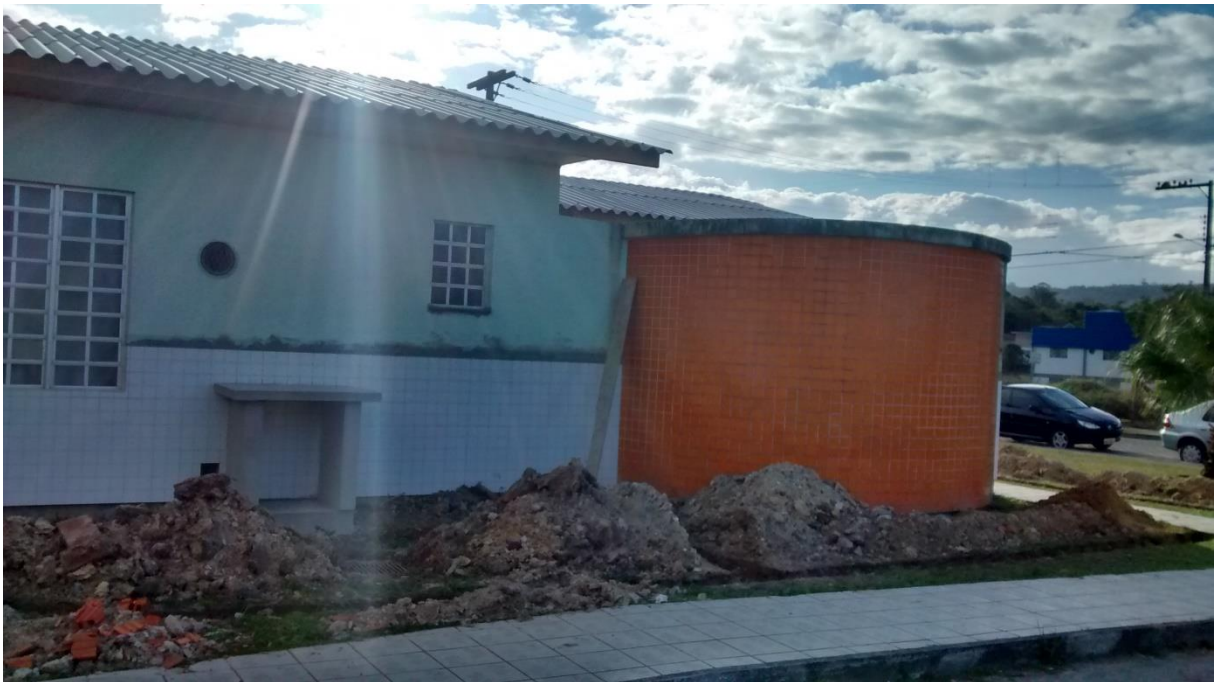
Figura 17: Escavação para instalação da estrutura do SPDA. (Fonte: Dos Autores 2016)
