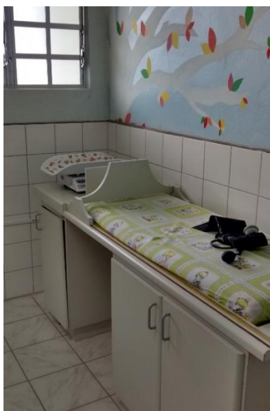
Figura 08: Revestimento cerâmico interno. (Fonte: Dos Autores 2016)
