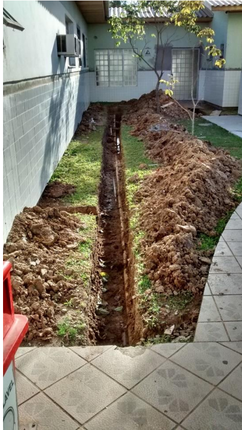
Figura 16: Escavação para instalação da estrutura do SPDA. (Fonte: Dos Autores 2016)
