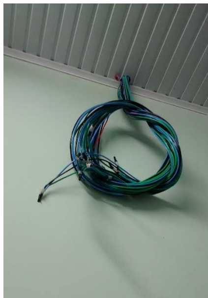
Figura 23: Outros trabalhos em andamento. (Fonte: Dos Autores 2016)
