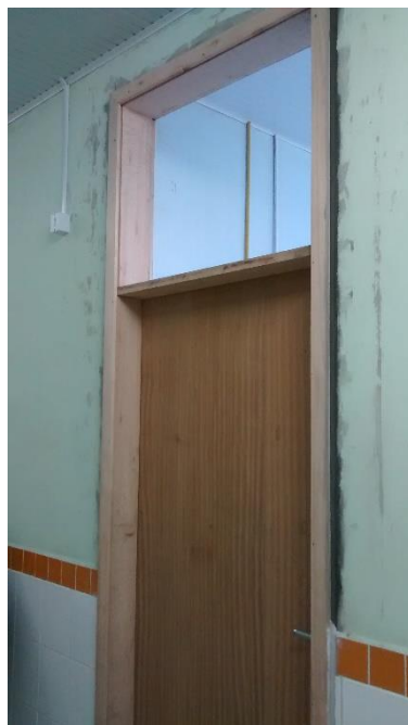
Figura 12: Detalhe da janela na parte superior das portas instaladas. (Fonte: Dos Autores 2016)
