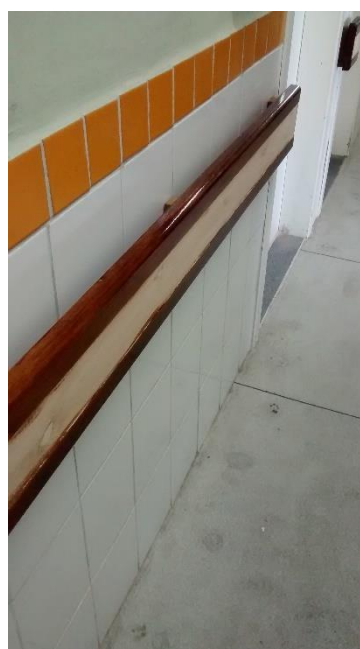
Figura 11: Bate-maca em processo de instalação. (Fonte: Dos Autores 2016)
