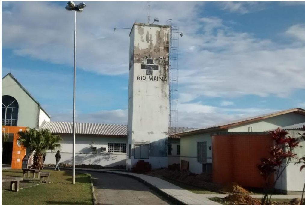
Figura 06: Policlínica do Rio Maina vista frontal. (Fonte: Dos Autores 2016)
