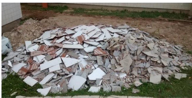
Figura 15: Resíduos de obra depositados no pátio. (Fonte: Dos Autores 2016)
