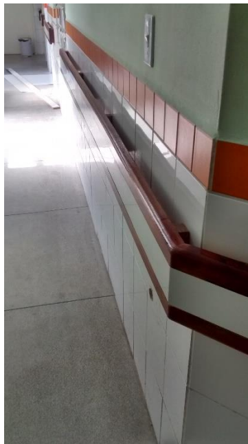
Figura 08: Bate-maca instalado. (Fonte: Dos Autores 2016)
