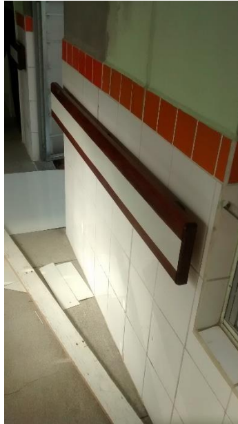
Figura 07: Bate-maca instalado. (Fonte: Dos Autores 2016)
