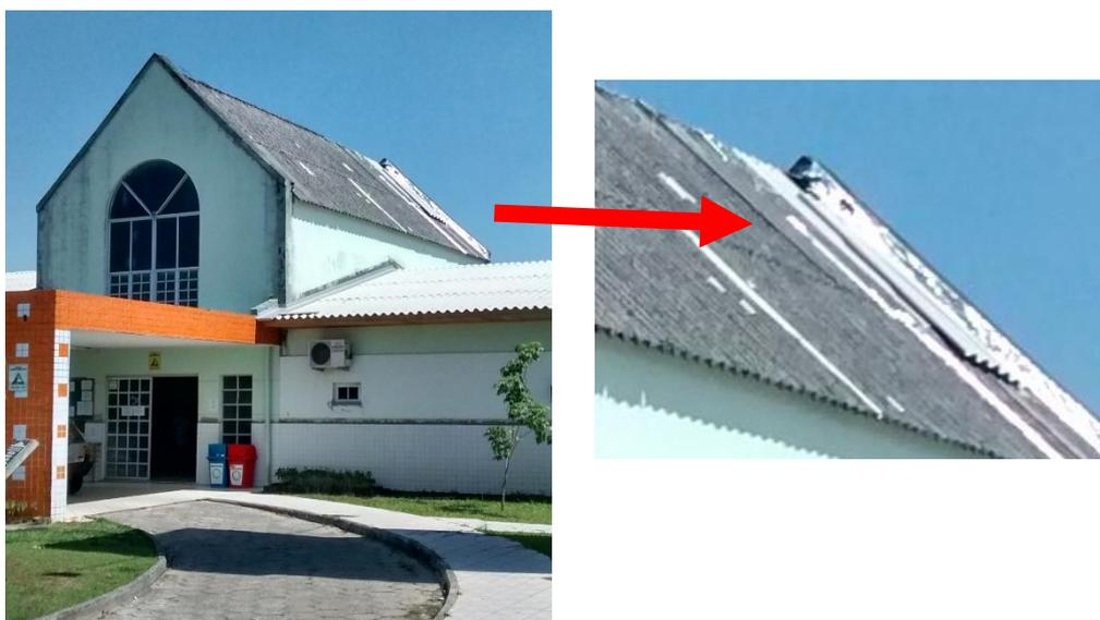
**Figura 06:** Detalhe do telhado danificado. (Fonte: Dos Autores 2016)
