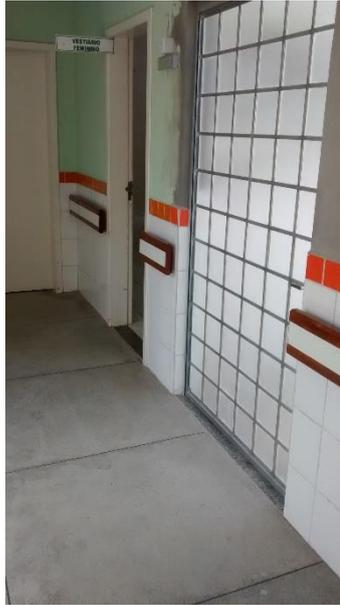
**Figura 09:** Bate-maca instalado. (Fonte: Dos Autores 2016)
