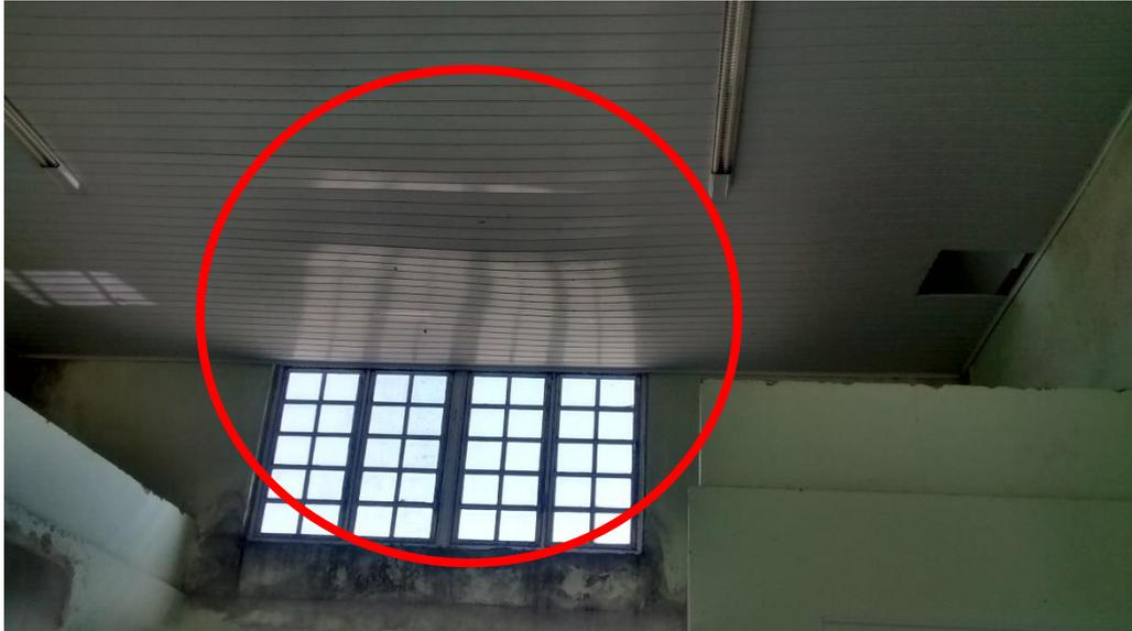
**Figura 07:** Detalhe do rebaixamento do forro de PVC. (Fonte: Dos Autores 2016)
