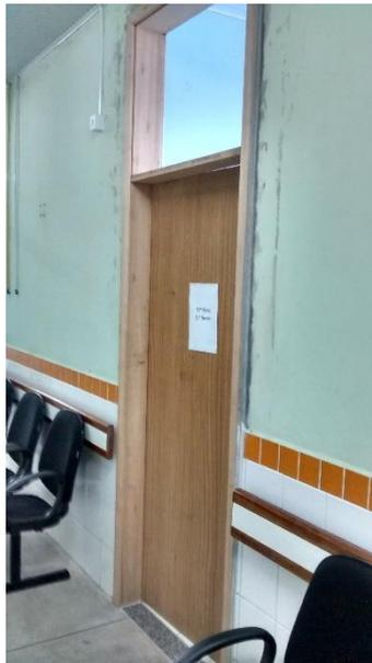
**Figura 10:** Bate-maca instalado. (Fonte: Dos Autores 2016)
