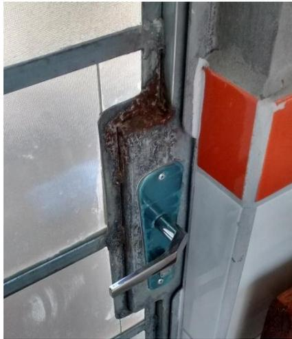
**Figura 11:** Detalhe da oxidação nas portas. (Fonte: Dos Autores 2016)
