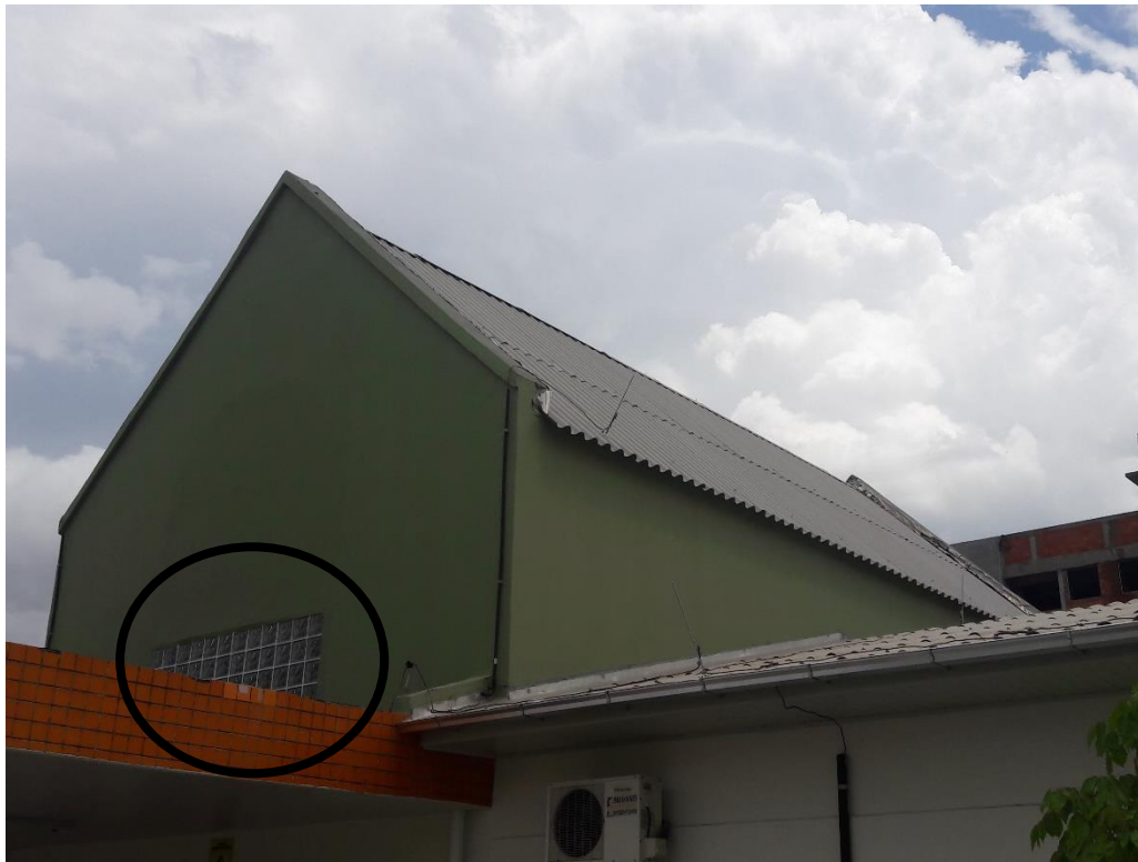
Figura 6: Pintura realizada e tijolo de vidro assentado (Fonte: Autores)
