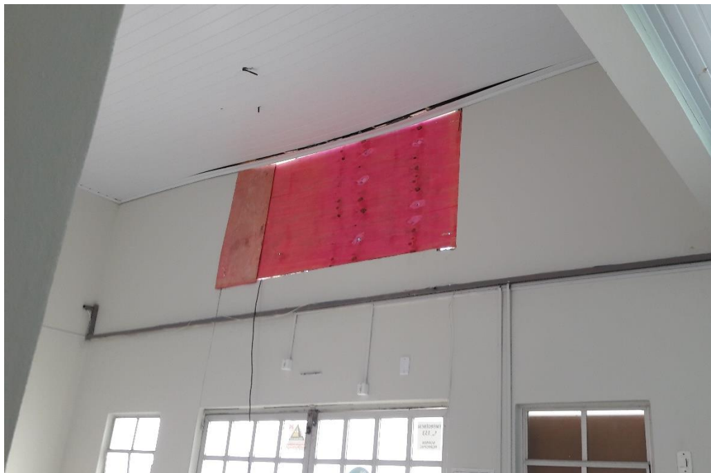
Figura 7: Abertura coberta com madeira (Fonte: Autores)
