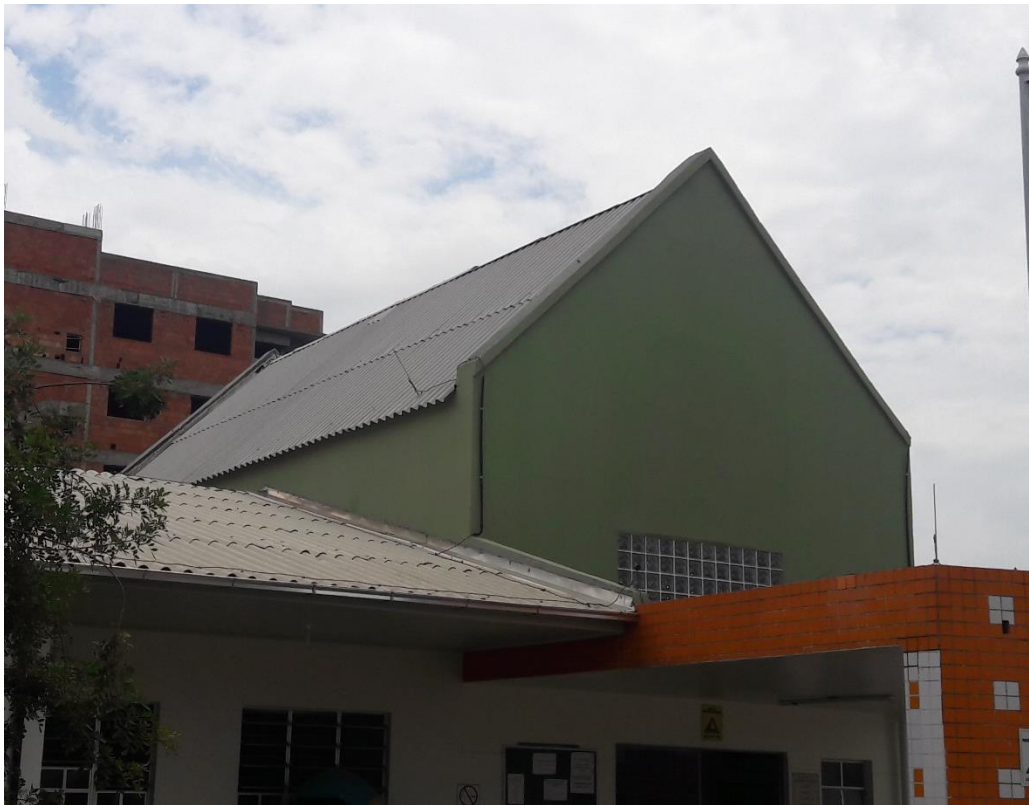
Figura 5: Cobertura finalizada (Fonte: Autores)
