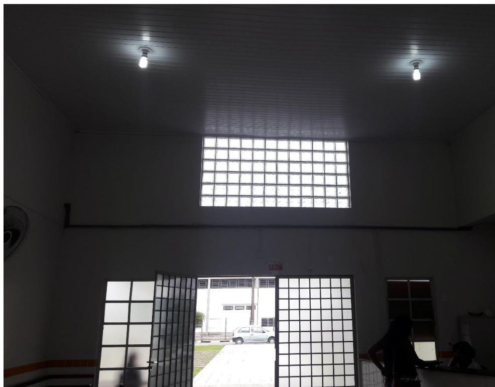
Figura 8: Abertura pronta com tijolo de vidro (Fonte: Autores)
