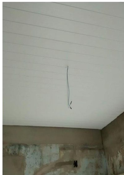
Figura 12: Instalação da cobertura em PVC. (Fonte: Dos Autores 2016)
