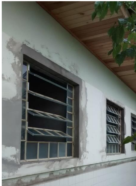
Figura 16: Janela instalada. (Fonte: Dos Autores 2016)
