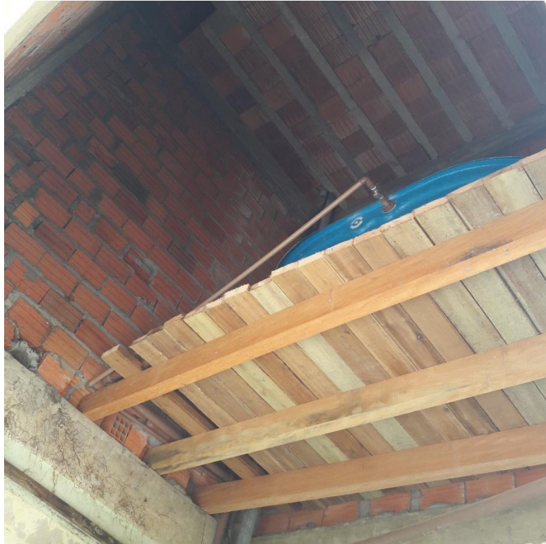
Figura 23: Caixa d'água provisória. (Fonte: Dos Autores)
