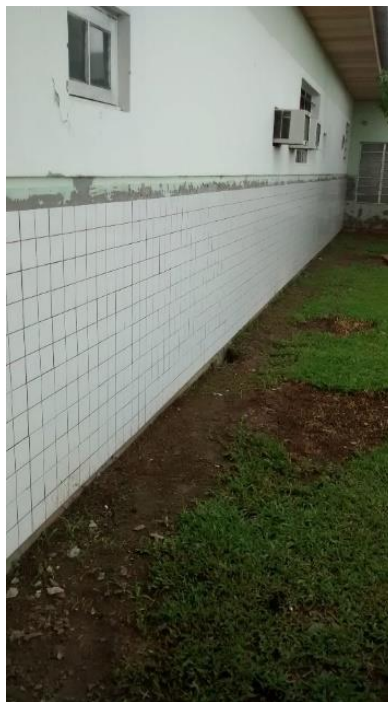
Figura 10: Revestimento cerâmico substituído. (Fonte: Dos Autores 2016)
