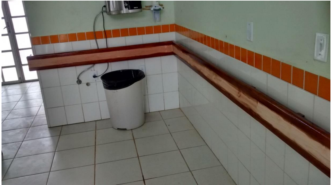
Figura 19: Bate-maca em processo de instalação. (Fonte: Dos Autores 2016)
