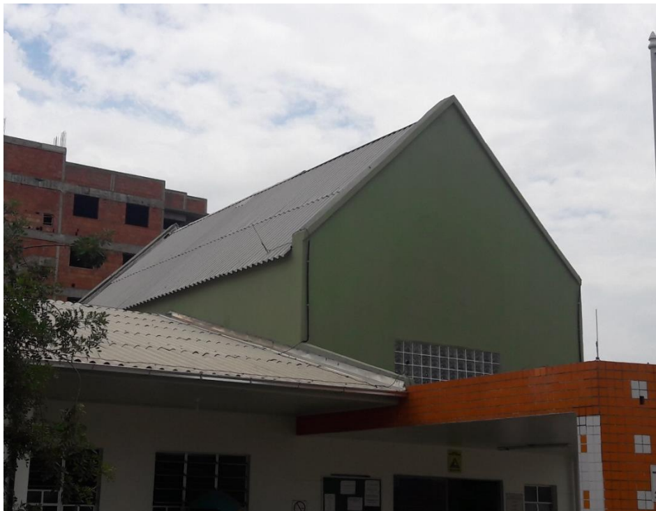
Figura 25: Cobertura finalizada (Fonte: Autores)
