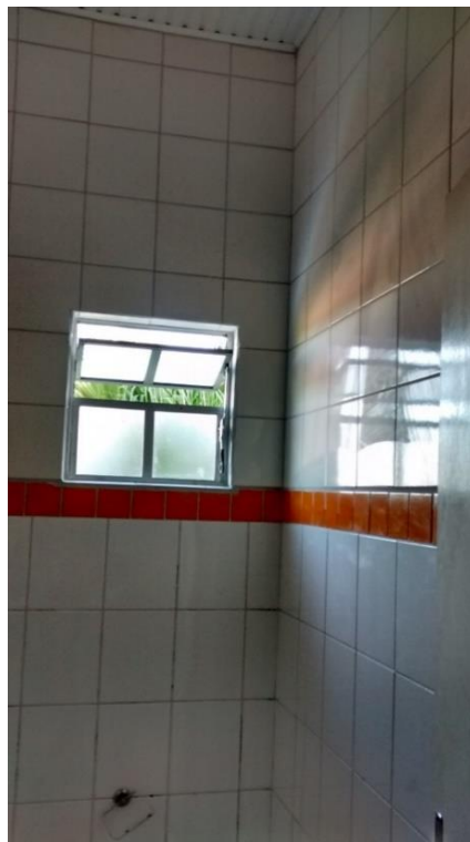
Figura 13: Revestimento cerâmico banheiro até o teto. (Fonte: Dos Autores 2016)
