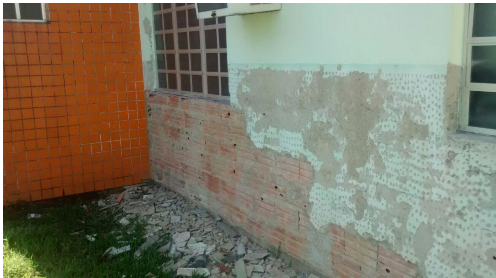
Figura 8: Revestimento da parede sendo retirado. (Fonte: Dos Autores 2016)
