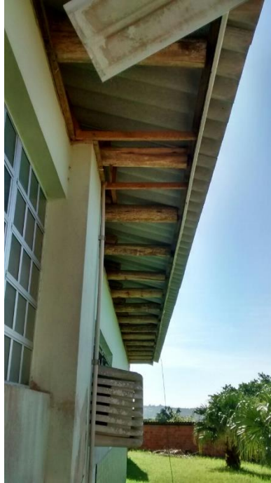
Figura 7: Beiral do prédio retirado. (Fonte: Dos Autores 2016)
