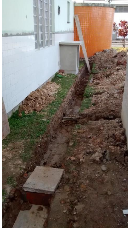
Figura 18: Escavação para instalação da estrutura do SPDA. (Fonte: Dos Autores 2016)
