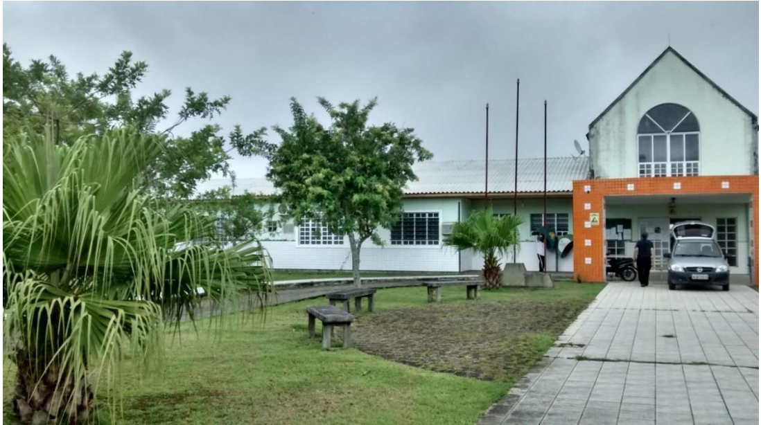
Figura 9: Telhado da policlínica substituído. (Fonte: Dos Autores 2016)
