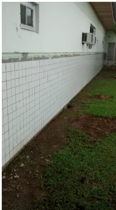
Figura 10: Revestimento cerâmico substituído. (Fonte: Dos Autores 2016)
