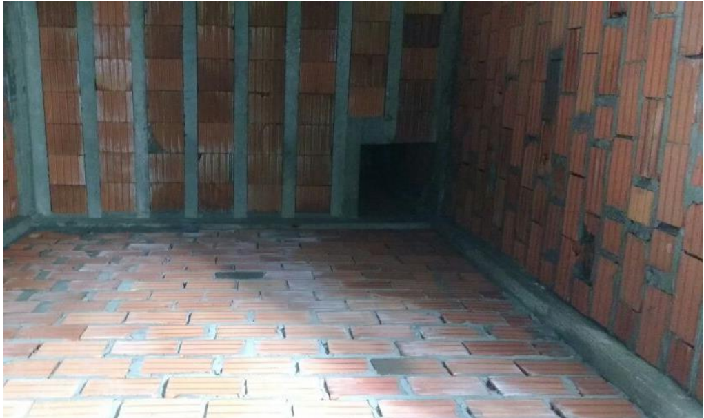
Figura 38: Blocos cerâmicos umedecidos. (Fonte: Dos Autores 2018)
