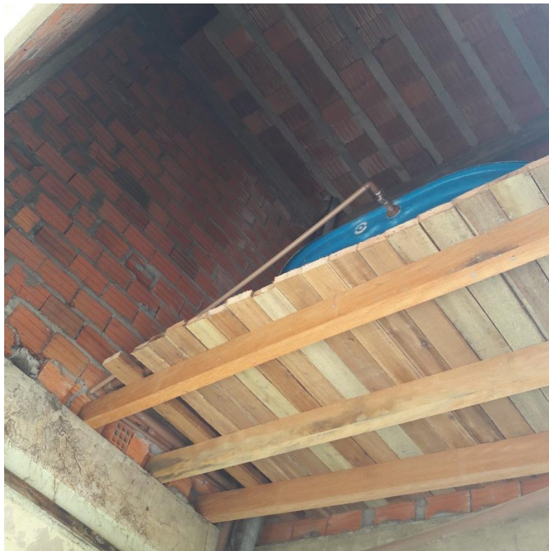
Figura 23: Caixa d'água provisória. (Fonte: Dos Autores)
