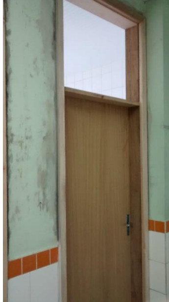
Figura 17: Porta de um dos consultórios substituída. (Fonte: Dos Autores 2016)
