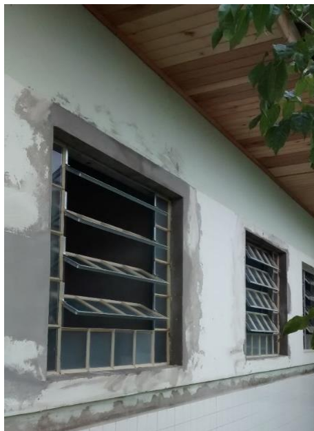
Figura 16: Janela instalada. (Fonte: Dos Autores 2016)
