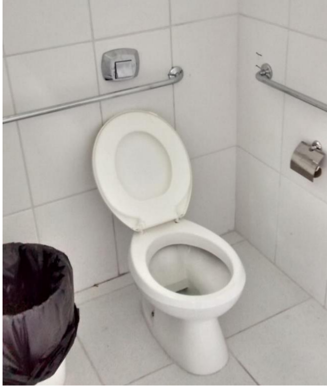
Figura 14: Mobília e equipamentos de auxílio no banheiro para PNE. (Fonte: Dos Autores 2016)
