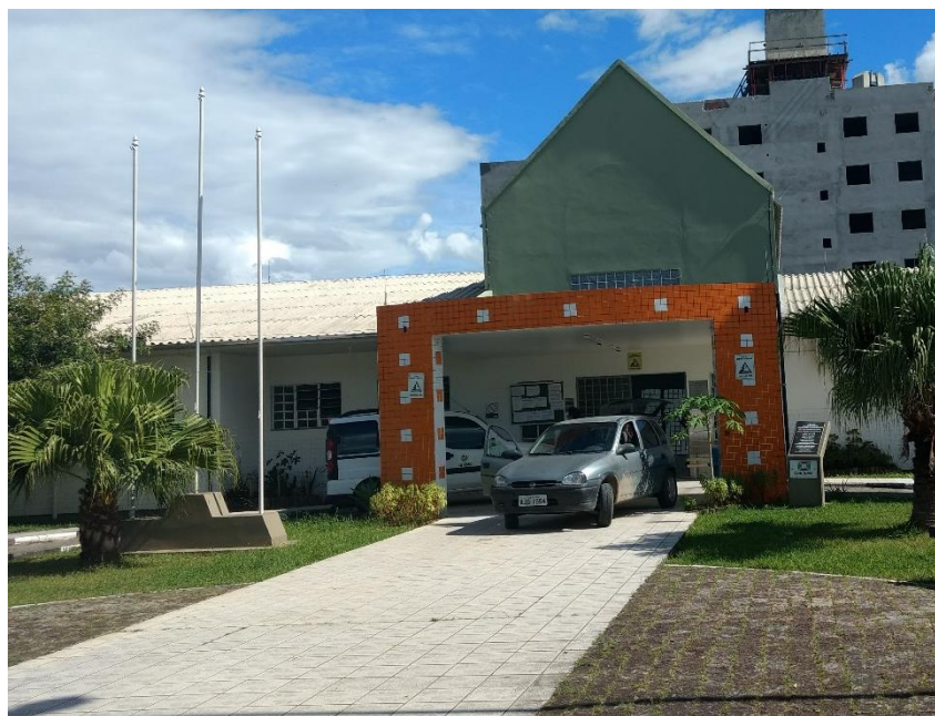
Figura 4: Vista frontal da Unidade. (Fonte: Dos Autores)
