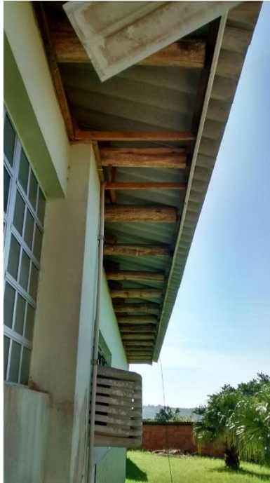
Figura 7: Beiral do prédio retirado. (Fonte: Dos Autores 2016)
